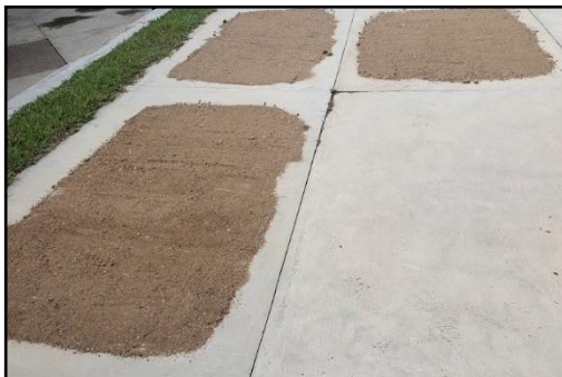
Imagen3.2 Extendido de la arena
