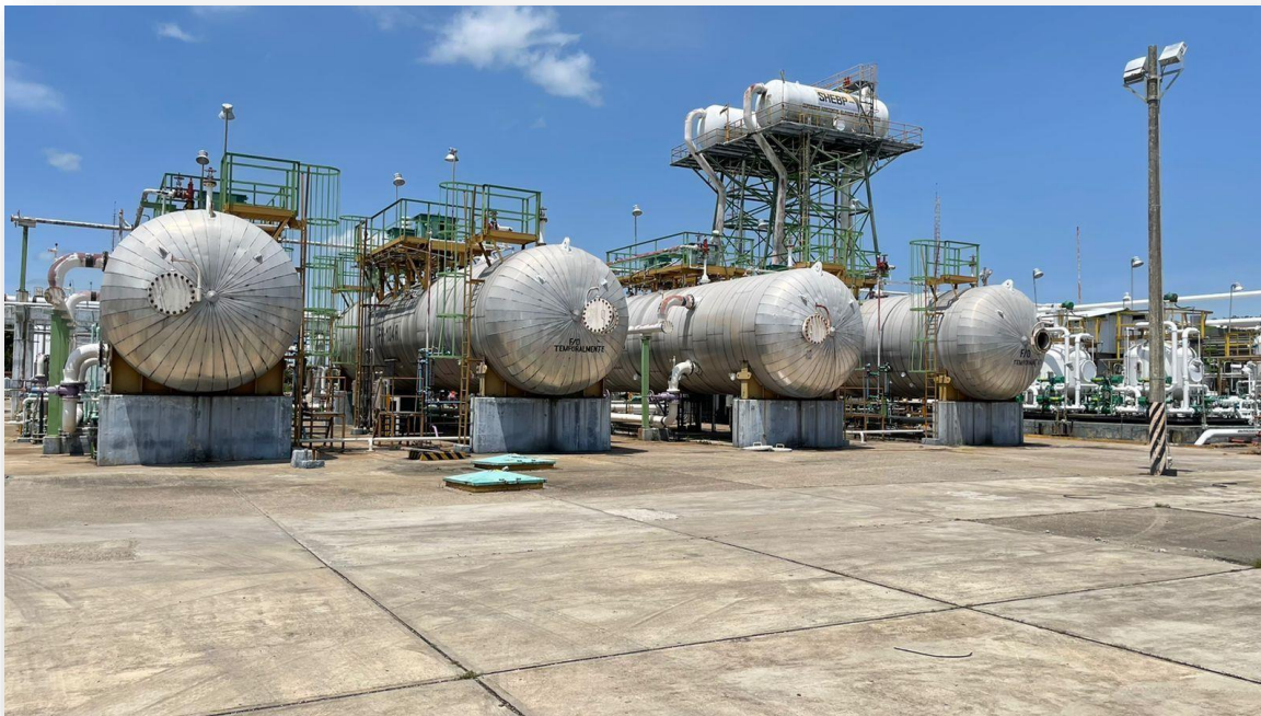
Fig. 5. Vasijas desaladoras y deshidratadoras de crudo en la planta Bs Bellota Jujo en Huimanguillo Tabasco.
