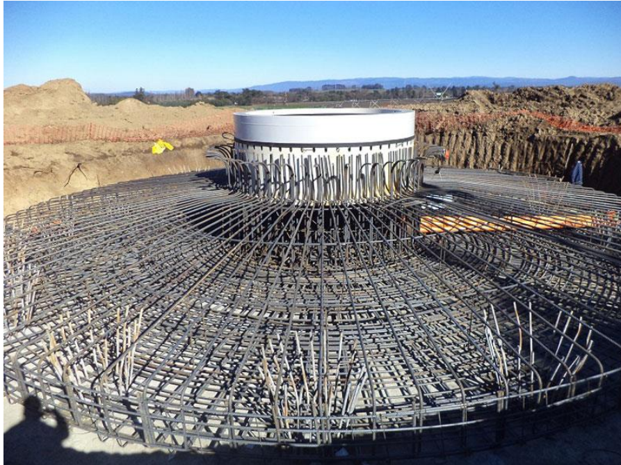
Ilustración 19. Cimentación para la construcción del aerogenerador
