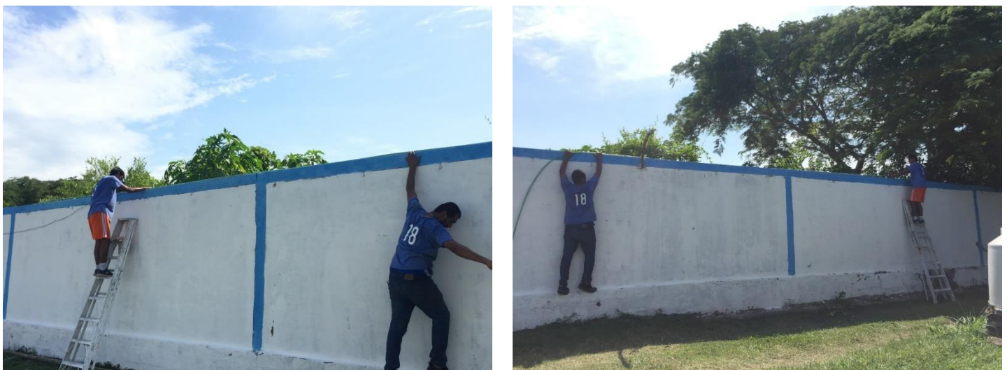
Imagen 20. Colocación de cableado.
