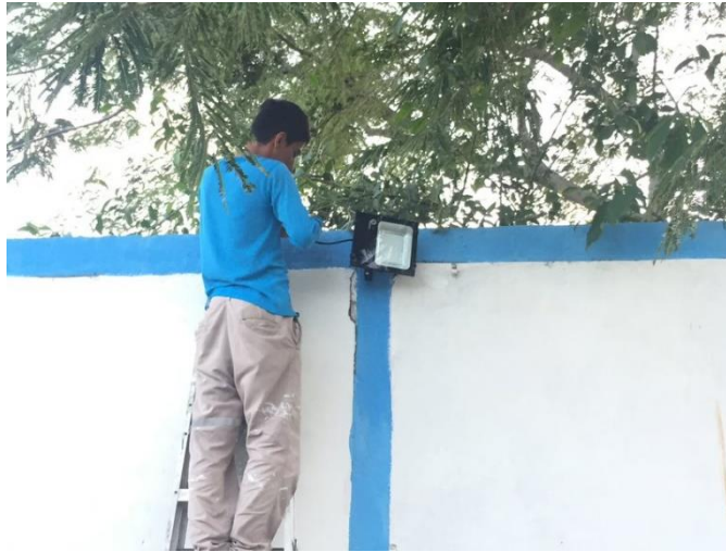
Imagen 21. Colocación de reflectores Led.
