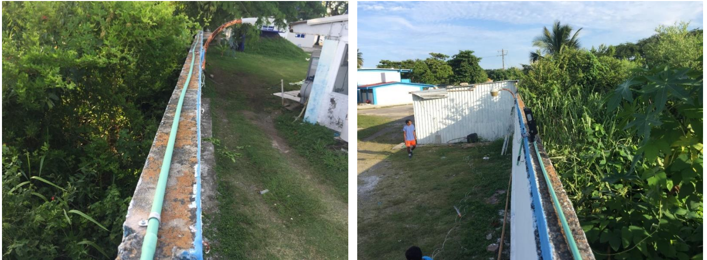
Imagen 19. Colocación de tubería Conduit.
