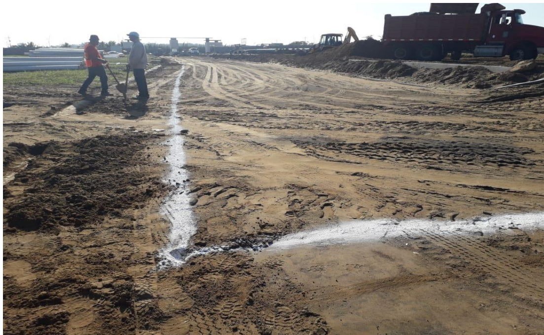
Foto 27.- En la imagen se muestra el trazo de acuerdo a la información indicada en el proyecto, el cual se toma como referencia para las excavaciones.
