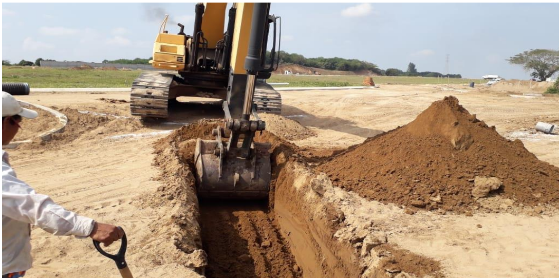
Foto 2.- Como se muestra en la imagen, las excavaciones se estuvieron llevando a cabo con la excavadora.
