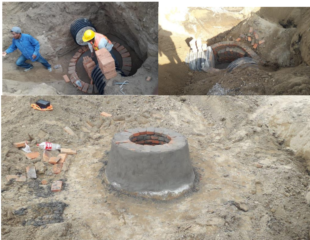
Foto 9.- Se colocaron y pegaron los ladrillos, hasta llegar a la altura que marca el proyecto, posteriormente se repella.
