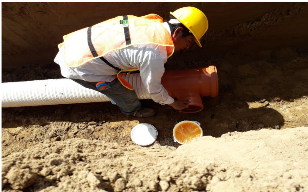
Foto 16.- También se llevó a cabo la colocación de las piezas Tee-Yee para las descargas correspondiente a cada uno de los lotes marcando en las guarniciones su ubicación para posteriormente hacer las descargas sanitarias.
