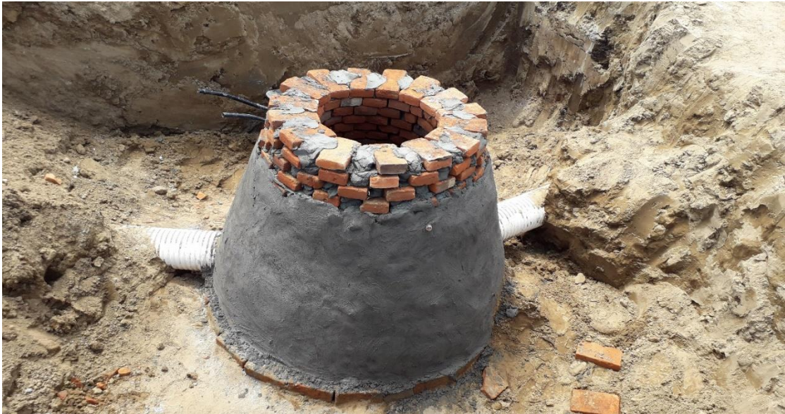
Foto 26.- Posteriormente se repella, se le dejaron 3 hiladas extra de ladrillo para evitar que se llenen de material. Se rellena la excavación hecha y así permanece hasta tener preparada la calle para pavimentar, entonces se coloca la tapa.
