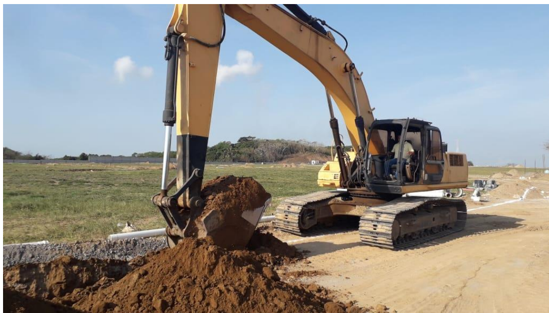
Foto 37.- Como se muestra en la imagen, las excavaciones se estuvieron llevando a cabo con la excavadora.
