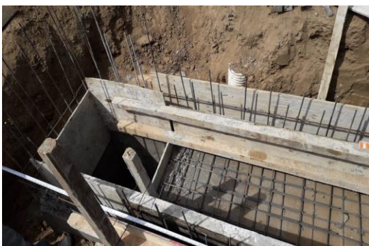
Foto 12.- Una vez teniendo la caja se pasa a cimbrar y a colar el colector, con las medidas y pendiente especificadas en los planos del proyecto.
