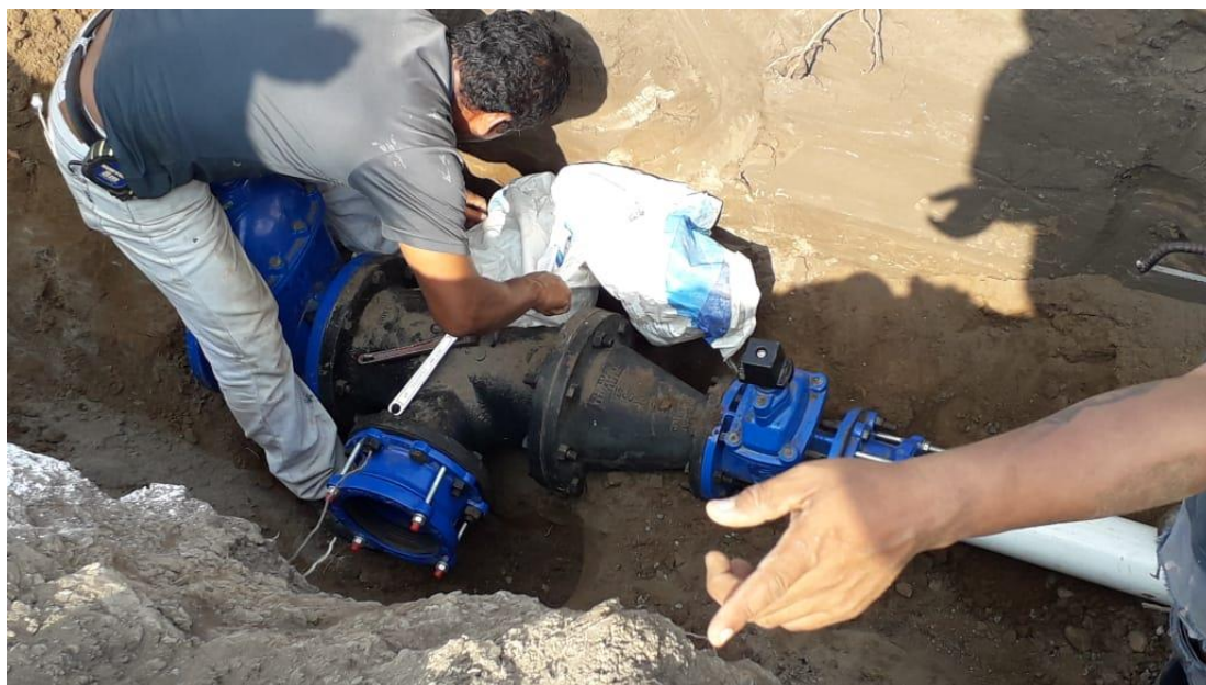
Foto 39.- Se llevaron a cabo los cruces y la instalación de las piezas especiales y válvulas.
