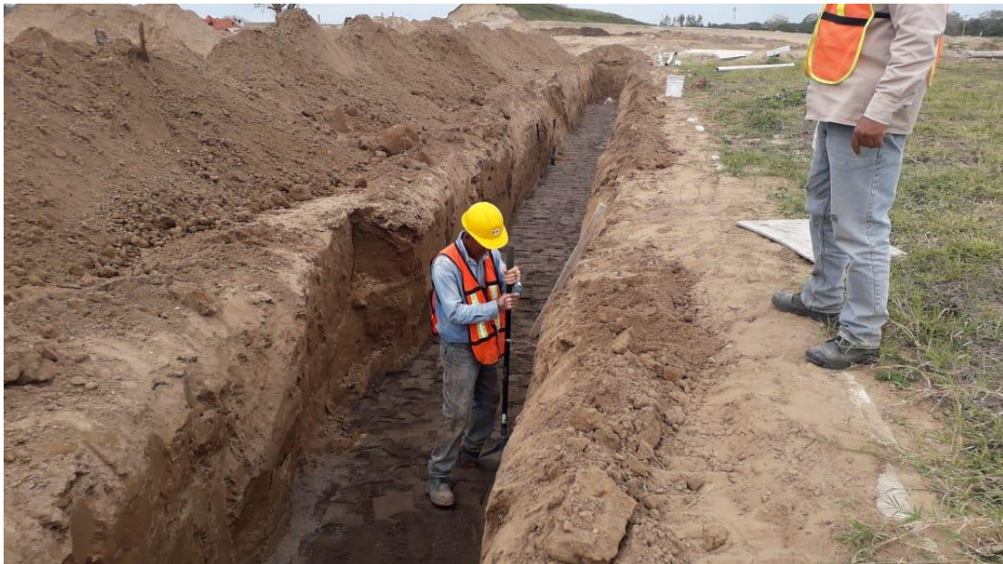
Foto 30.- Se acostilló y apisonó la tubería para evitar que esta se mueva.
