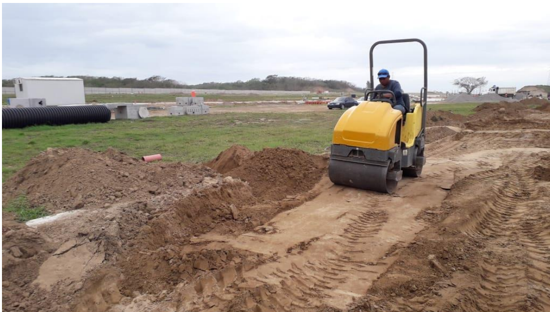
Foto 22.- Se compactó el relleno de la cepa.
