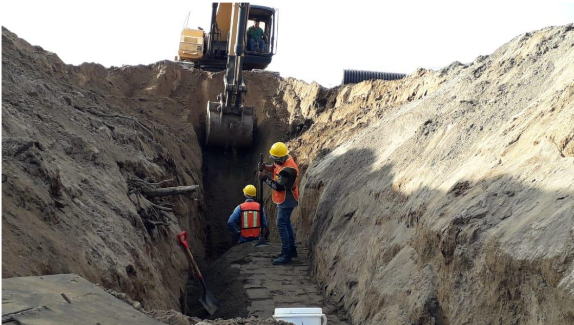
Foto 4.- Se acostilló y apisonó la tubería para evitar que se mueva con arena de médano.
