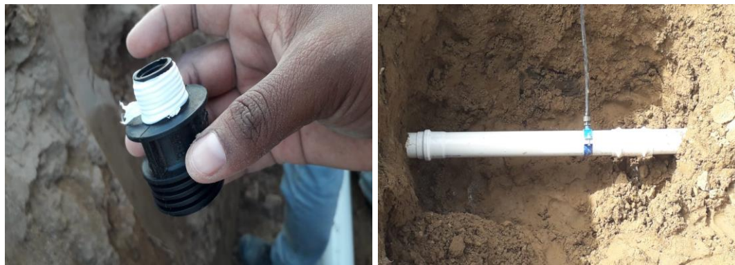
Foto 34.- Se usó cinta teflón en el adaptador macho para mejorar el sello en la abrazadera y se conectó la manguera de ½ “.
