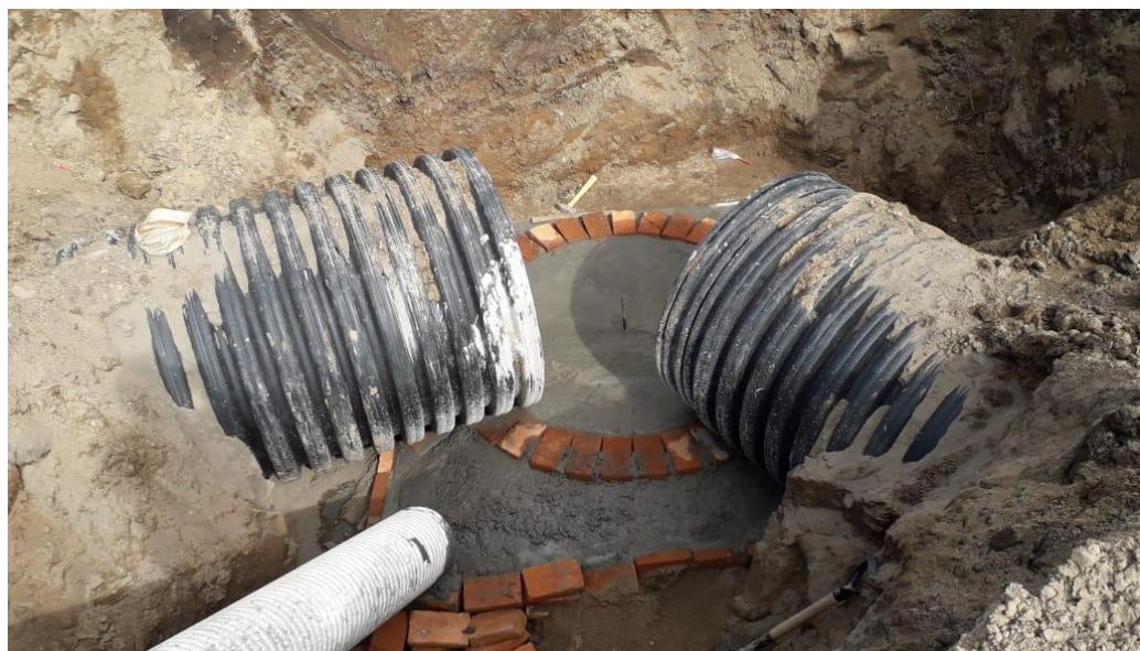
Foto 8.- Se coló la plantilla de 20 cm, se dejó fraguar y posteriormente se inició con el pegado de tabiques.
