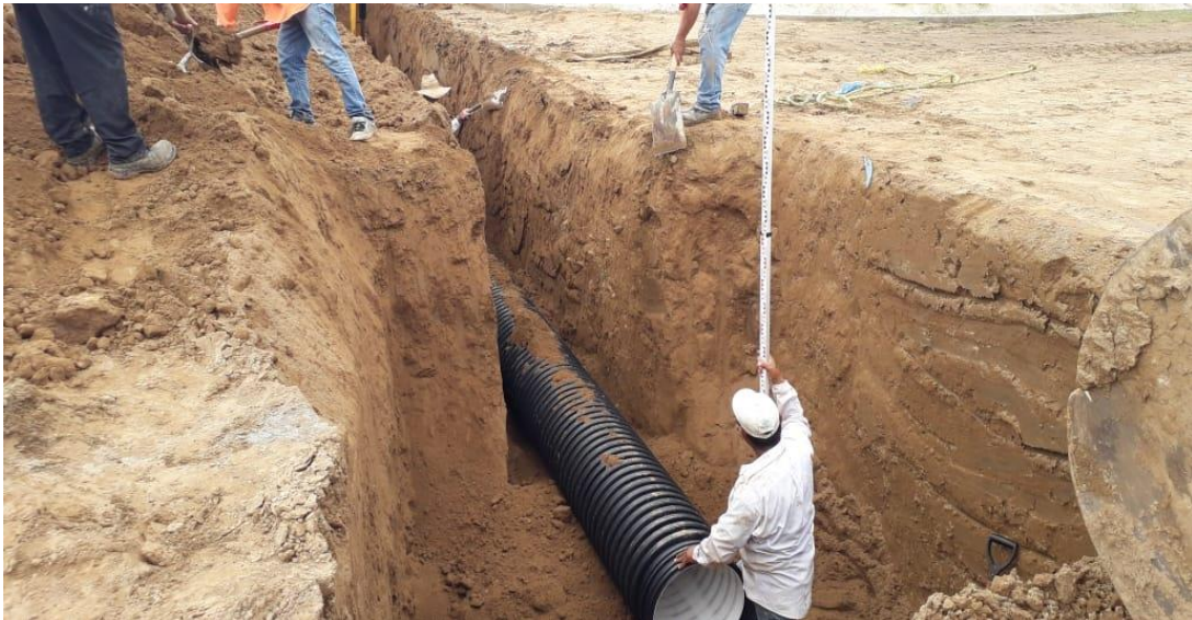
Foto 3.- Se comenzó con la colocación de tubos con los niveles correspondientes.
