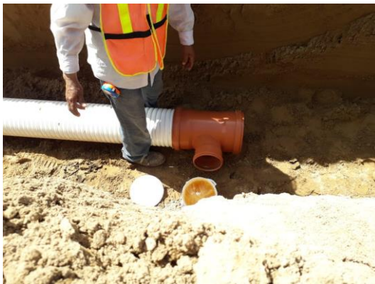
Foto 15.- Se comenzó con la colocación de tubos con diámetros de acuerdo al proyecto con los niveles correspondientes.
