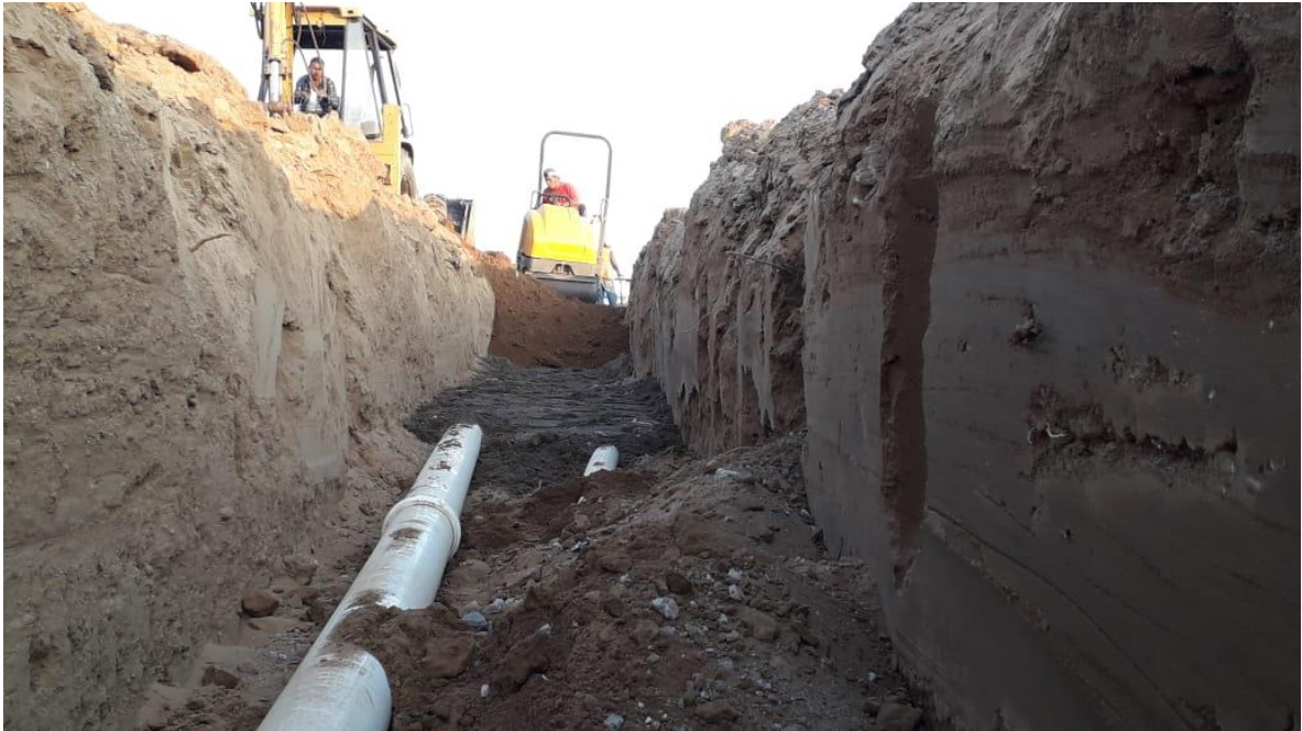
Foto 41.- Se rellenó la cepa y se compactó por capas con el mini rodillo.
