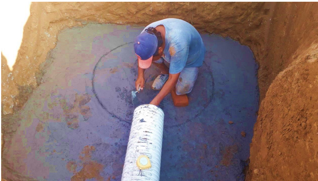
Foto 24.- Se lleva a cabo el colado de la plantilla para la base.
