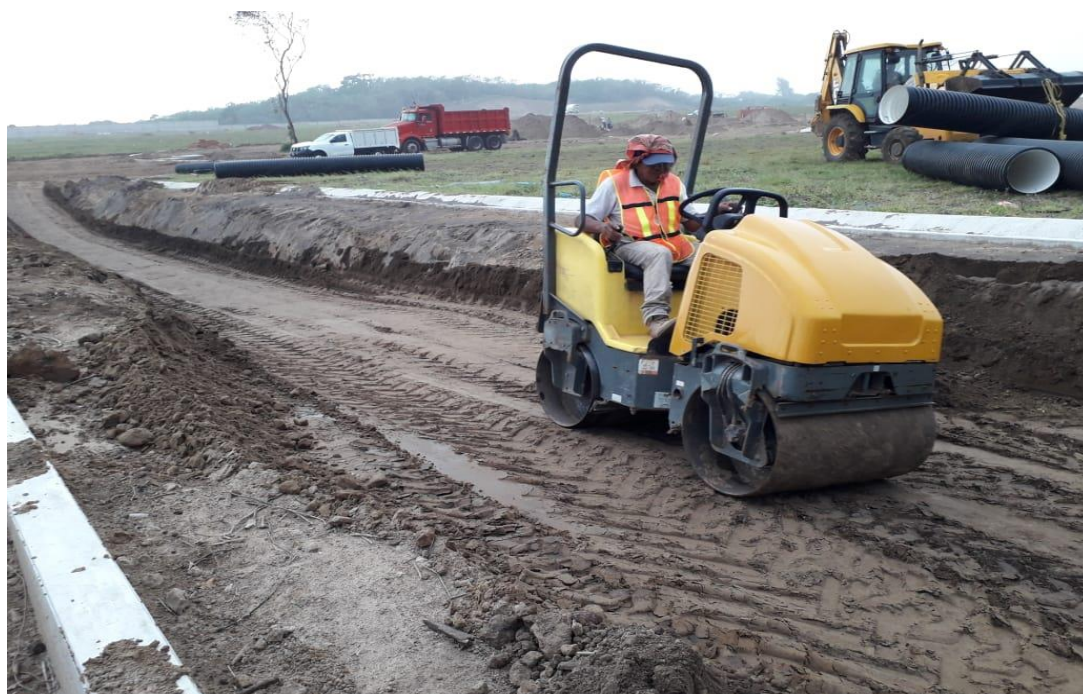
Foto 6.- Se compactó con un mini rodillo.
