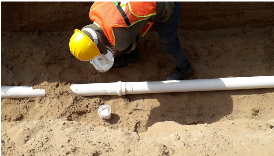
Foto 29.- Se comenzó con la colocación de tubos con los niveles correspondientes.
