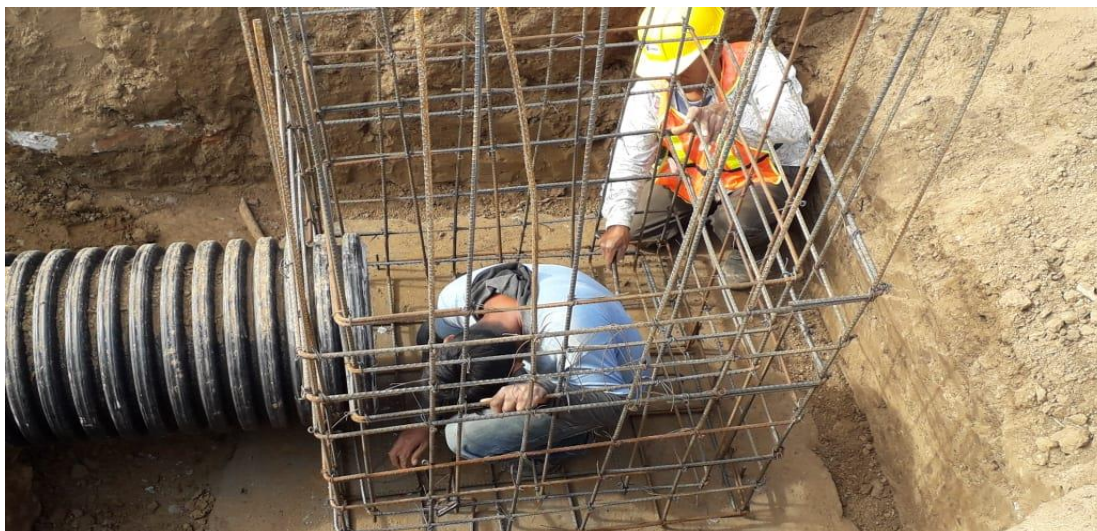
Foto 10.- Para la construcción de un traga tormenta, se inicia con el mismo procedimiento que la elaboración de un pozo, el cual consiste en apisonar y colocar una plantilla de 20 cm para desplantarse. Posteriormente colocan el armado para la caja.
