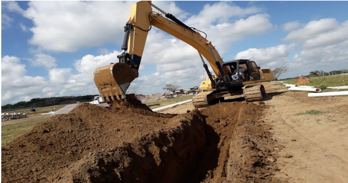
Foto 28.- Como se muestra en la imagen, las excavaciones se estuvieron llevando a cabo con la excavadora.
