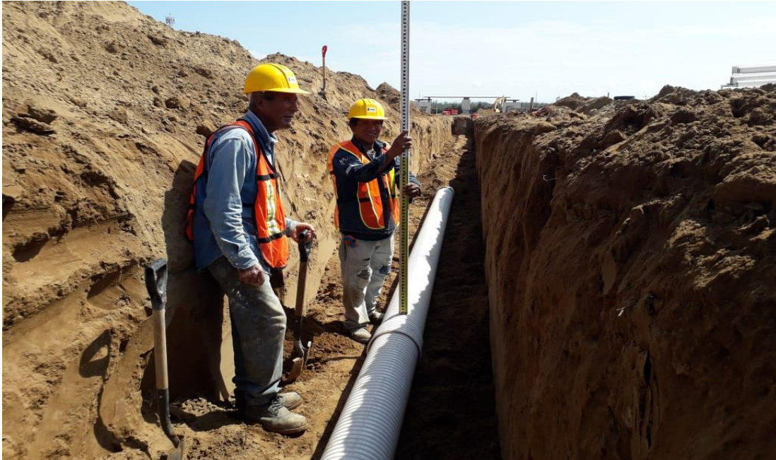
Foto 15.- Se comenzó con la colocación de tubos con diámetros de acuerdo al proyecto con los niveles correspondientes.
