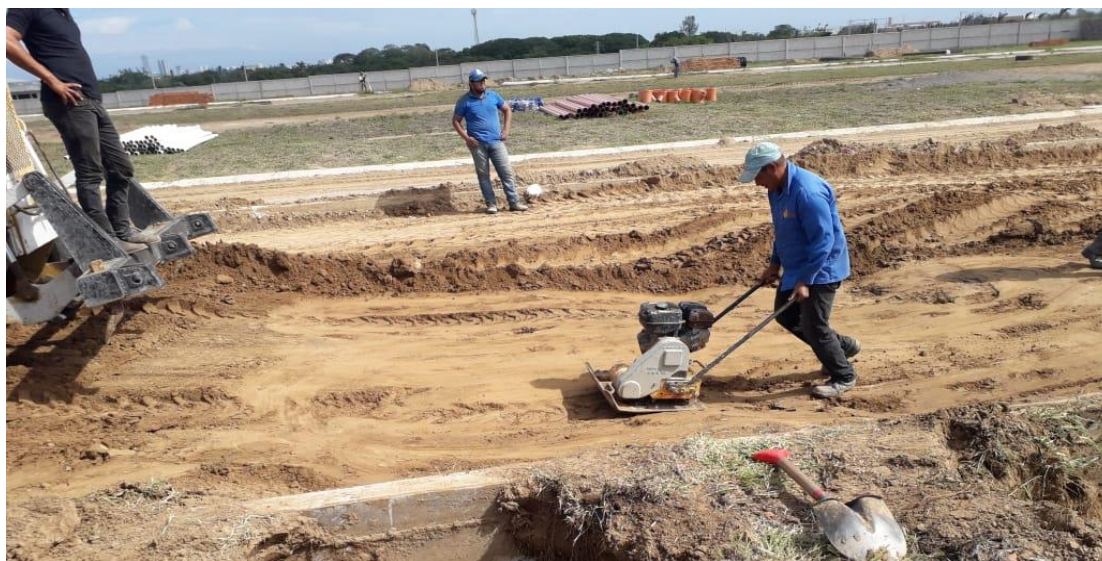
Foto 35.- Finalmente se cubre el área primero con arena limpia para evitar daños, posteriormente se rellenan las cepas y se compacta en este caso con una plancha vibratoria.
