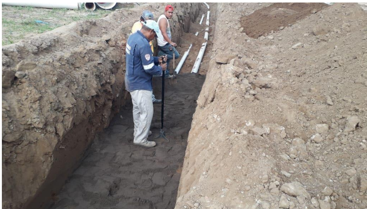
Foto 40.- Se acostilló y apisonó la tubería para evitar que esta se mueva. En este tramo coincidía con la línea de agua potable y se aprovechó la zanja para ambas líneas.
