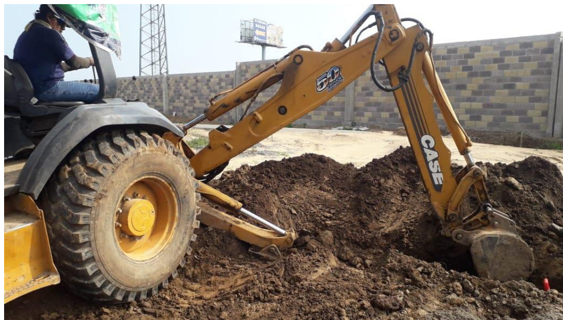
Foto 19.- Se llevo a cabo la excavación desde la línea principal hacia los lotes.
