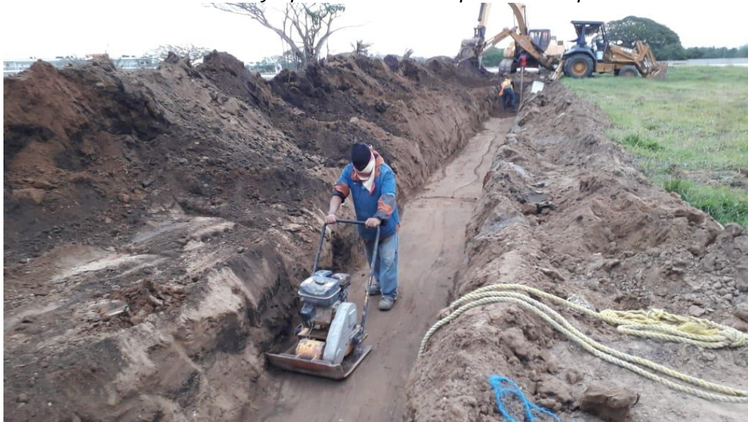
Foto 31.- Se rellenó la cepa y se compactó por capas con la placa vibratoria.
