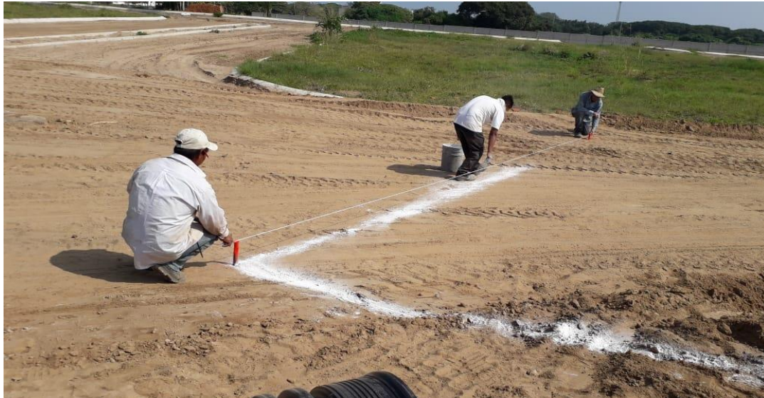
Foto 1.- En la imagen se muestra el trazo con cal de acuerdo a las coordenadas e información topográfica indicada en el proyecto, el cual se toma como referencia para las excavaciones.
