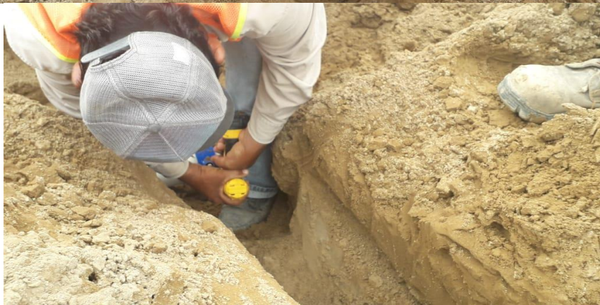
Foto 33.- Se colocó la abrazadera y se ajustó al tubo para que quedara totalmente fija, posteriormente se perforó con ayuda de un taladro.
