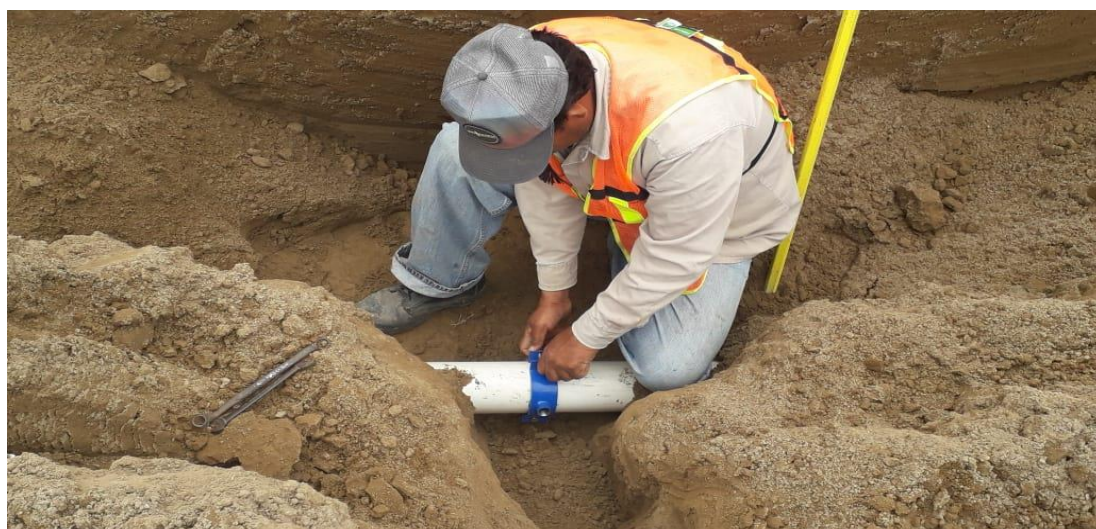
Foto 32.- Se llevo a cabo la excavación desde la línea principal hacia los lotes.
