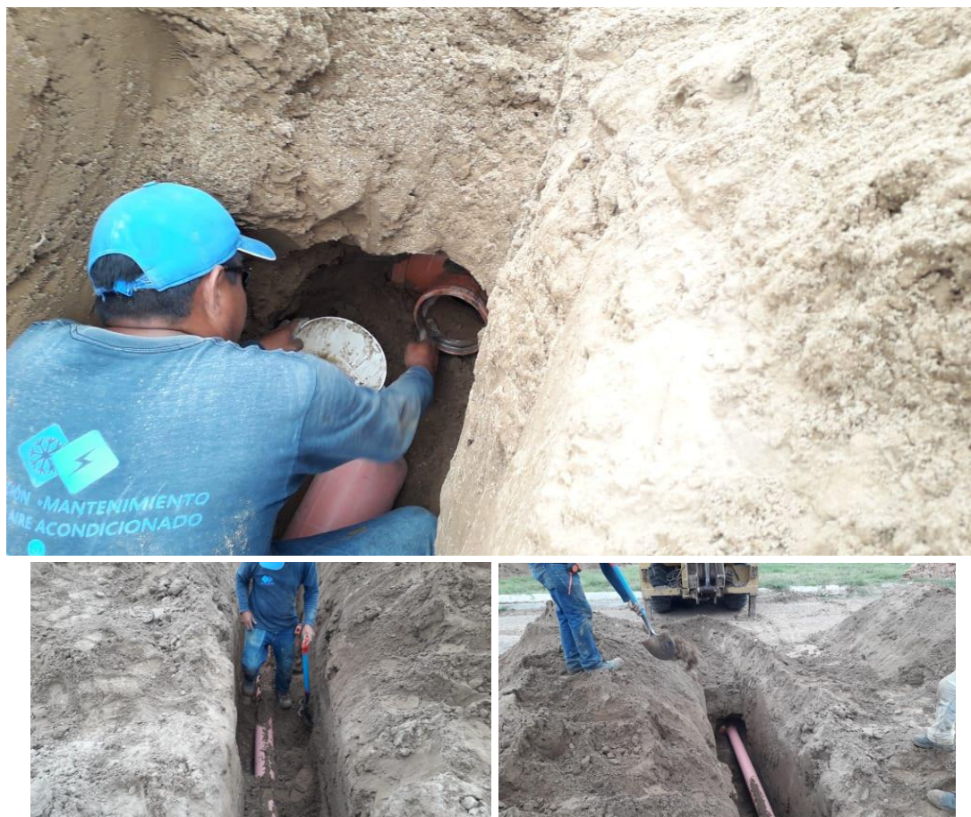
Foto 20.- Una vez ubicada la pieza se coloca el tubo en este caso de 6" de diámetro en la pieza.
