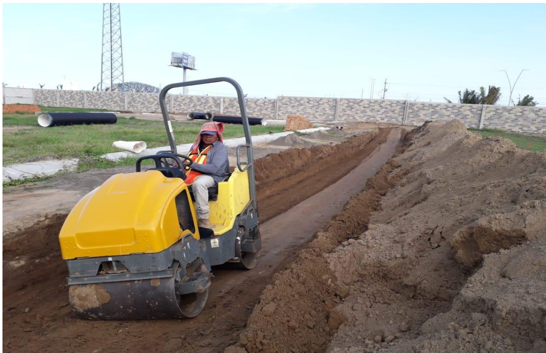
Foto 18.- Se rellenó la zanja con ayuda de la retroexcavadora y se compactó con un minirodillo.
