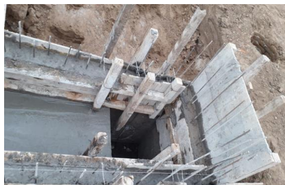
Foto 12.- Una vez teniendo la caja se pasa a cimbrar y a colar el colector, con las medidas y pendiente especificadas en los planos del proyecto.
