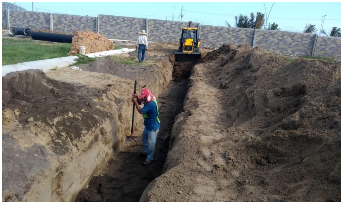
Foto 17.- Se acostilló la tubería para evitar que esta se mueva y se apisonó.
