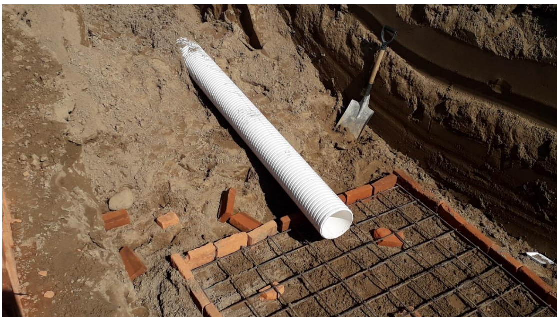
Foto 23.- Para la construcción de pozos los tubos se colocaron a 0.5 m del centro de este, se coloca la parrilla y se prepara para el colado de la plantilla.
