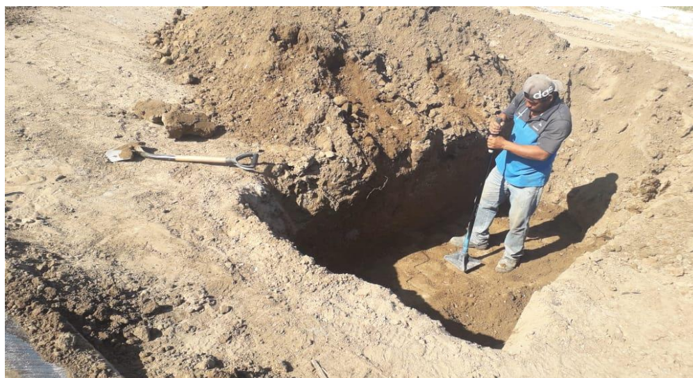
Foto 21.- Se apisonó y acostilló la tubería y posteriormente se rellenó la cepa.
