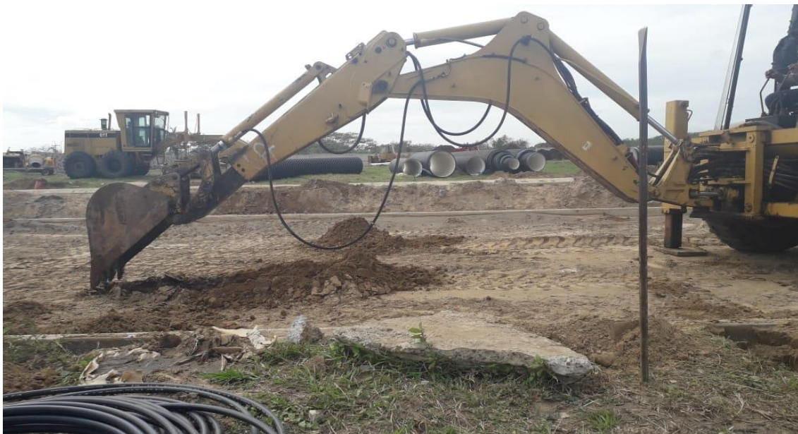
Foto 32.- Se llevo a cabo la excavación desde la línea principal hacia los lotes.
