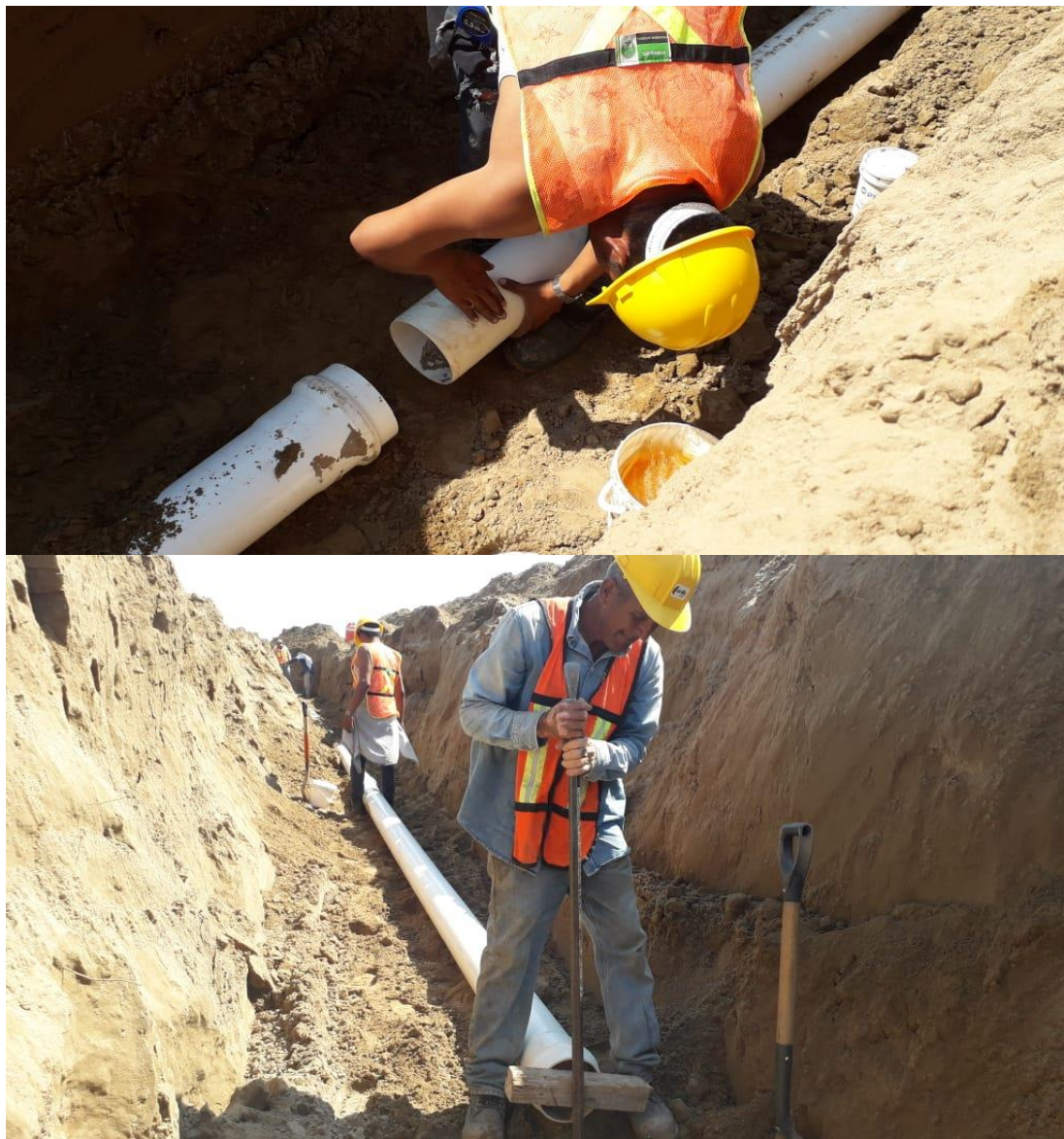
Foto 38.- Se comenzó con la colocación de tubos con los niveles correspondientes.
