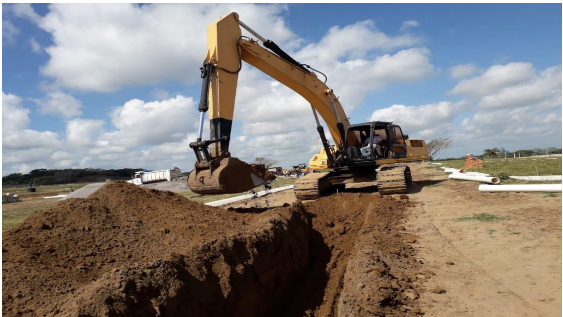
Foto 14.- Como se muestra en la imagen, las excavaciones se estuvieron llevando a cabo con la excavadora.
