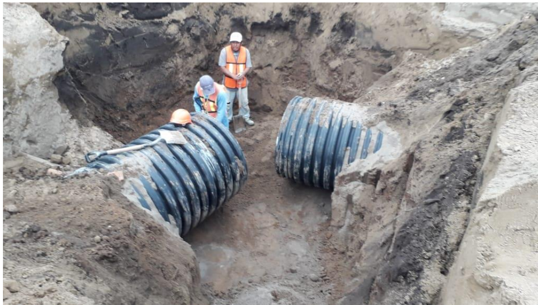
Foto 7.- Se apisonó el área para la plantilla del pozo de visita.
