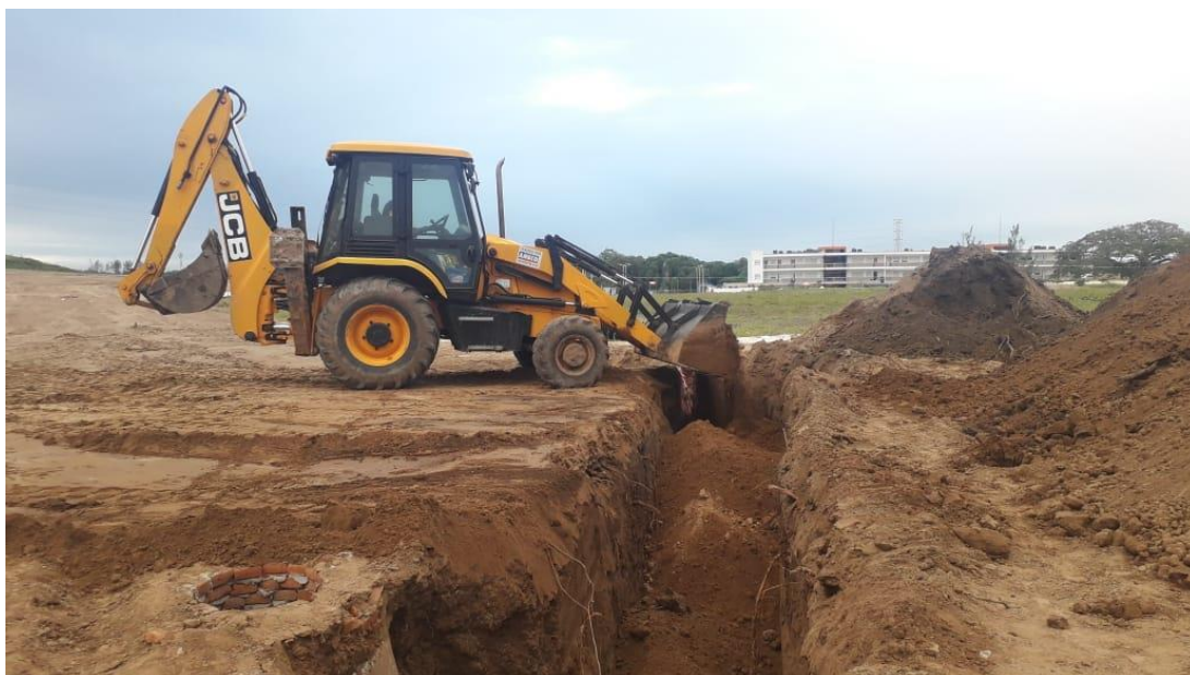
Foto 5.- Se rellenó la zanja con ayuda de la retroexcavadora con material de excavación.
