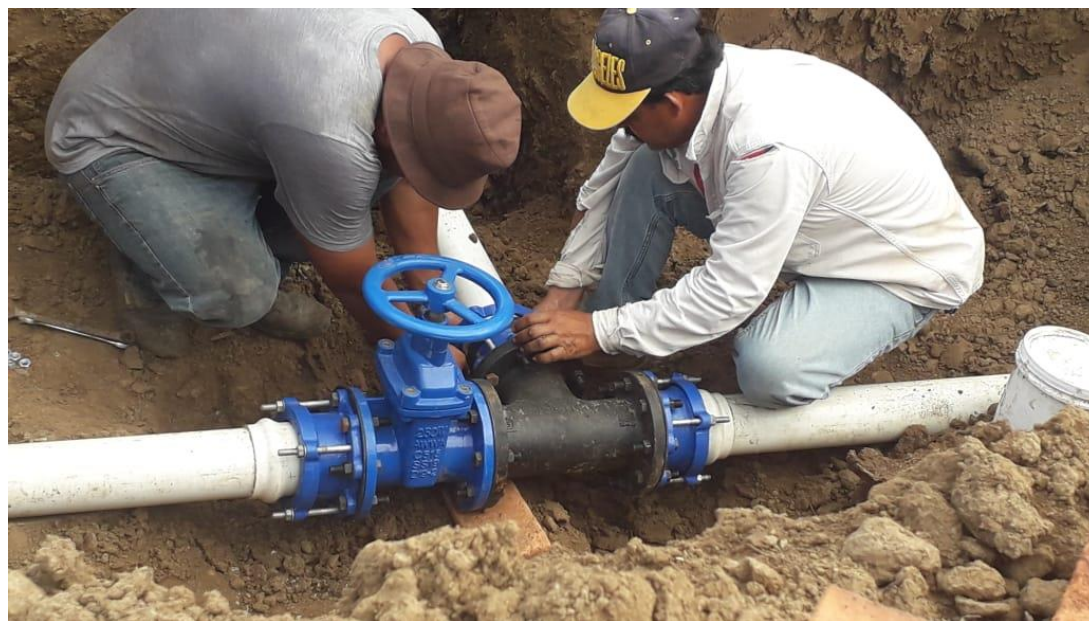
Foto 30.- Se llevaron a cabo los cruces y la instalación de las piezas especiales y válvulas de acuerdo a los nodos en el plano.
