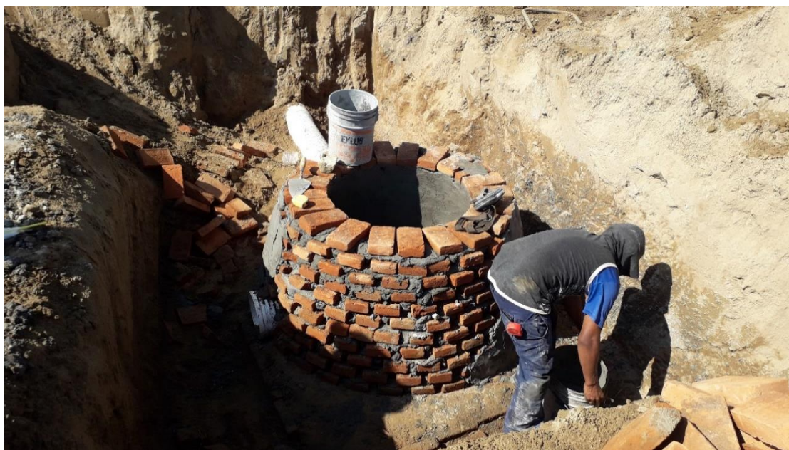
Foto 25.- Se llevó a cabo el pegado de tabiques hasta llegar a la altura de acuerdo al proyecto.
