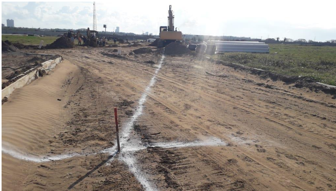
Foto 36.- En la imagen se muestra el trazo de acuerdo a la información indicada en el proyecto, el cual se toma como referencia para las excavaciones.
