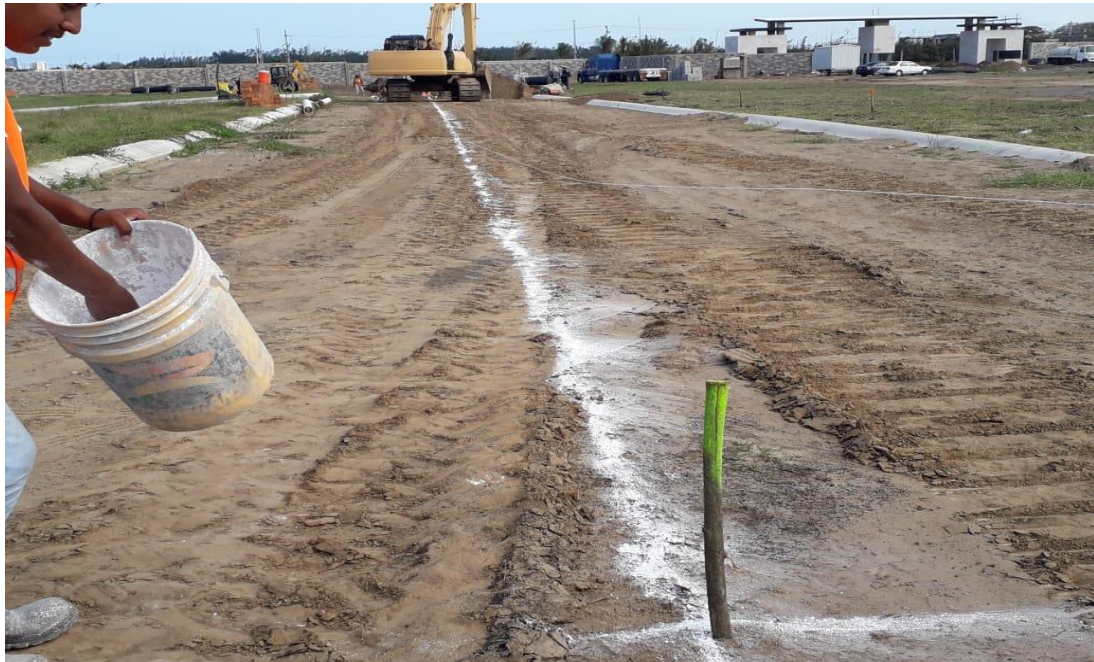
Foto 13.- En la imagen se muestra el trazo con cal de acuerdo a las coordenadas e información topográfica indicada en el proyecto, el cual se toma como referencia para las excavaciones.
