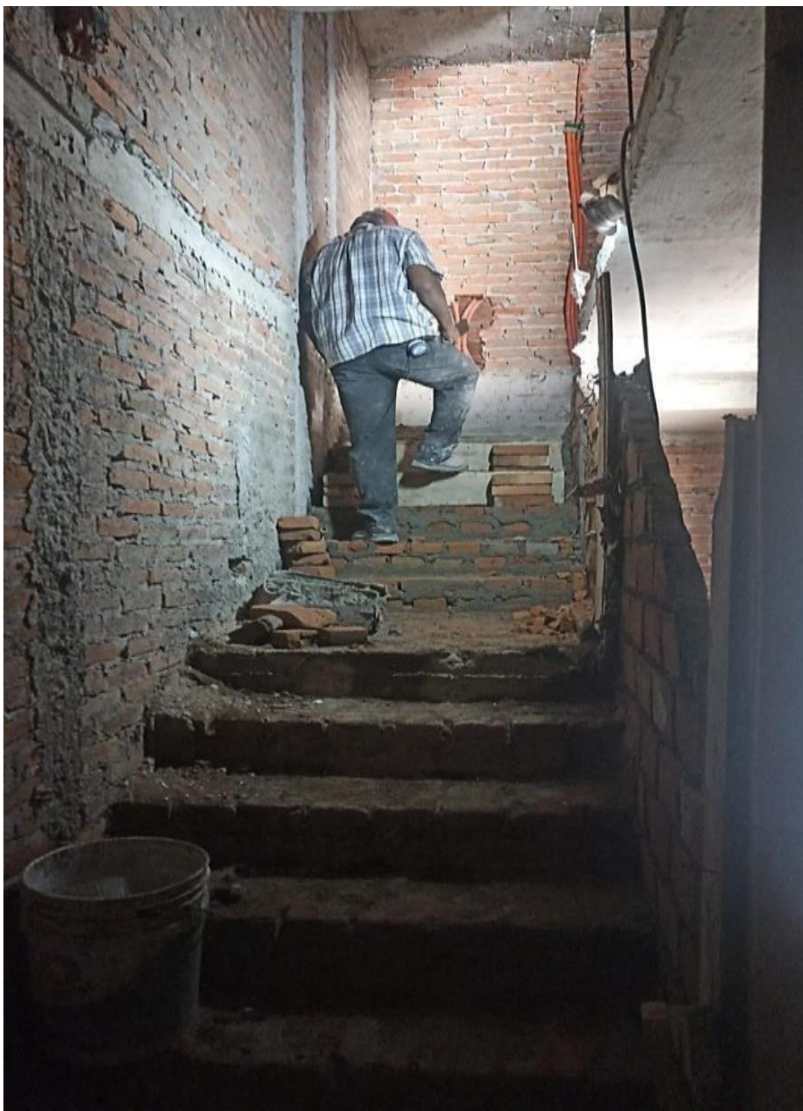
Figura 10. Pegado de tabique rojo recocido en cubo de escalera.
