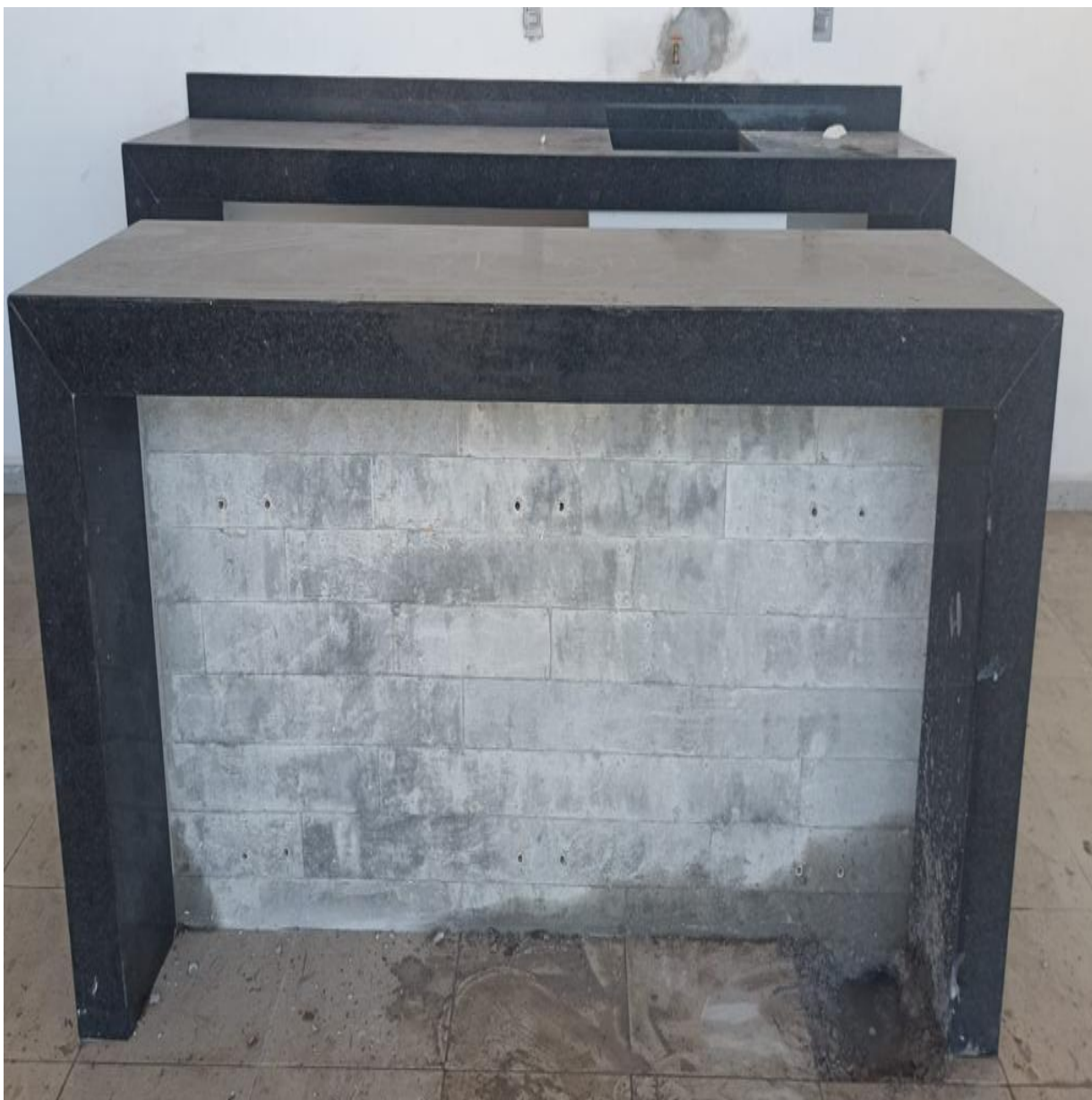
Figura 13. Acabados del roof garden.
