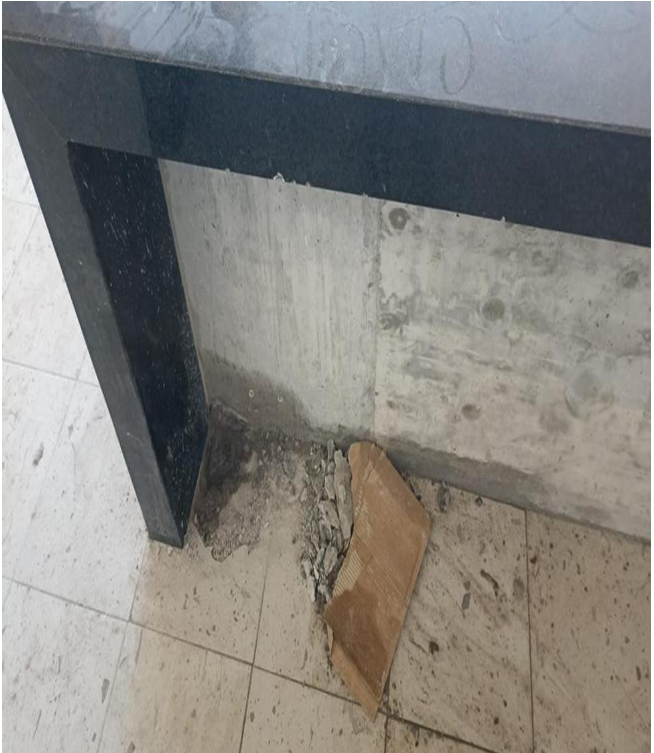
Figura 14. En la parte superior izquierda se puede ver como se dañó el mármol debido al poco cuidado cuando se instaló. Se mantuvo un cuidado especial poniéndose sobre las barras nylon negro para que no se mancharan ni dañaran.
