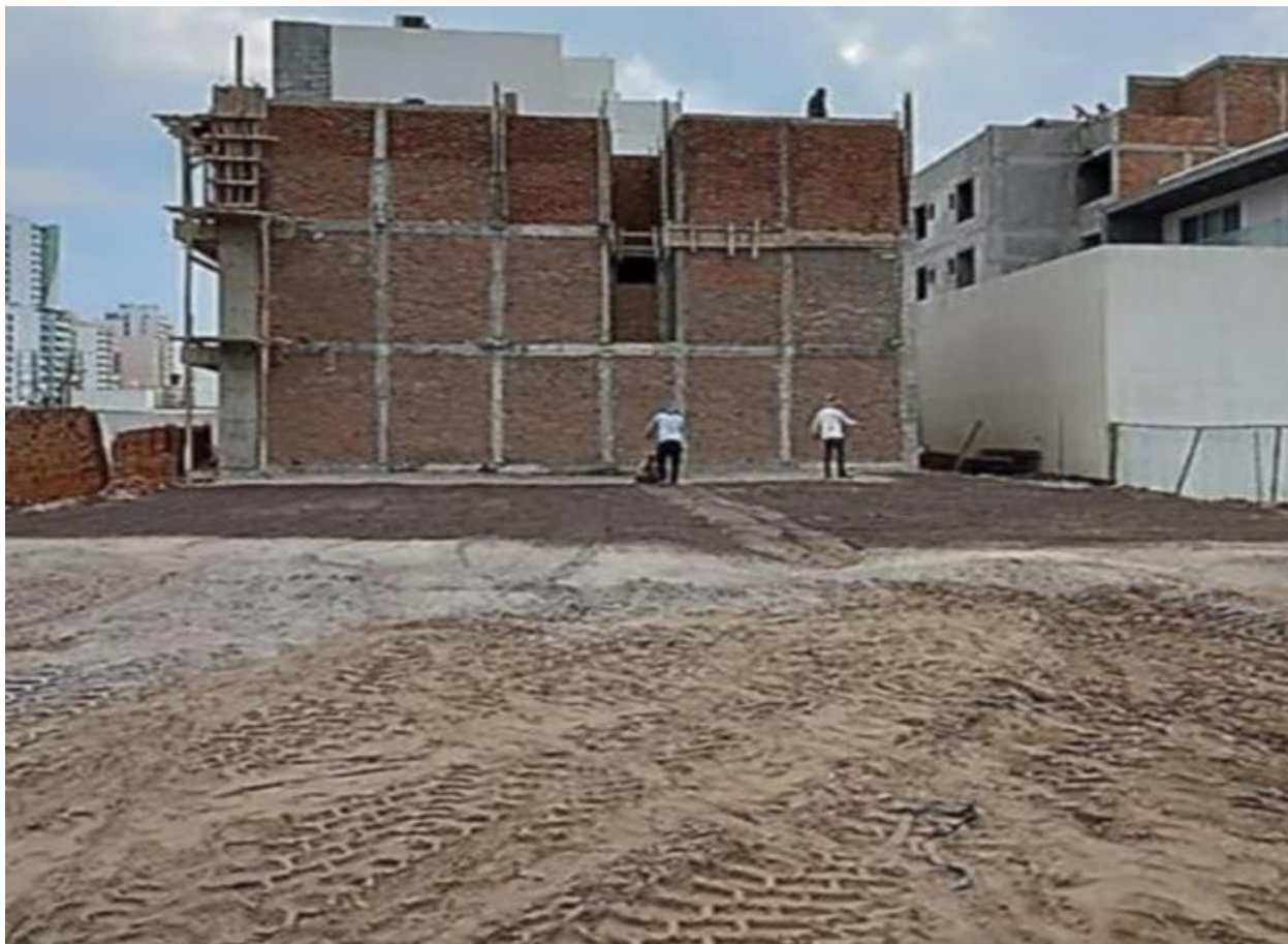
Figura 3. Trazo y nivelación.
