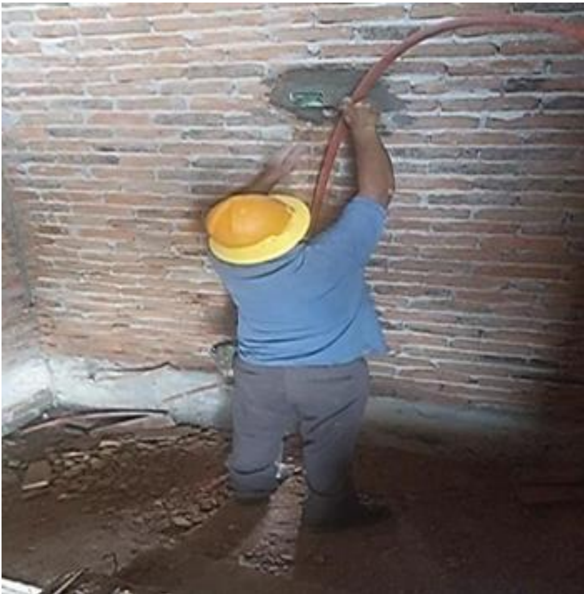
Figura 8. Colocación de poliducto naranja liso.
