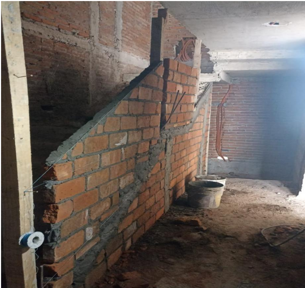
Figura 9. Muros estructurales y muro divisorio en el cubo de escalera.
