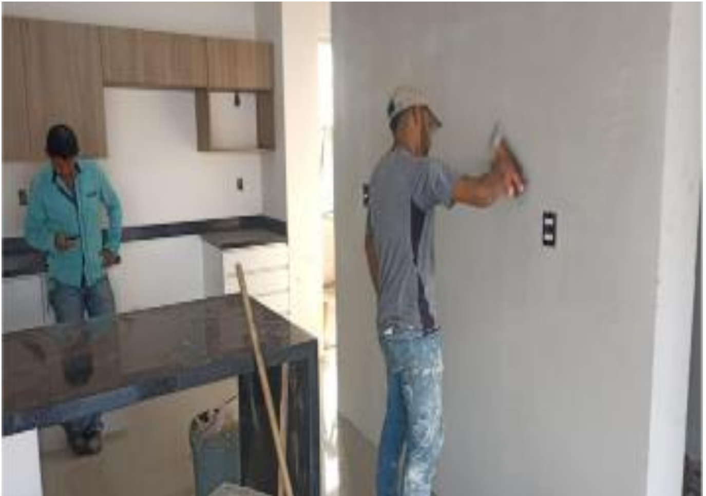
Figura 12. Después de la colocación del afino con lana sobre el revestimiento de mortero, el pastero alisa las paredes con papel lija del número 150, quedando listo para poderse colocar la pintura vinílica blanca a mínimo dos manos con rodillo.
