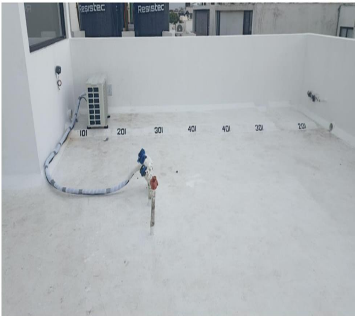
Figura 15. En la parte posterior separada por una pared, se encuentran las bases sobre los que irán los compresores de los aires acondicionados y los tanques estacionarios de cada departamento, además del Rotoplas correspondiente. Cada uno numerado a mano con brocha por un pintor, que se encargó además de los números de los medidores en el pórtico y cajones de estacionamiento.
