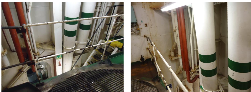
Figura 25. Acceso a cuarto de bombas de la parte superior.
