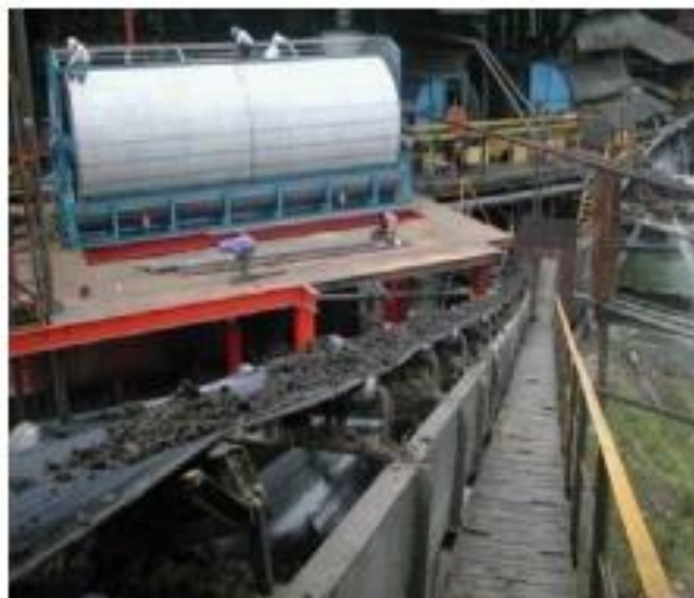
Figura 14. Filtro rotatorio utilizado en la etapa de clarificación.
