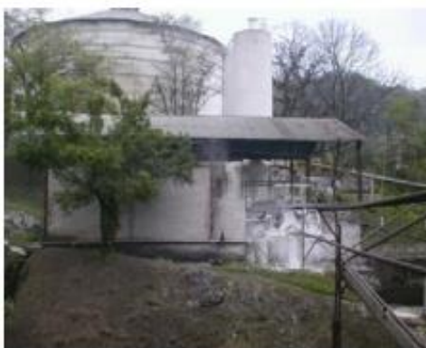
Figura 11. Área de preparación de la cal hidratada.
