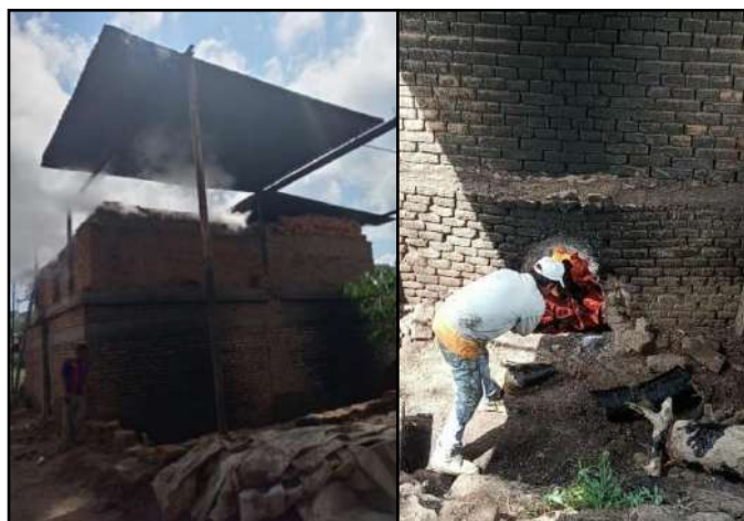
Ilustración 20. Quema de ladrillo. Fuente: Elaboración propia.
