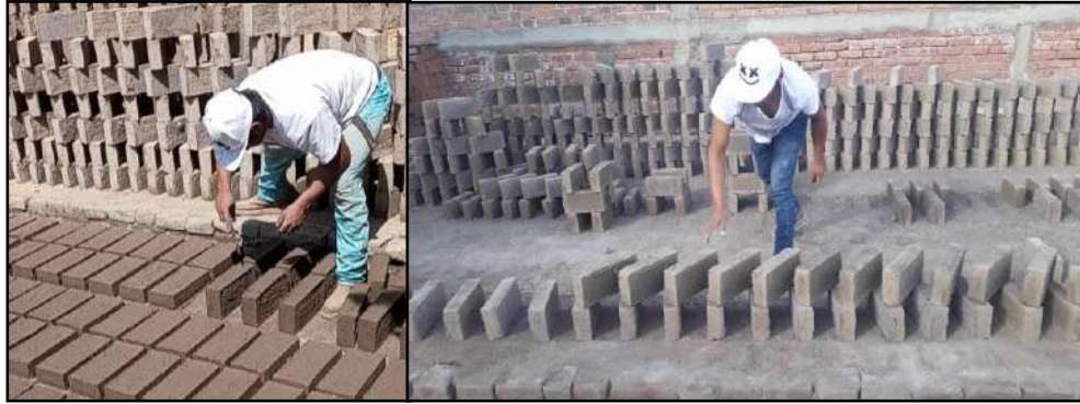
Ilustración 16. Raspado y atrincherado del tabique. Fuente: Elaboración propia
