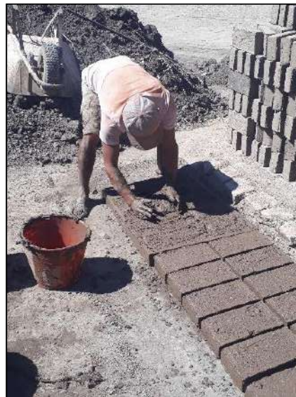
Ilustración 14. Tendido y alisado del tabique. Fuente: Elaboración Propia
