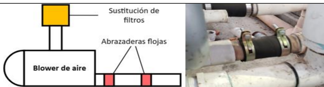
Figura 4.46 Sustitución de los filtros y abrazaderas en los blowers (de izquierda a derecha: esquema de y foto de las abrazaderas ajustadas)
