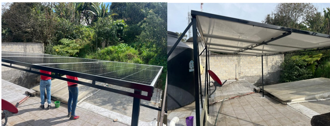
Figura 9 Montaje de los paneles
