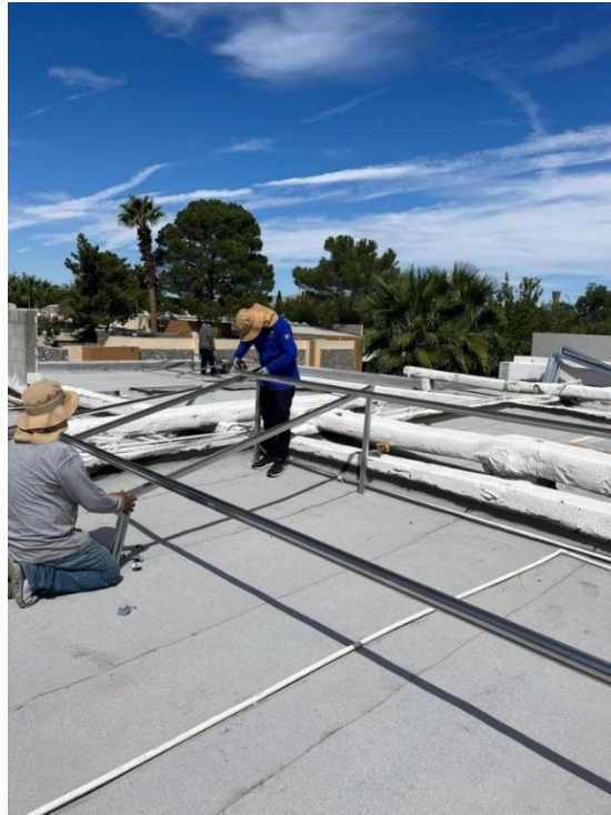
Figura 17 Instalación de estructuras
