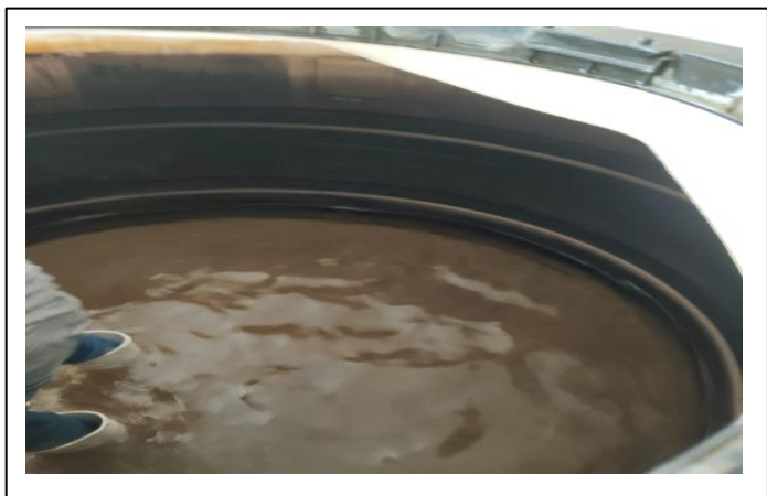
Figura 12. Tanque antes de lavarse
