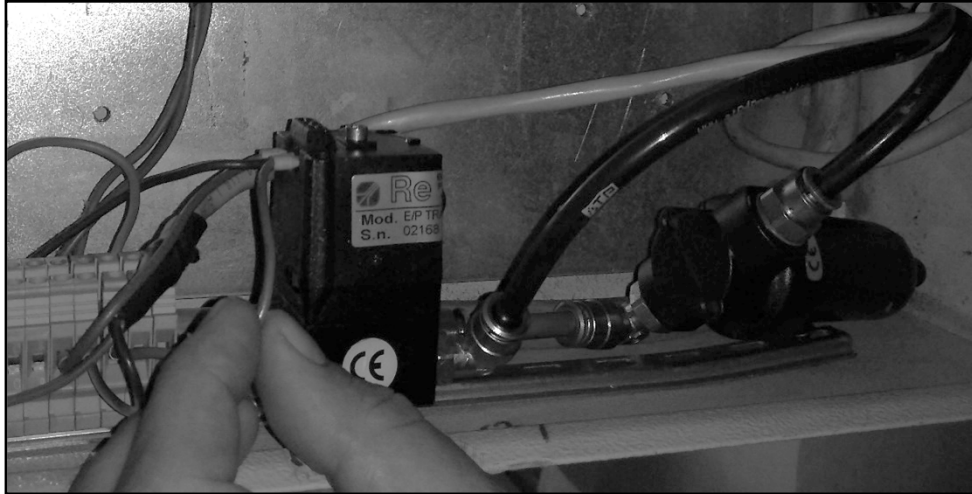
Figura 4.7 Instalación de Servo válvula.
