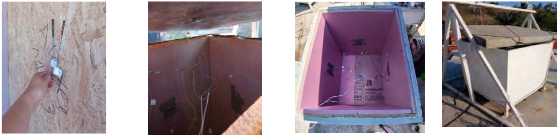
Figura 3.9 Colocación de los sensores de temperatura sobre las superficies del módulo experimental, y posicionamiento de la losa sobre los módulos experimentales.
