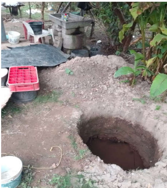
Anexo 3. Pozos de abastecimiento sin protección
