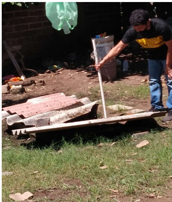
Anexo 2. Tapas inadecuadas para tapar un pozo de abastecimiento de agua
