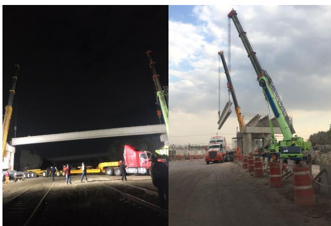
Ilustración 20 NOTA: Adaptado de Montaje de traveses, Autoría Propia, 2023
