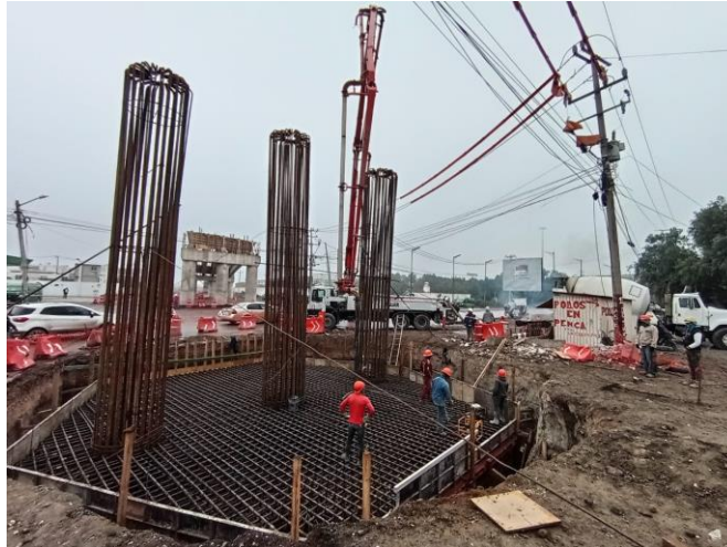
Ilustración 18 NOTA: Adaptado de Armado de zapata, Autoría Propia, 2023
