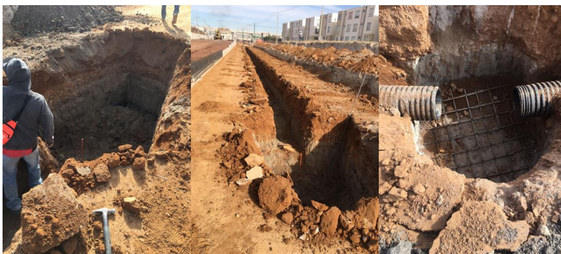
Ilustración 15 NOTA: Excavación de drenaje, de Autoría Propia, 2023
