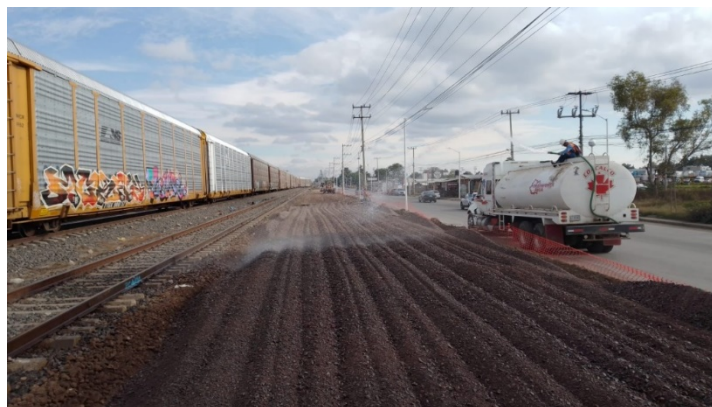
Imagen 3. Riego de agua en capa única de sub balasto, Av recursos hidráulicos.
