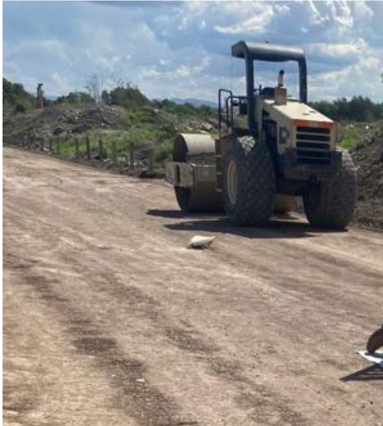
Imagen 4. Rodillo liso para compactación.
