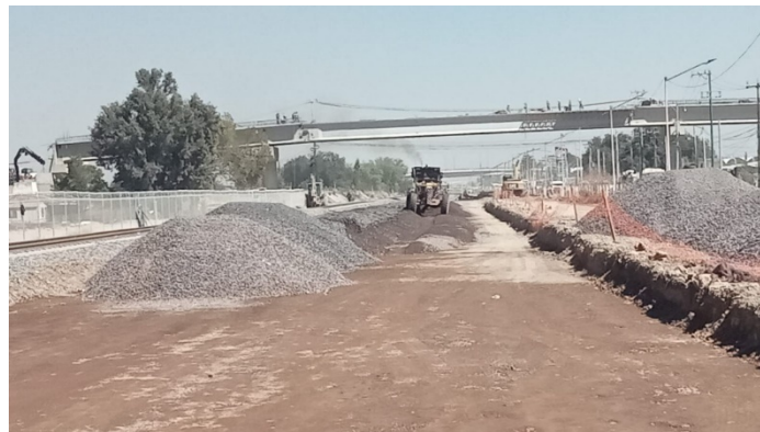
Imagen 2. Tendido de material (Capa única de sub-balasto)
