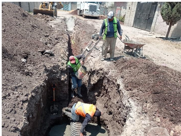
Fotografía 15 – Colado de losa de fondo de pozo
