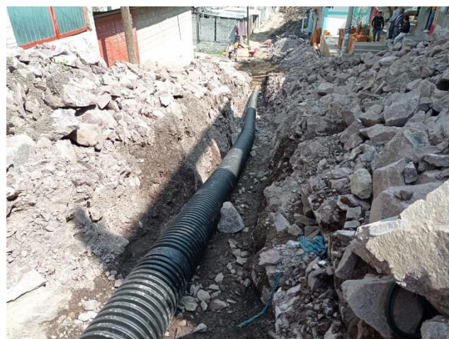
Fotografía 10 – Tendido de tubería drenaje
