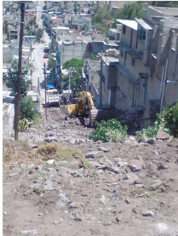
Fotografía 2 – Despalme de terreno.
