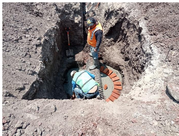
Fotografía 16 – Desplante de muros para pozo de visita
