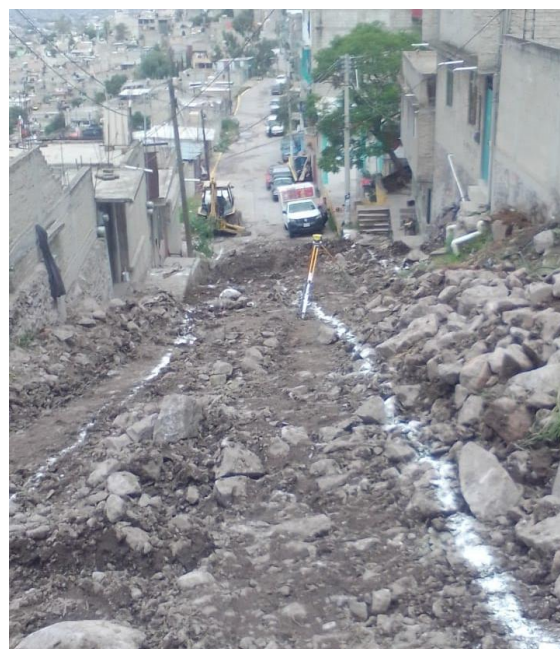
Fotografía 4 – Trazo y nivelación
