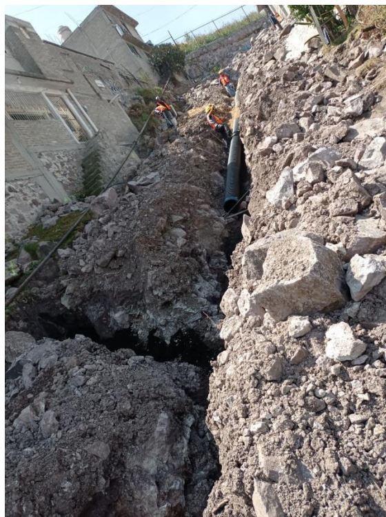
Fotografía 8 – Colocación línea principal drenaje
