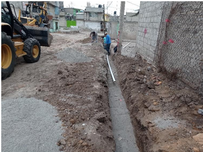
Fotografía 13 – Tendido de línea principal de A.P.
