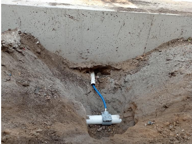
Fotografía 11 – Conexión de toma
