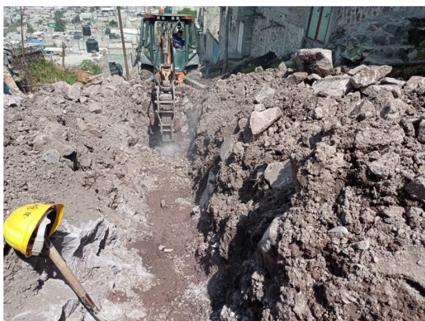
Fotografía 9 excavación en roca para cepa de línea principal de drenaje
