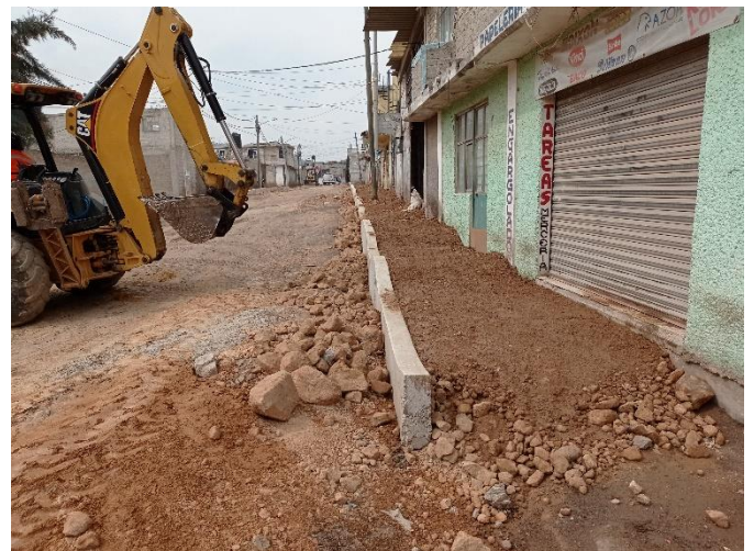
Fotografía 14 – Relleno de tepetate en banquetas
