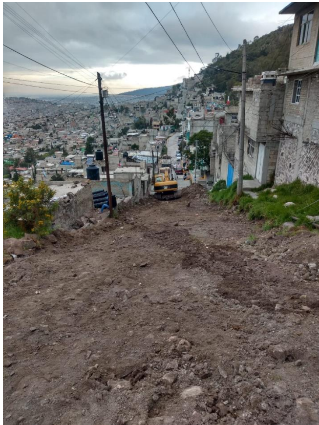
Fotografía 1- Despalme de terreno
