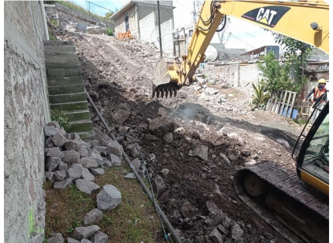
Fotografía 6 – demolición para alojamiento de pavimento
