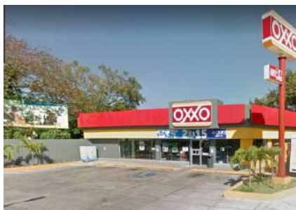
Foto 3. Edificación vulnerable Fuente: Propia
