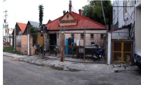
Foto 2. Vivienda vulnerable en temporada de lluvias Fuente: Propia
