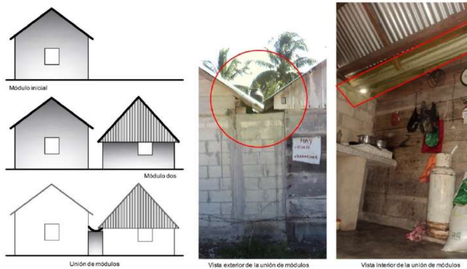
Figura 9. Canaleta para desalojo de aguas pluviales. Fuente: Elaboración propia. Imágenes del archivo Clara Torres 2017.
