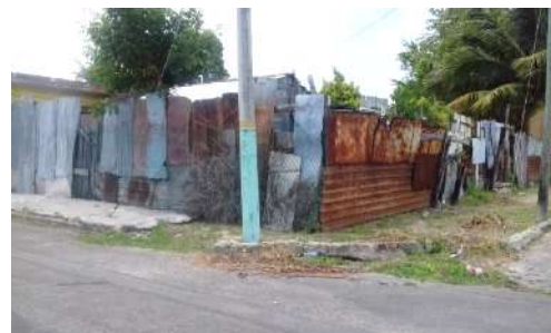
Foto 4. Vivienda y entorno vulnerable Fuente: Propia
