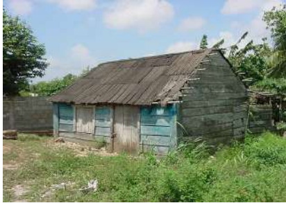
Foto 1. Vivienda precaria Fuente: Propia
