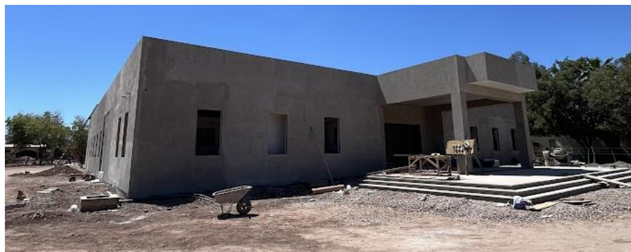
Ilustración 1 Estado inicial del Palacio Municipal de Juan José Ríos durante la visita técnica preliminar. Fuente: Elaboración propia, enero de 2025.
