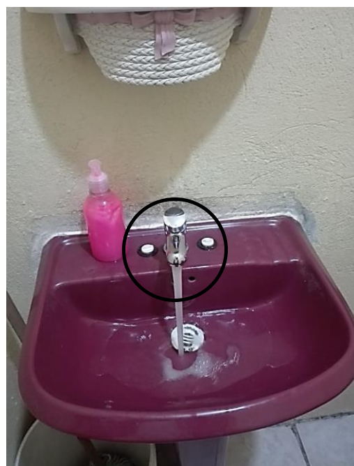
Ilustración 42. Grifo nuevo temporizado
