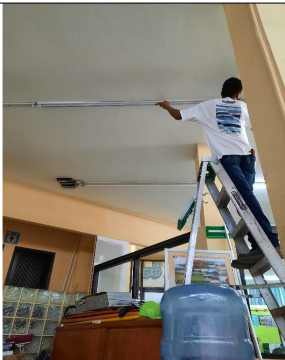
Ilustración 30. Reemplazo de lámparas en mal estado
