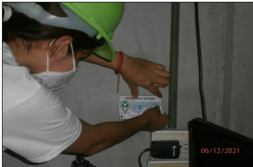
Ilustración 20. Colocación de etiquetas de ahorro de energía
