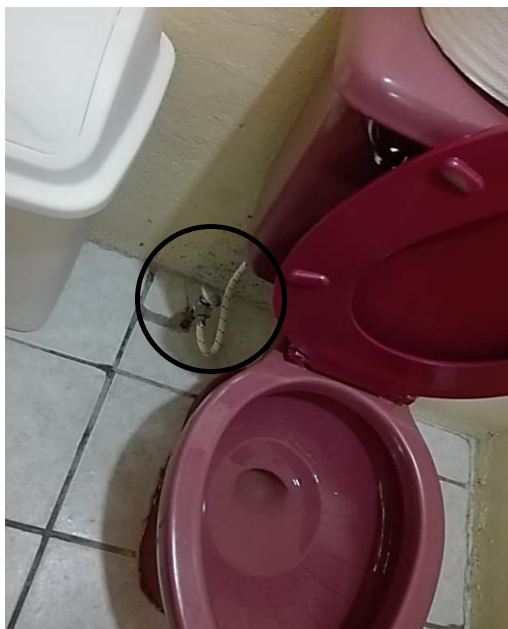
Ilustración 41. Instalación de tubería nueva
