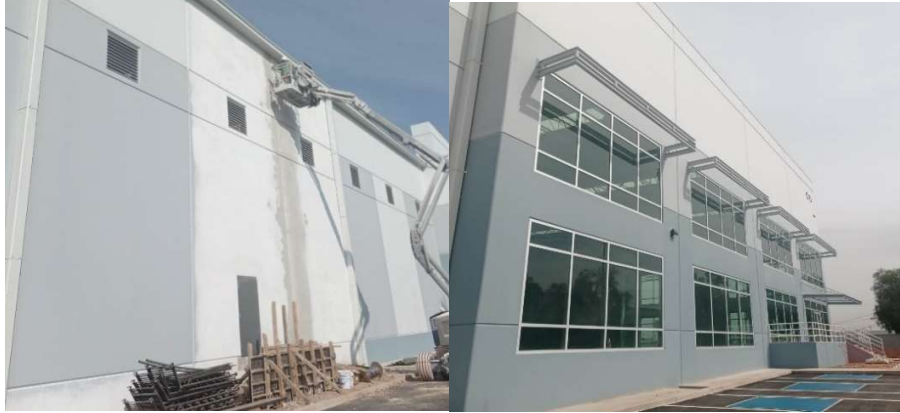
IMAGEN 47 Terminado de muros
