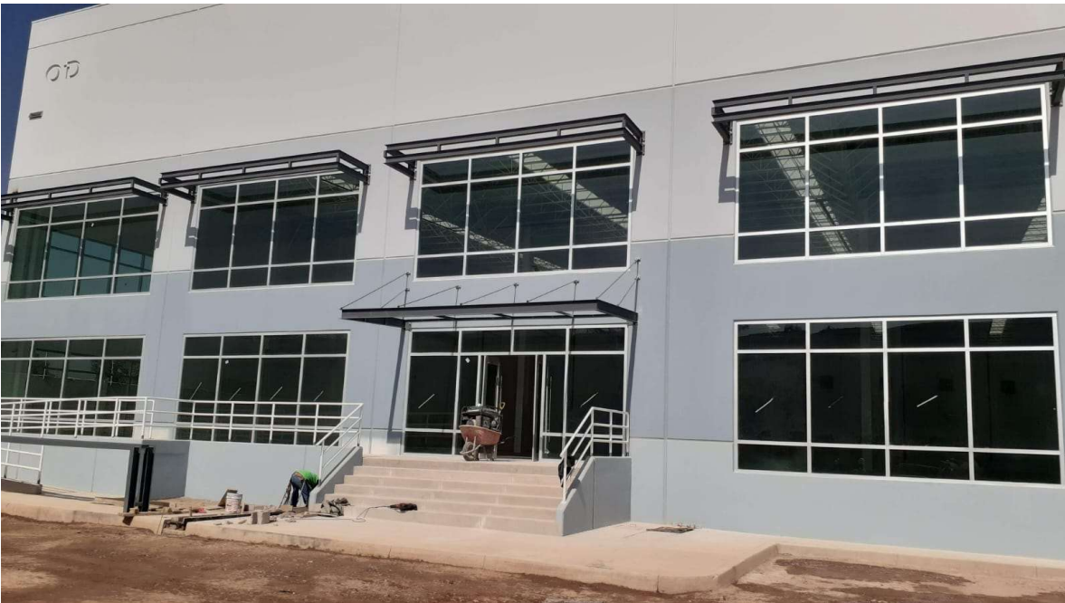
IMAGEN 40 Fachada principal modificada
