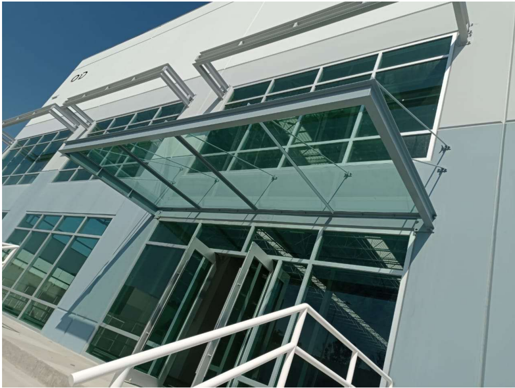
IMAGEN 63 Fachada principal terminal.2
