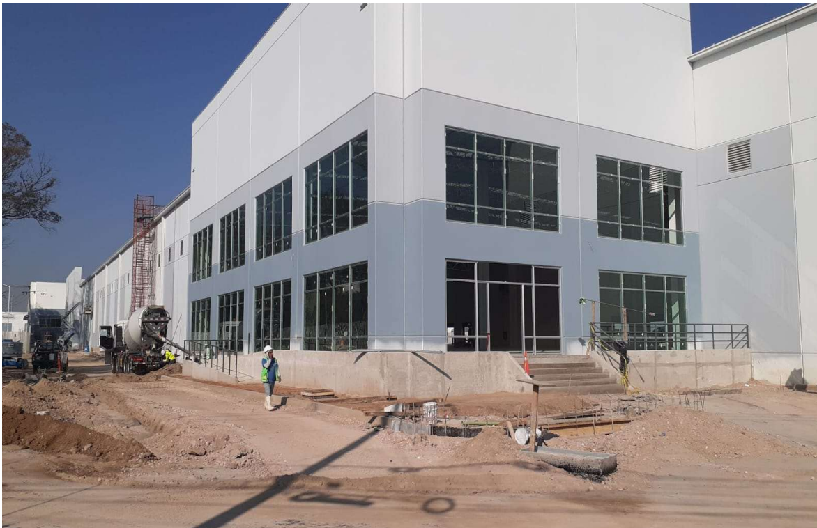
IMAGEN 60 Instalación de cancelería en puertas y ventanas
