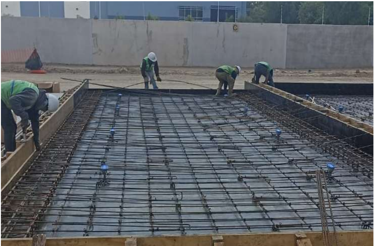
IMAGEN 14 Armado y calzado de muro
