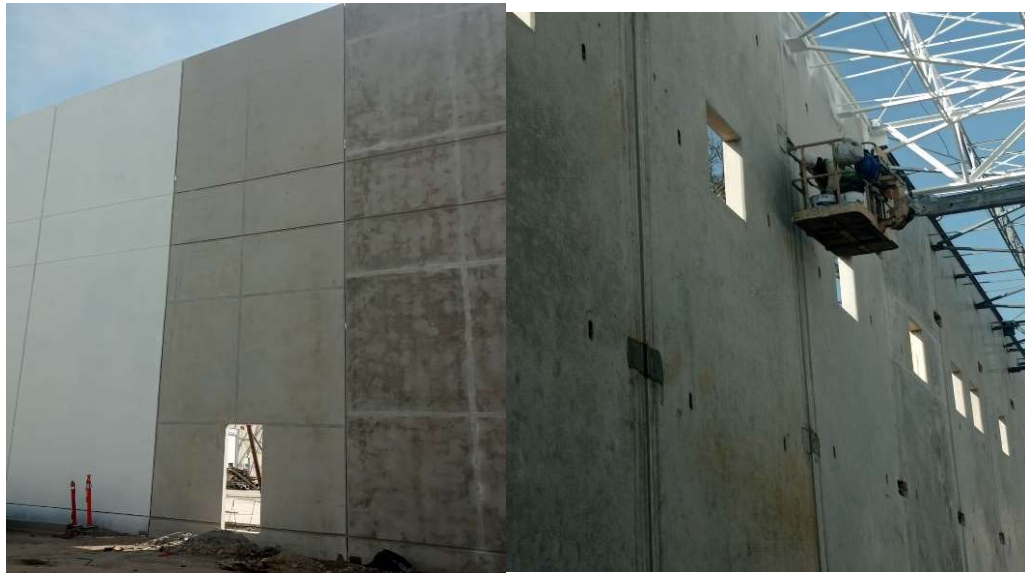
IMAGEN 45 Pintura y sellado de muros
