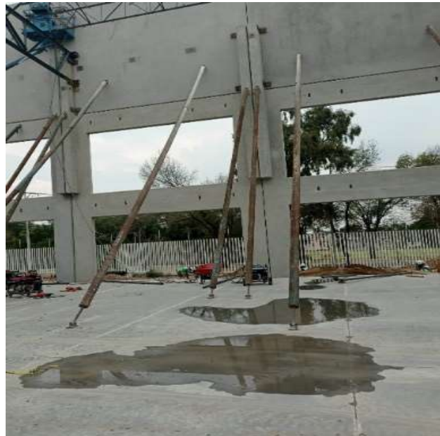
IMAGEN 34 Plomeo del muro con gatos hidráulicos
