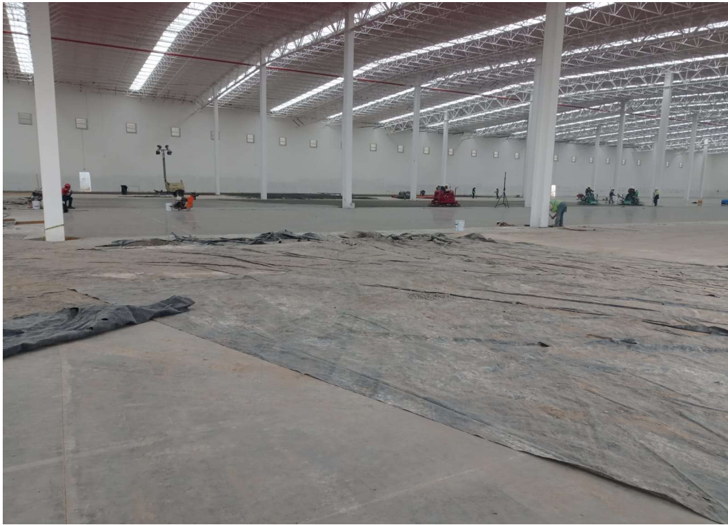
IMAGEN 61 Terminado aparente en la cubierta
