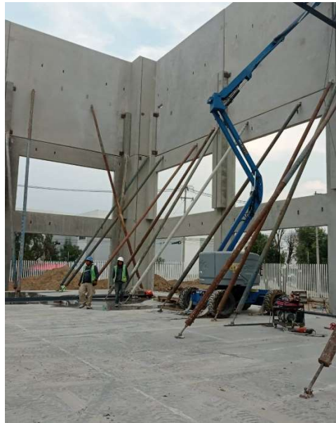
IMAGEN 4 Plomeo de muro tilt-up
