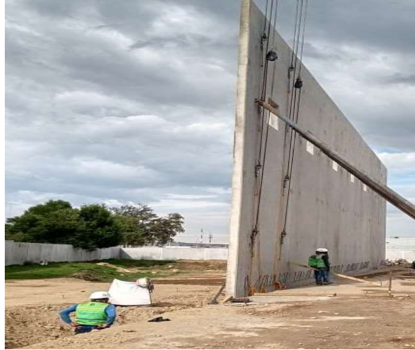
IMAGEN 50 Plomeo del muro y aprovechamiento estructural
