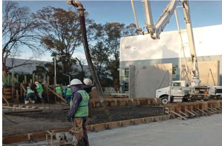
IMAGEN 30 Colado de concreto para muros
