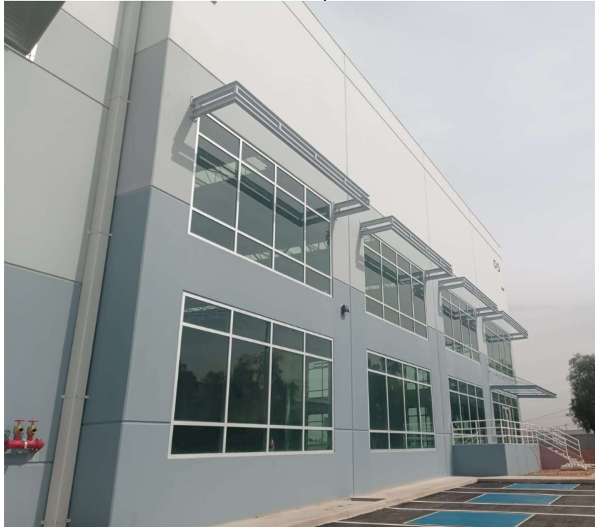
IMAGEN 62 Fachada principal terminada
