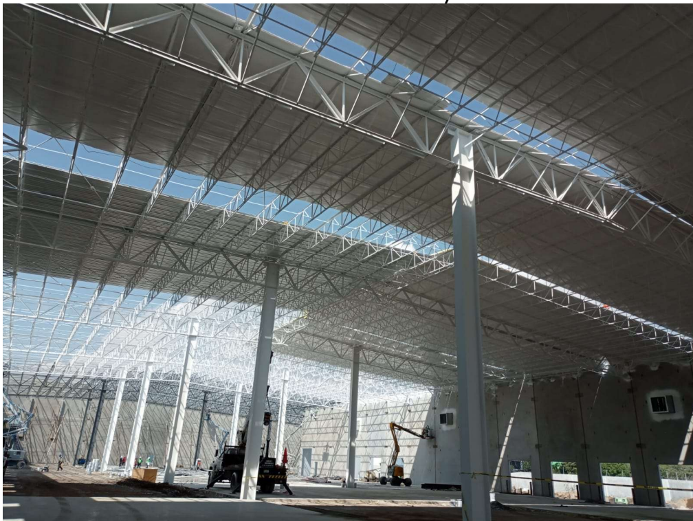
IMAGEN 56 Instalación de la cubierta
