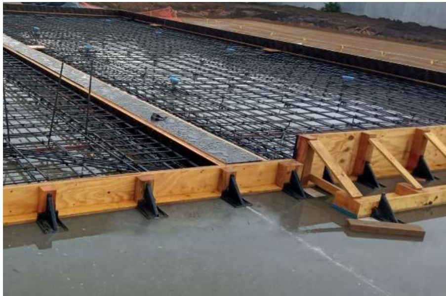
IMAGEN 12 Armado y cimbra de muro
