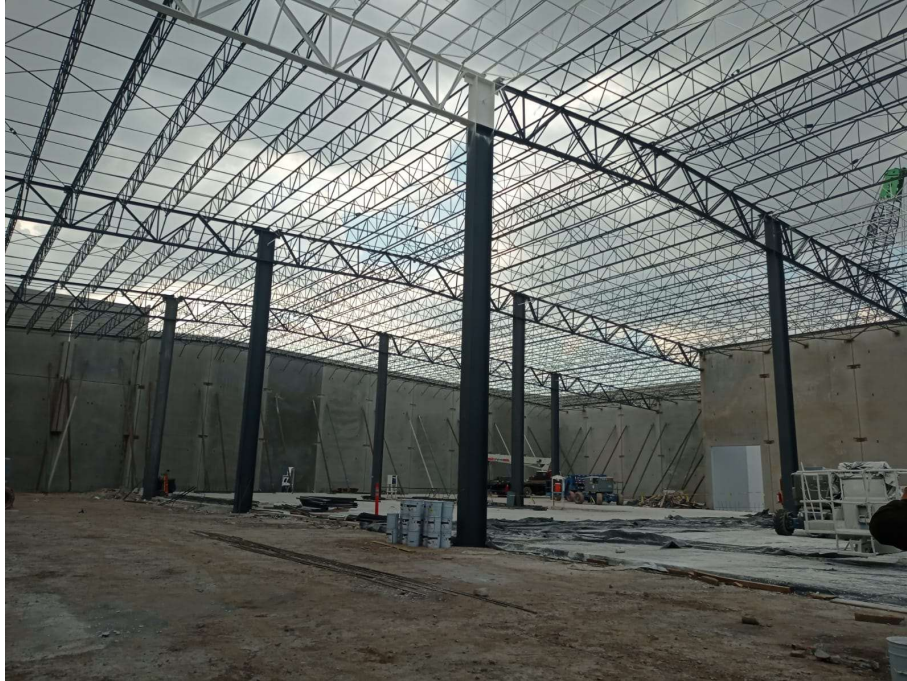
IMAGEN 53 Instalación de la armadura para la cubierta
