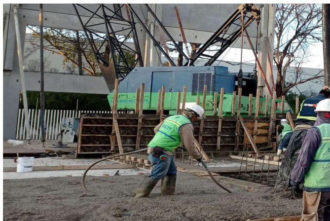
IMAGEN 31 Vibrado de concreto
