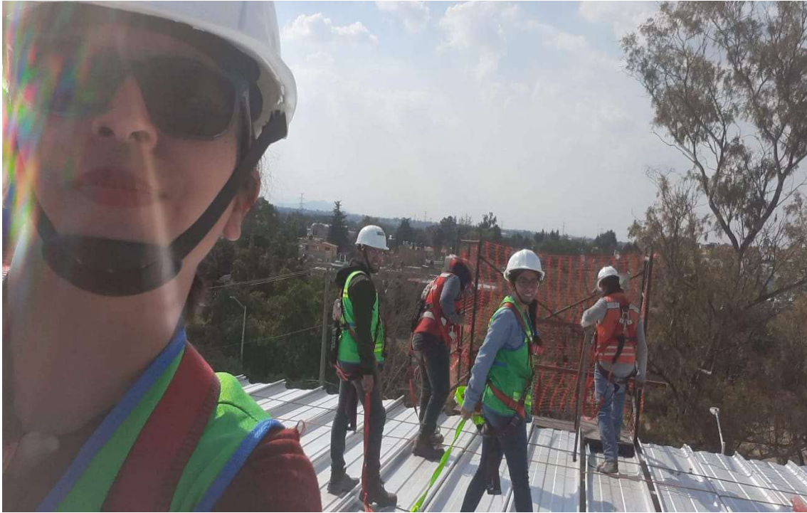
IMAGEN 57 Revisión en la instalación de la cubierta
