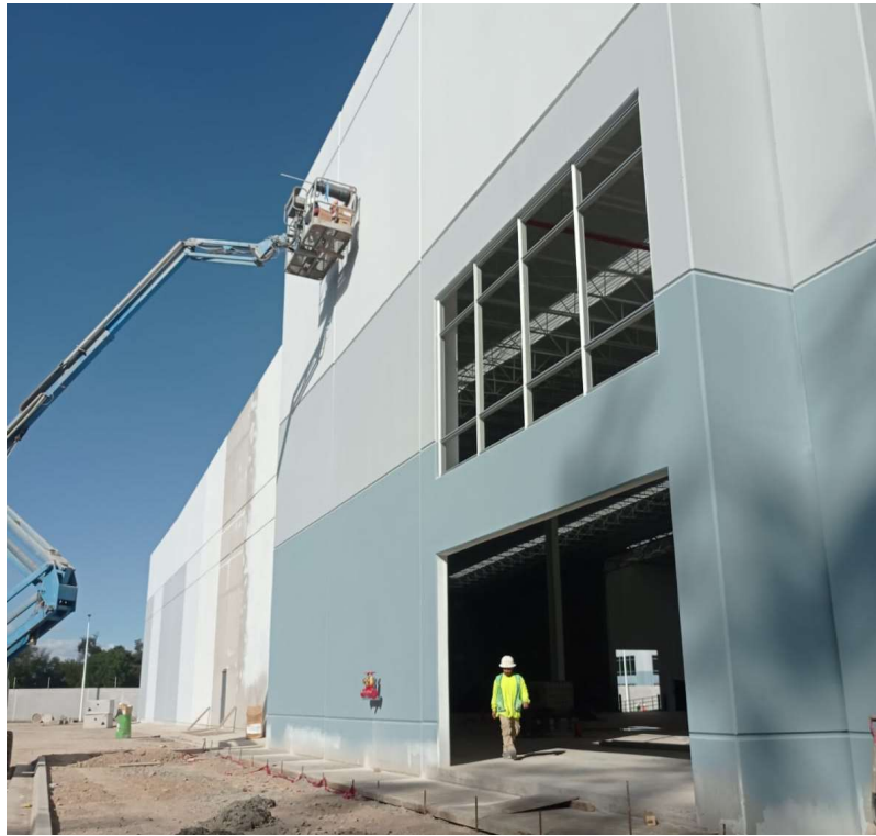
IMAGEN 59 Pintura final en muros
