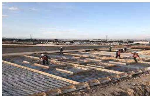
IMAGEN 44 Armado de varios muros
