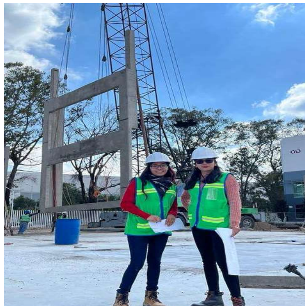
IMAGEN 35 Supervisión del izaje
