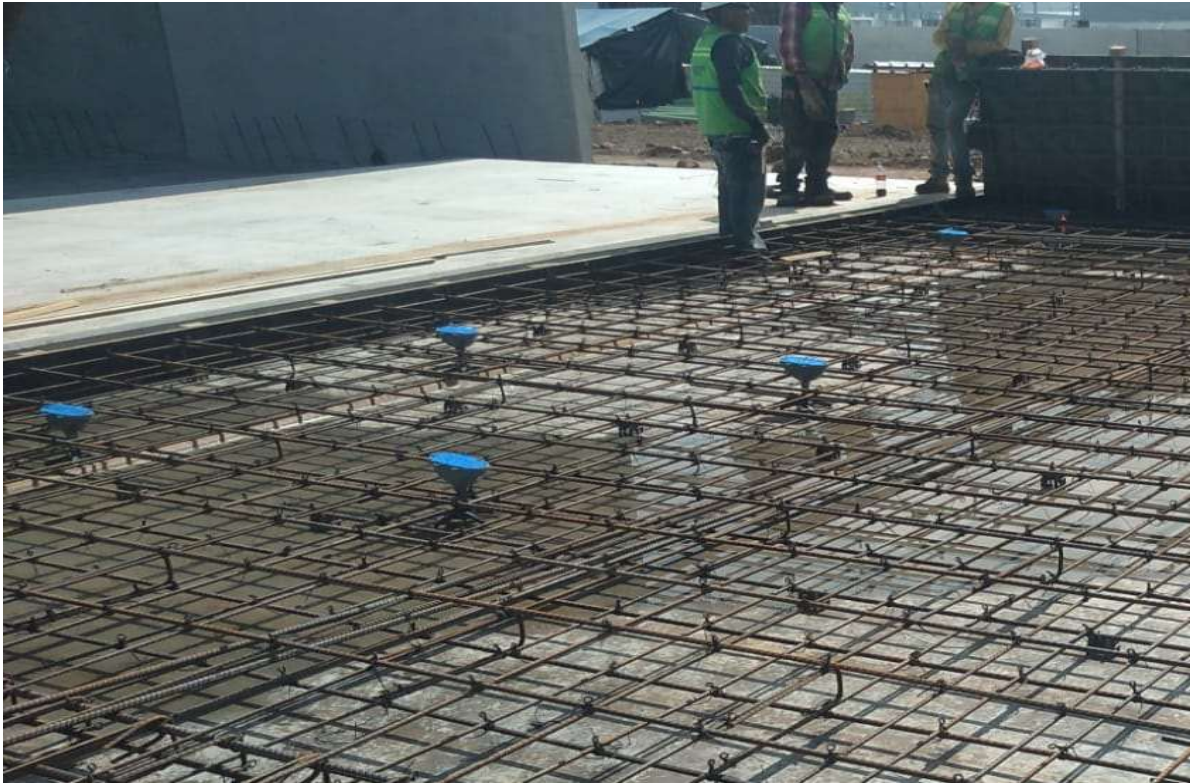
IMAGEN 15 Colocación de insertos
