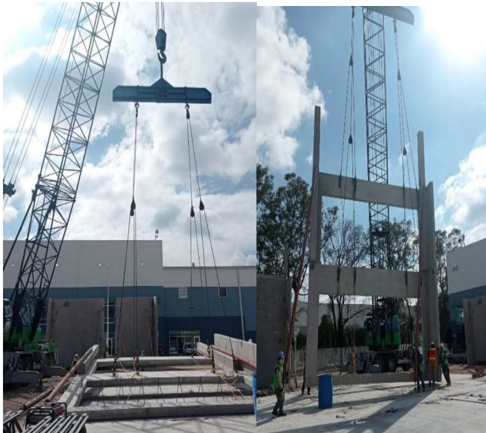
IMAGEN 33 Colocación de eslinga e izaje de muro
