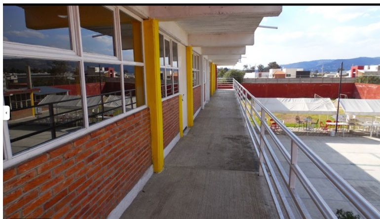
Figura 4. Vista del segundo piso de la empresa. Fuente: Creación Propia.
