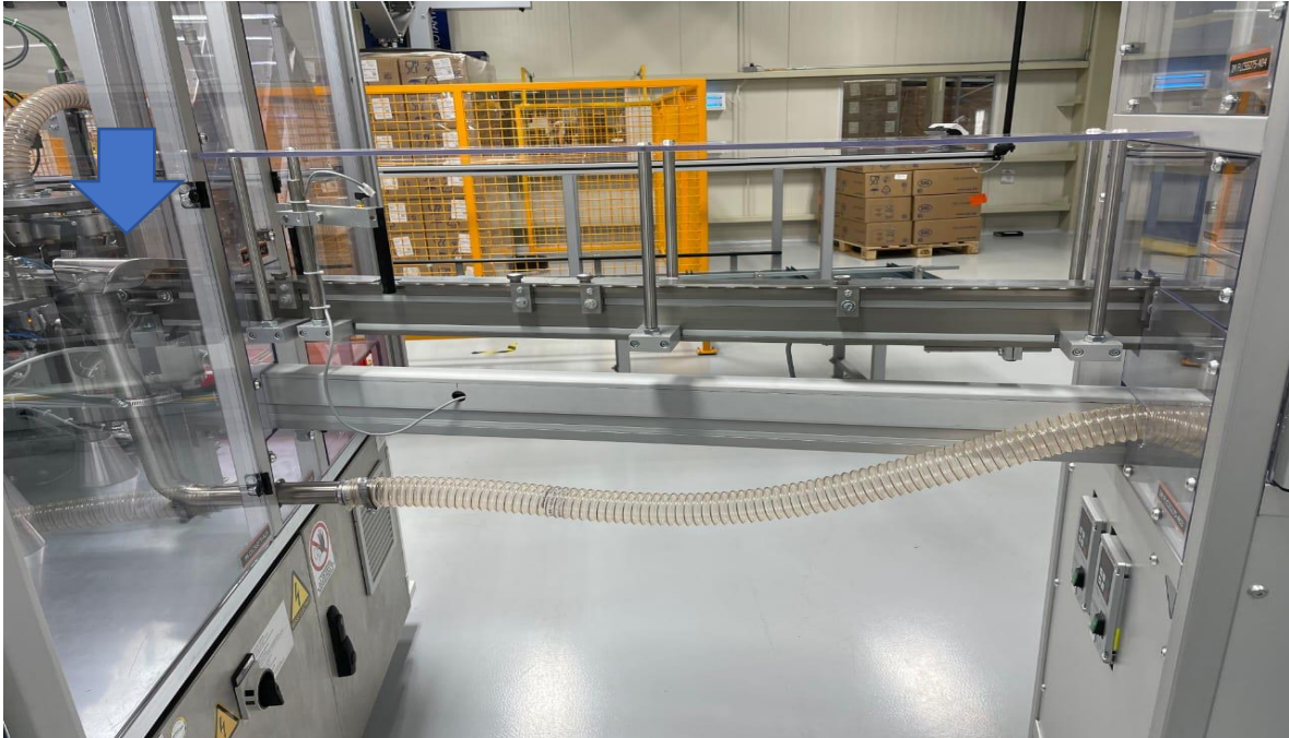
Figura 2.0 Colocación de aspiradora en linear de spout.
