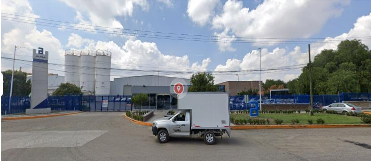
Figura 1: Ubicación de la planta Alpla Bajío san José Iturbide
