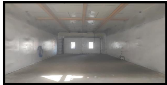
Figura 15: Cabina de pintura
