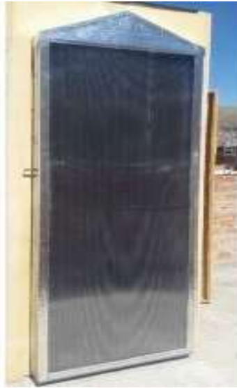
Figura (5). CSCA instalado verticalmente
