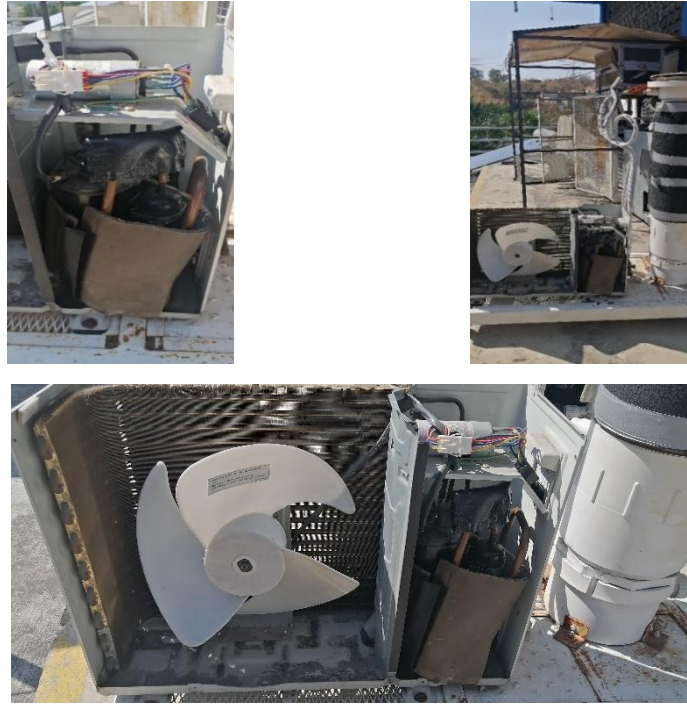
Figura 23. Sistema de enfriamiento para control de Temperatura de entrada ( T_i ).
