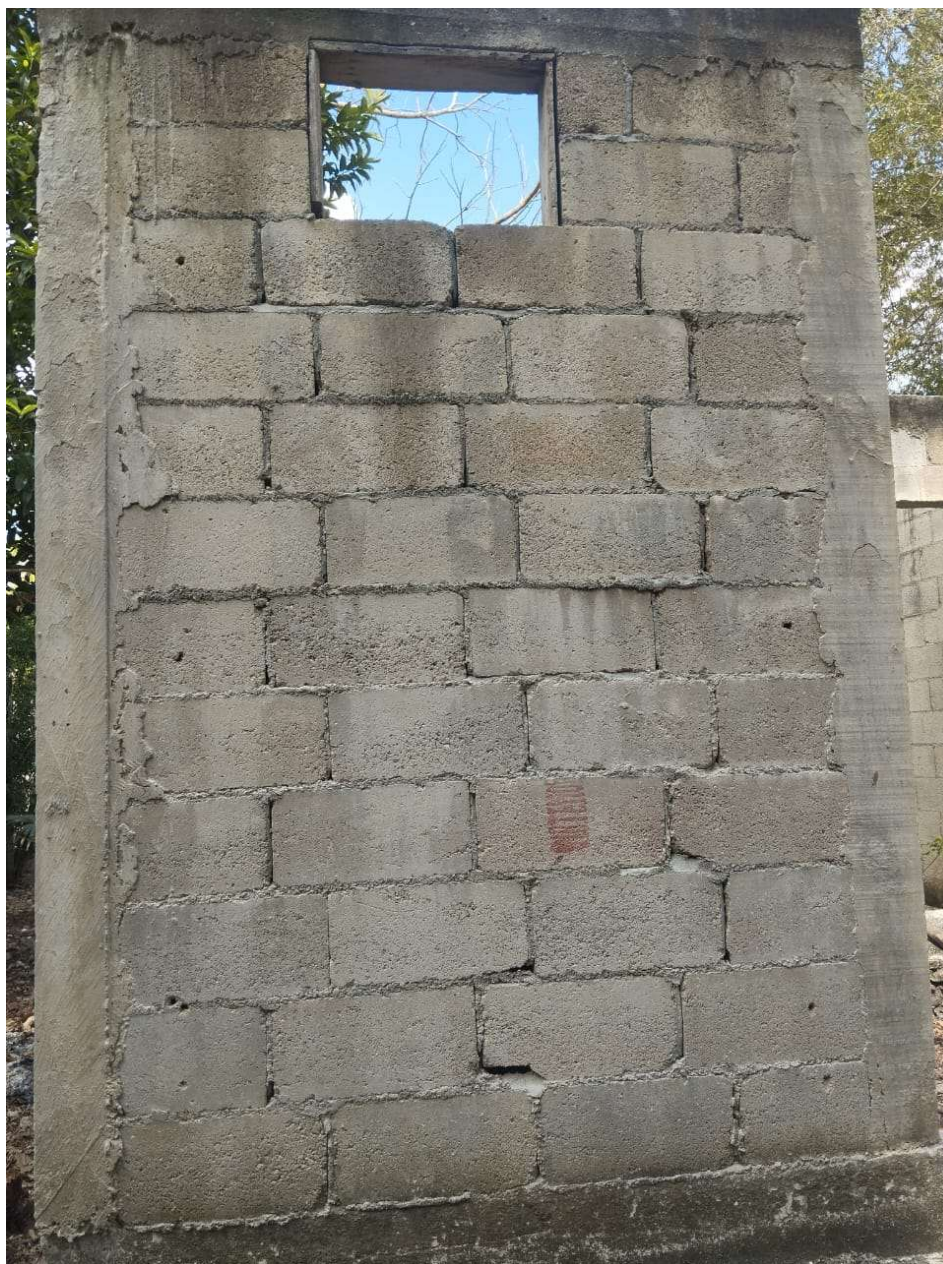
Figura 4. 6. Baño de una vivienda inconclusa, los materiales fueron suministrados por un programa de vivienda
