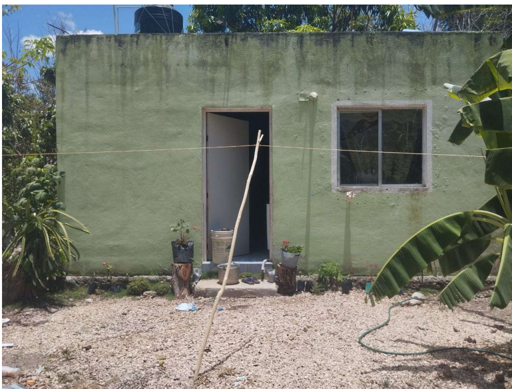
Figura 2. 4. Estado actual de vivienda entregada a través de Programa Social
