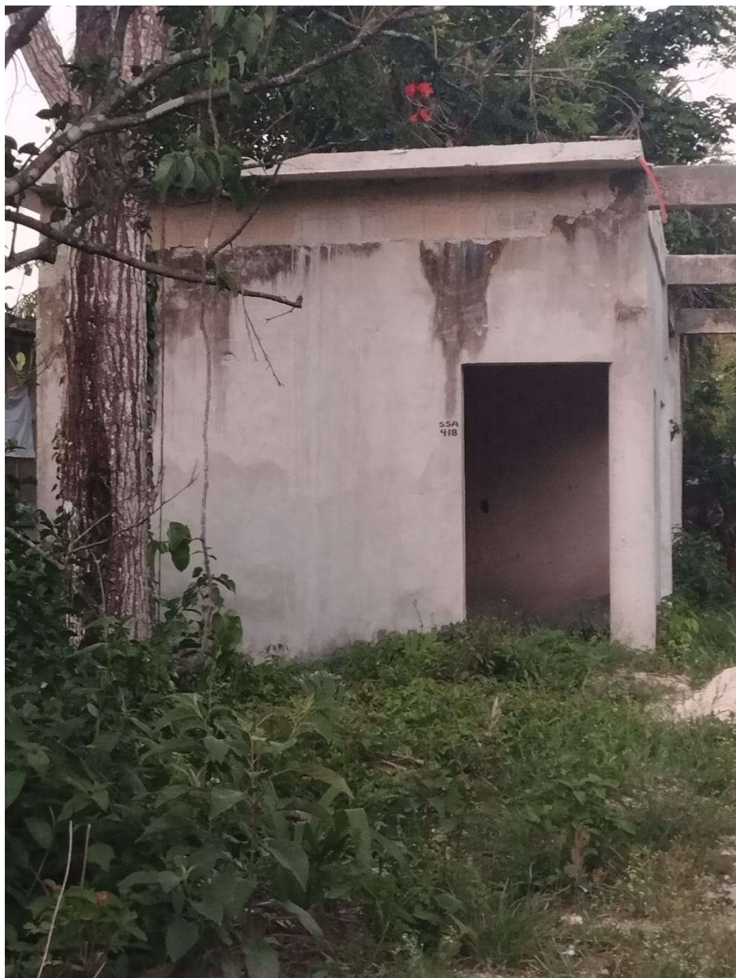
Figura 4. 5. Vivienda inconclusa en etapa de acabados, los materiales fueron suministrados por un programa de vivienda
