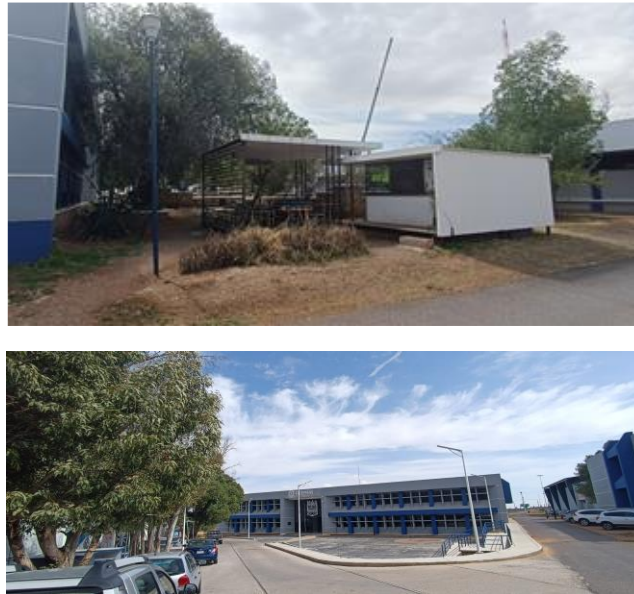
Cafetería, edificio V y edificio Z respectivamente
