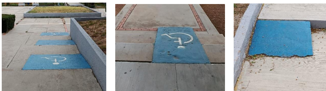
Clasificación de rampas las dos primeras imágenes si cumplen con normativa vigente y la última no cumple.
