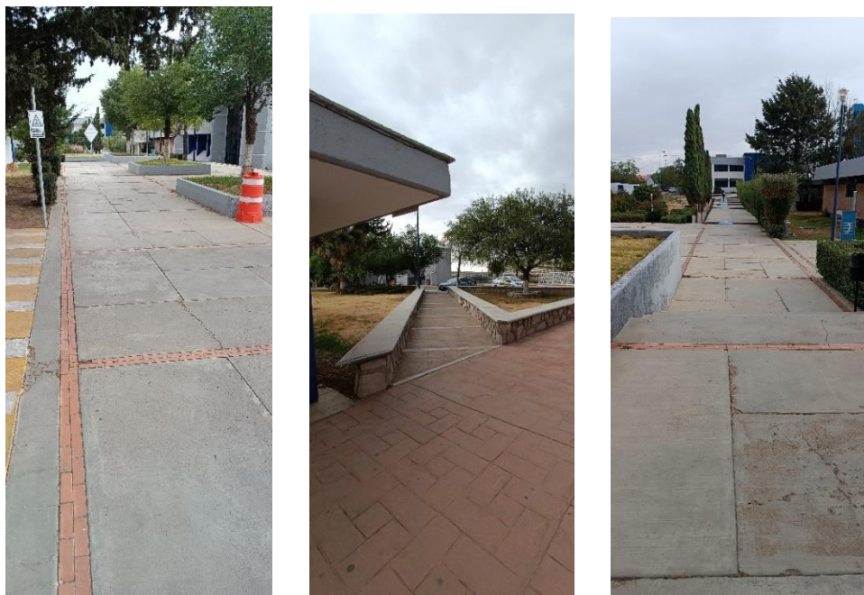
Andador edificio F, J y B respectivamente
