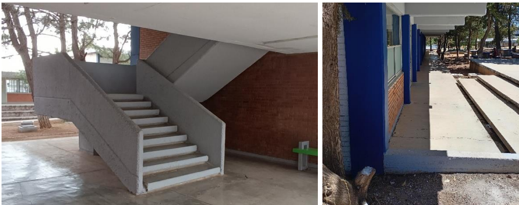
Escaleras edificio M y escalinata del edificio T
