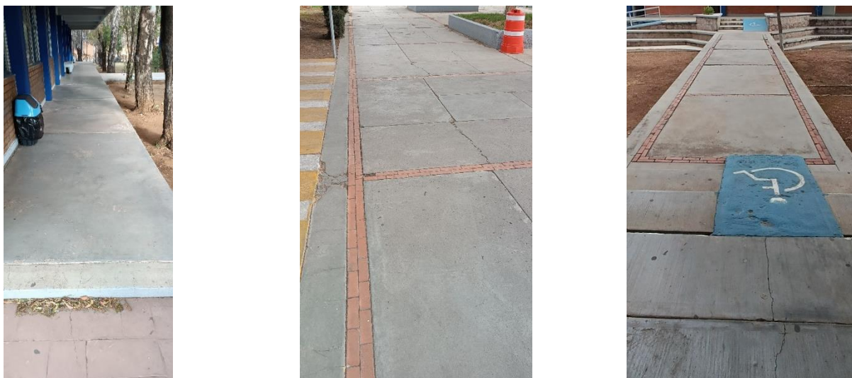
Concreto pulido y concreto pulido con detalle, cambio de textura en andador y rampa
