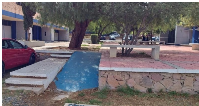
Rampa de la plaza entre el edificio X y W
