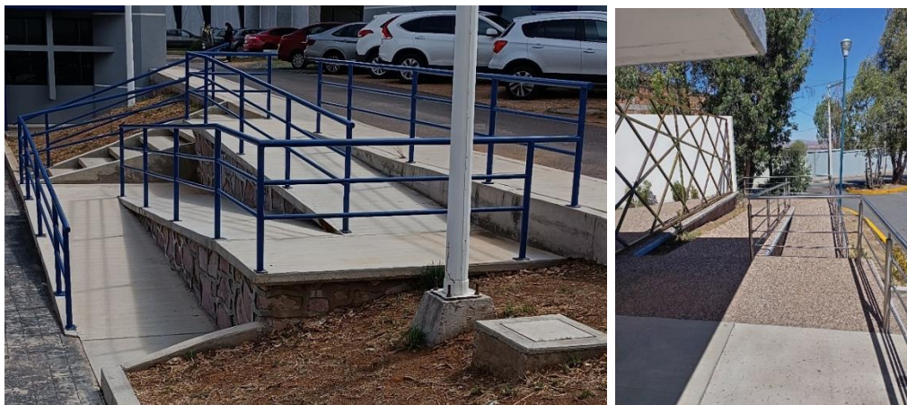
Barandal de rampa edificio Z y sala fundadores
