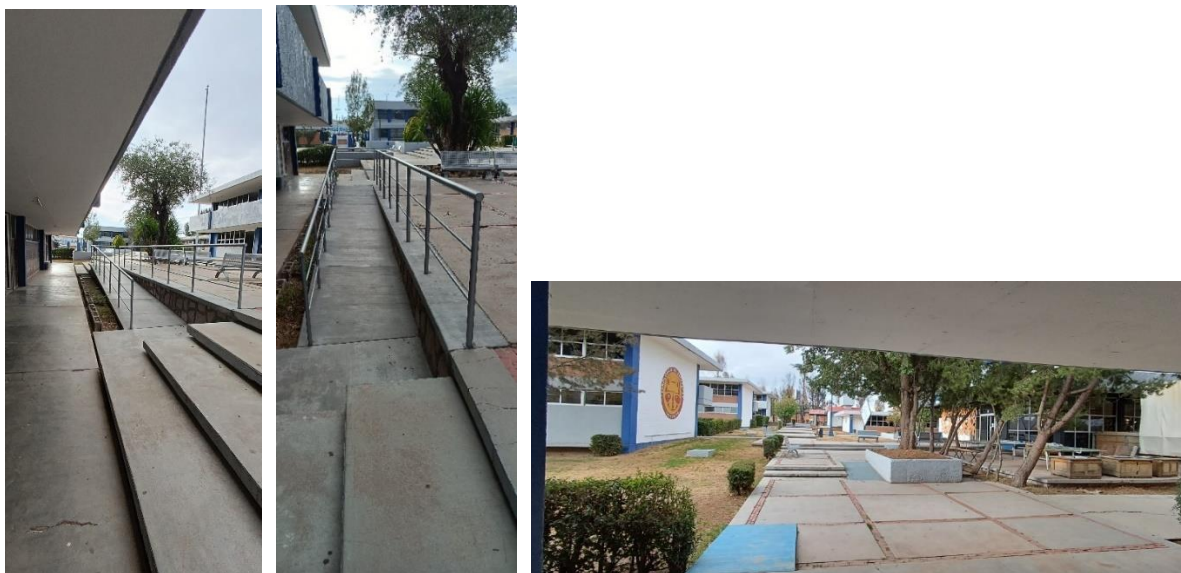
Rampa del edificio L, con barandal y rampas en andadores de cafetería con edificio M y J
