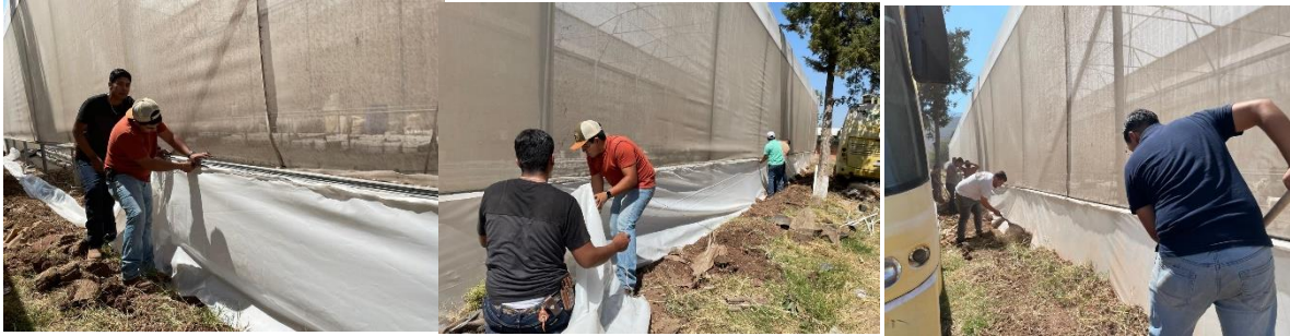
Anexo 11. Instalación del plástico en el invernadero
