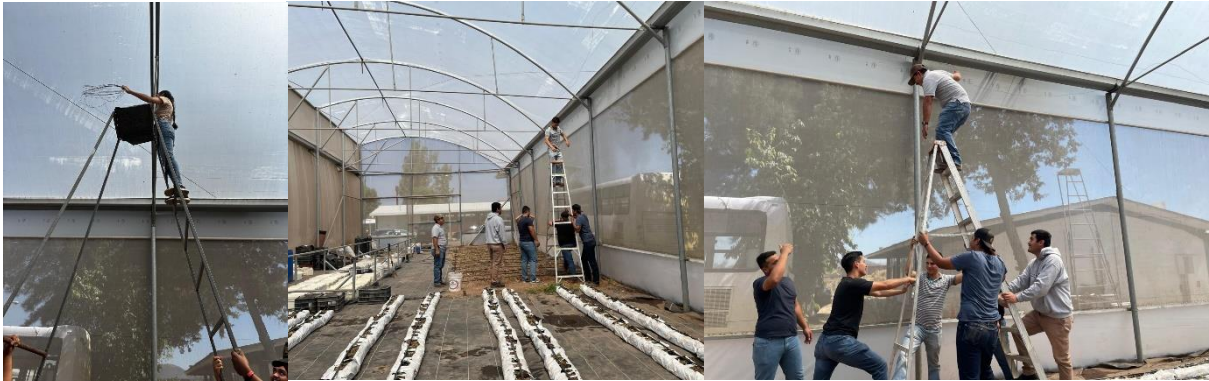
Anexo 12. Instalación de la base del tutorado con alambre
