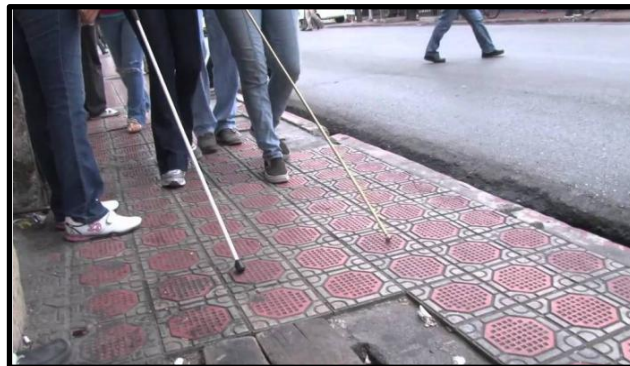
Figura 10.- Invidentes caminando cerca de una alcantarilla.
