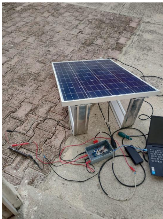
Figura 4. 13: Monitoreo de Panel Fotovoltaico.
