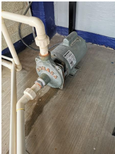
Figura 51: Fuga en el motor.
