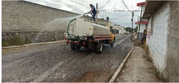
Ilustración 26 Base hidráulica
