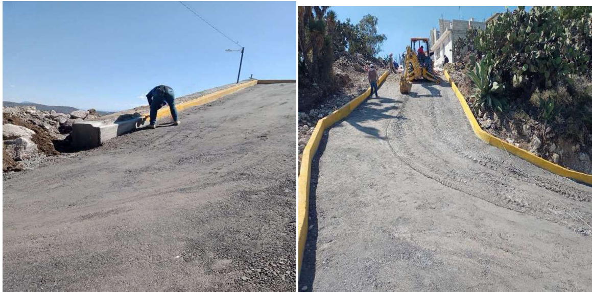
Ilustración 56 Pintura esmalte color amarillo sobre guarniciones
