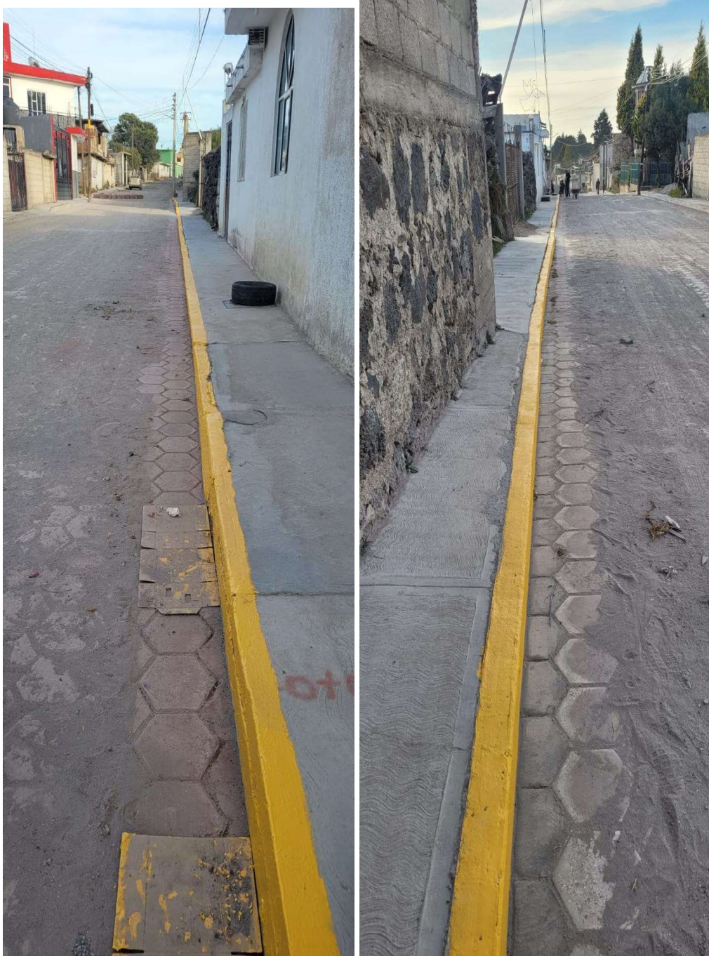
Ilustración 32 Balizado sobre guarniciones de concreto
