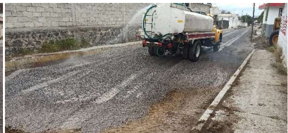
Ilustración 25 Base hidráulica
