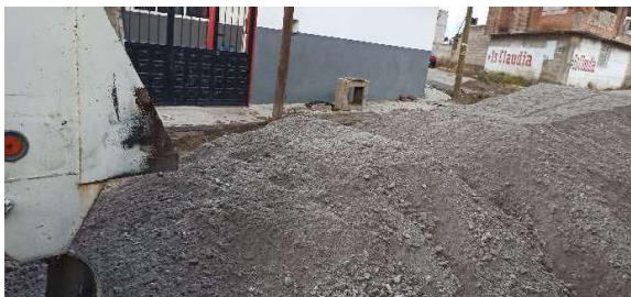
Ilustración 24 Base hidráulica
