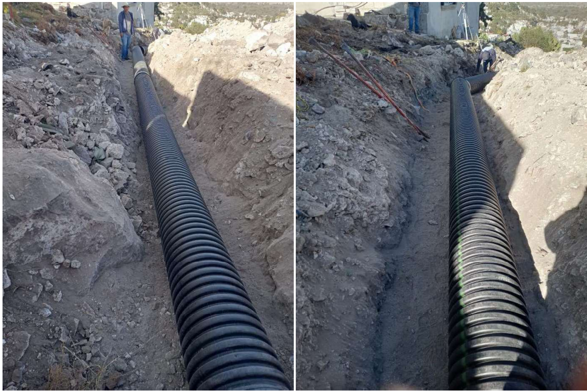
Ilustración 43 Colocación de tubería de drenaje sanitario P.E.A.D.
