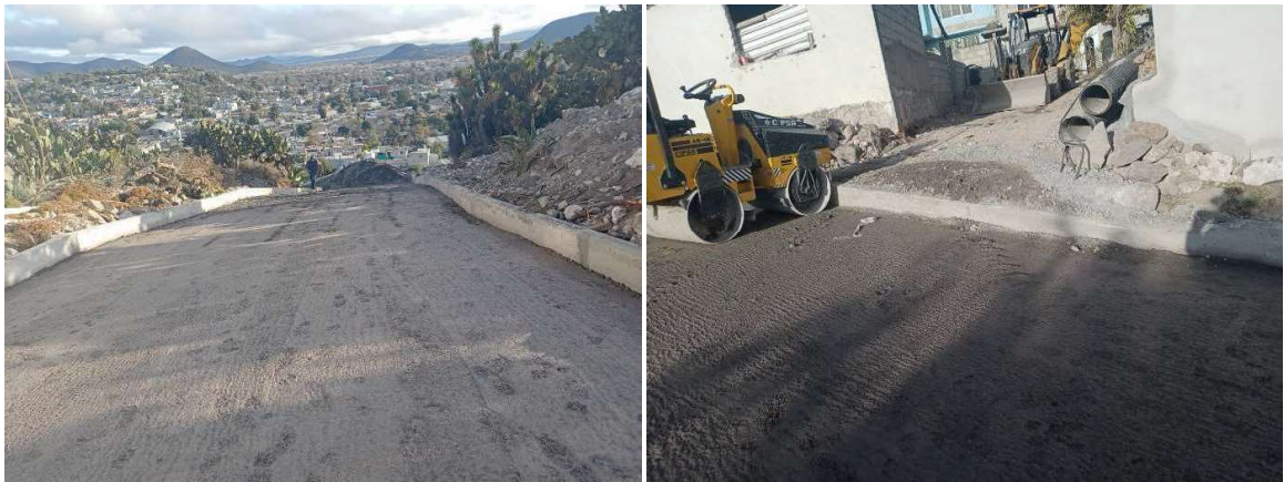
Ilustración 50 Colocación y compactación de base hidráulica
