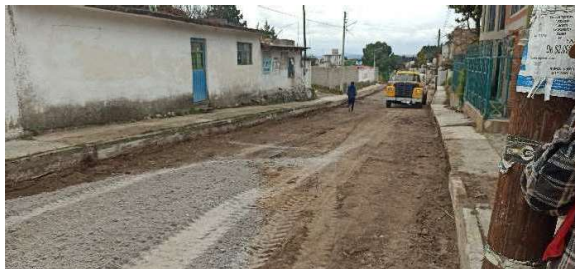
Ilustración 26 Base hidráulica
