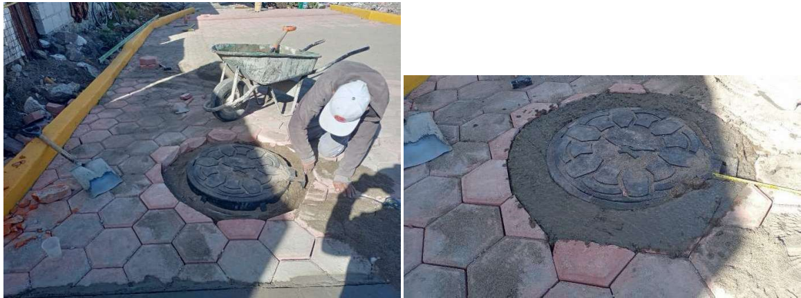
Ilustración 54 Colocación de brocales
