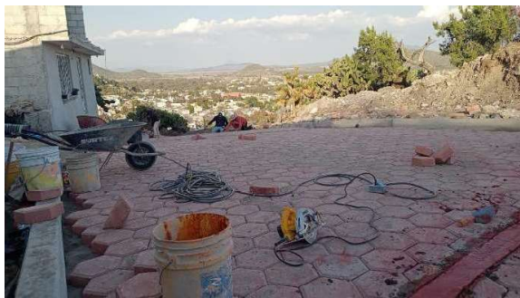
Ilustración 51 Colocación de adocreto hexagonal
