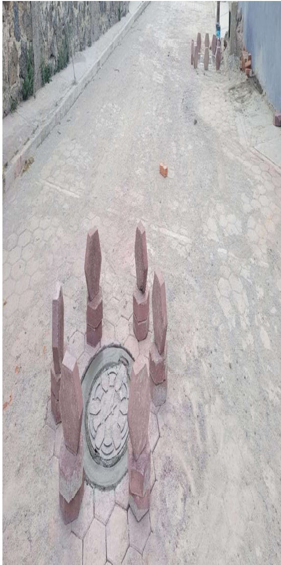
Ilustración 30 Renivelación de pozos de visita
