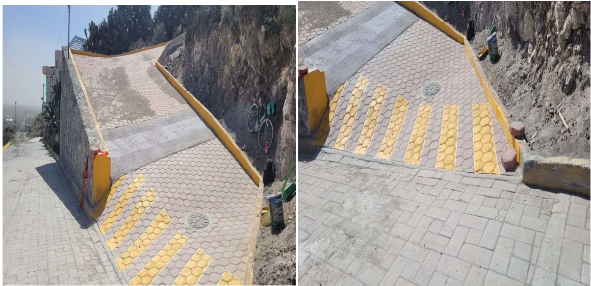
Ilustración 56 Pintura esmalte color amarillo sobre guarniciones
