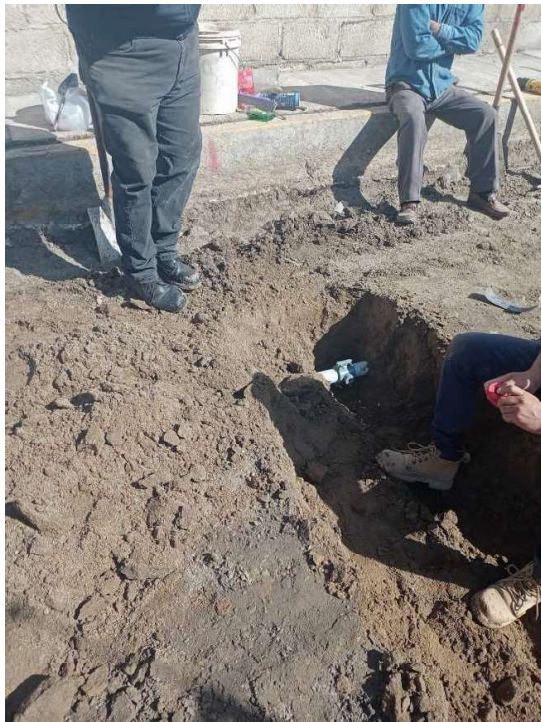
Ilustración 19 Reparación Toma domiciliaria
