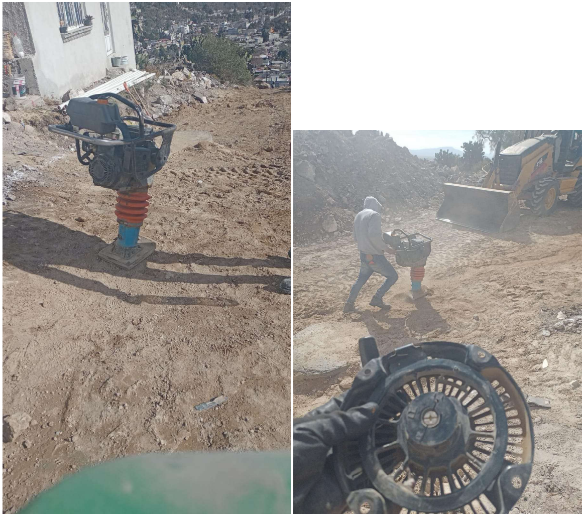
Ilustración 44 Plantilla Apisonada, así como compactación sobre las tuberías
