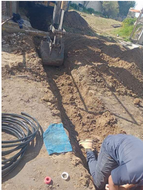
Ilustración 21 Reparación toma domiciliaria
