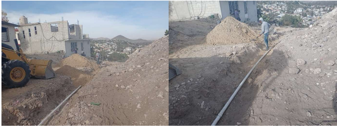
Ilustración 41 Excavación y colocación de tubería de P.V.C. para agua potable
