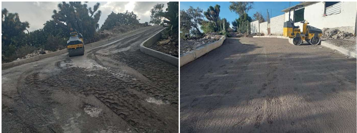
Ilustración 49 Compactación y colocación de base hidráulica
