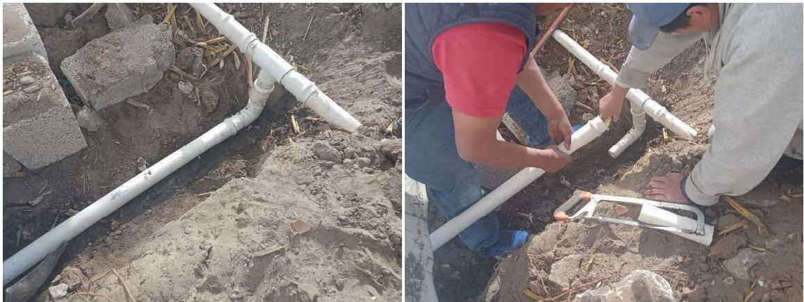
Ilustración 46 Conexión de tubería de P.V.C. a red de agua potable existente
