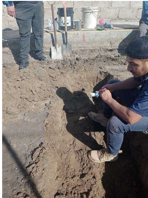
Ilustración 22 Reparación toma domiciliaria
