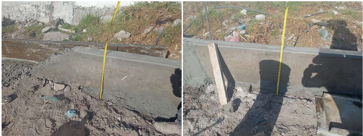
Ilustración 48 Construcción de guarniciones
