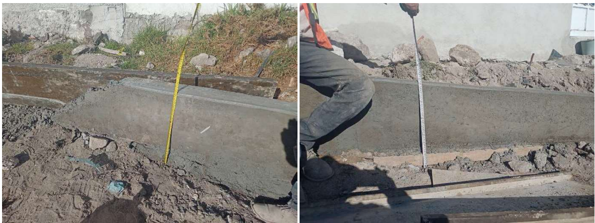
Ilustración 47 Construcción de guarniciones
