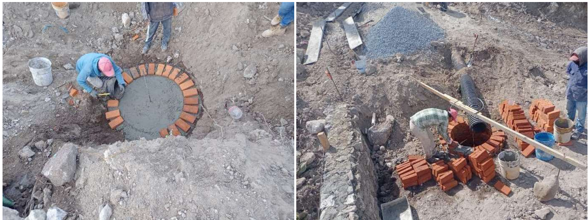
Ilustración 45 Construcción de pozo de visita tipo común
