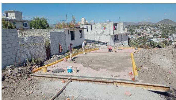
Ilustración 52 Colocación de adocreto hexagonal
