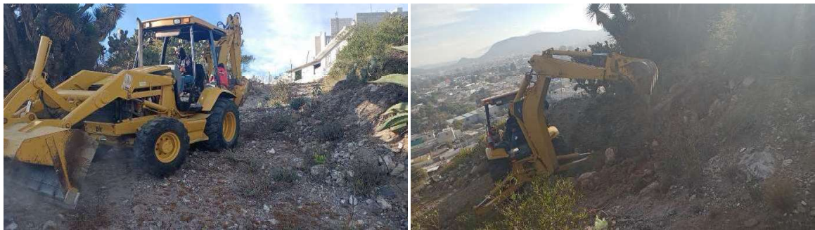
Ilustración 37 Excavación medio mecánicos
