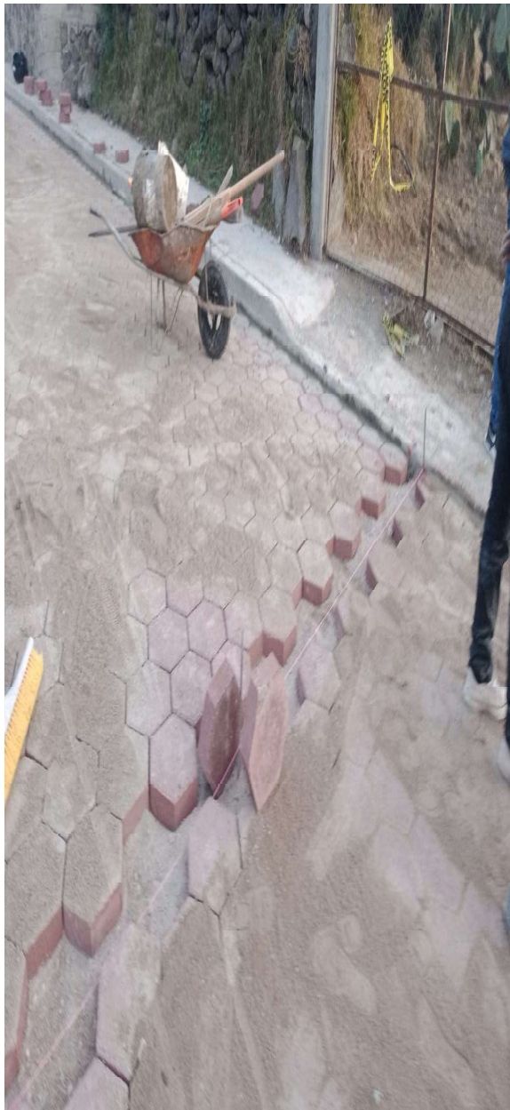
Ilustración 29 Colocación de Adocreto hexagonal
