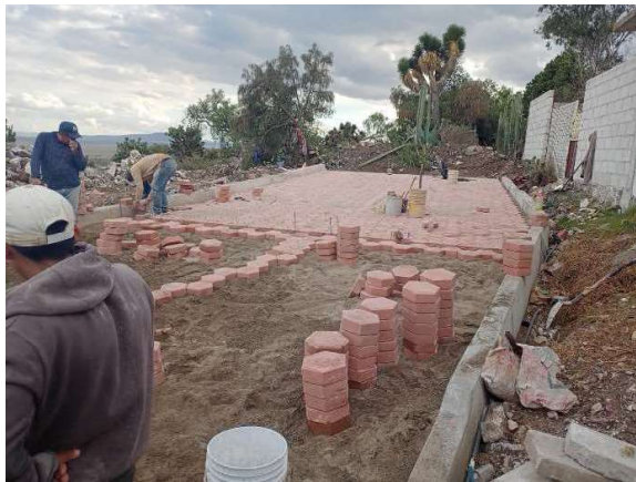
Ilustración 51 Colocación de adocreto hexagonal
