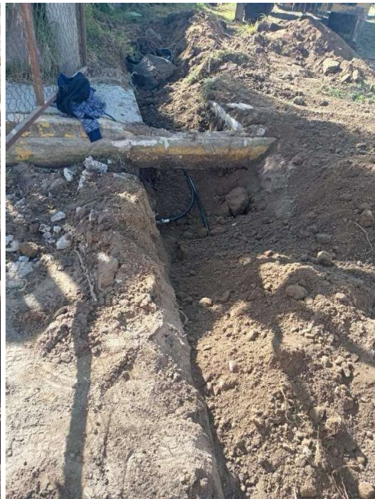
Ilustración 20 Reparación toma domiciliaria
