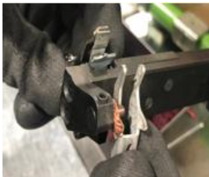
Ilustración 75 Se procede a realizar esto con ambos extremos de la trencilla de cobre, fuente de Schneider Electric.
