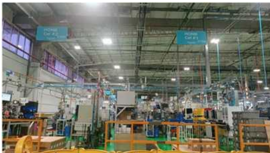
Figura 1 Líneas de producción de interruptores termomagnéticos HOMB, QO3P, HOMM y QO2P, fuente de Schneider Electric.
