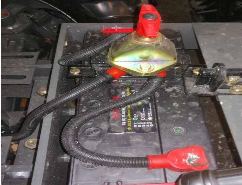
Imagen 12. Montaje de batería, cables y componentes eléctricos
