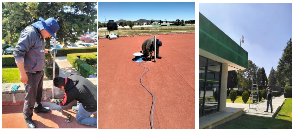
Figura 12.1 – Instalación física de puntos de acceso H3C en edificios del ITA
