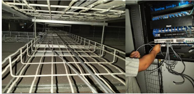
Figura 14.1 Instalación del cableado estructurado en el Edificio X
