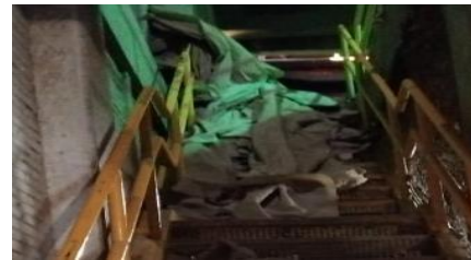
Escalera obstruida de acceso, pulpers a pastas.
