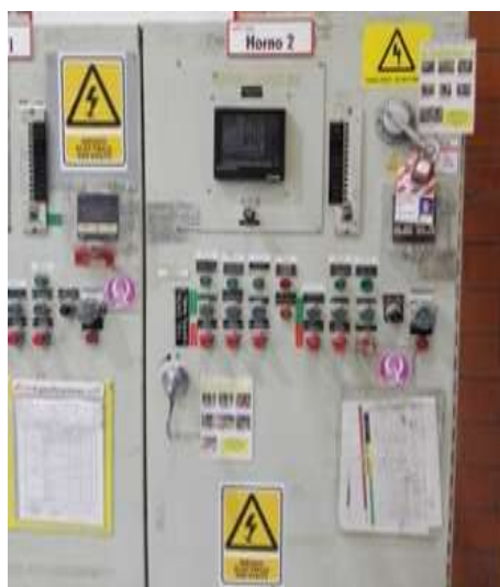
Figura 17 Colocación de LOTO [Fuente: Propia, 2018]
