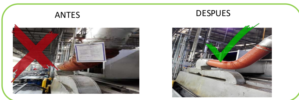
Figura 22 Cambio de manguera de campana de extracción horno uno [Fuente: Propia, 2018]
