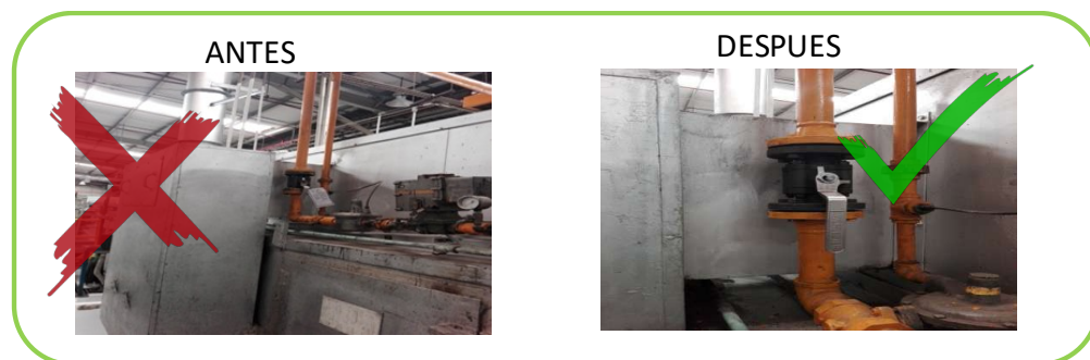
Figura 23 Cambio de válvula de alimentación de gas de Horno 2 [Fuente: Propia, 2018]
