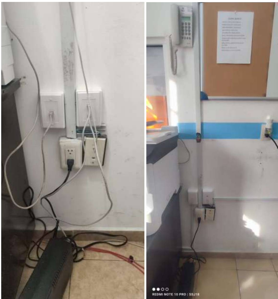
Figuras 38 y 39: Antes y después de la reestructuración de cableado en el área de desarrollo económico.
