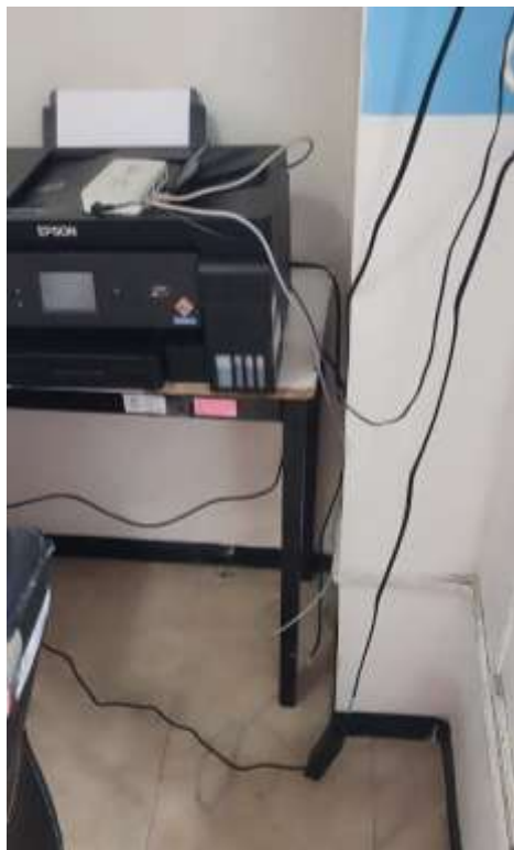
Figura 40: Evidencia antes de la reestructuración del cableado en el área de catastro.
