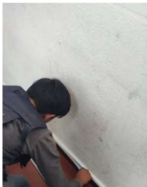
Figuras 12 y 13: Instalación de canaletas en columnas y esquineros del edificio.
