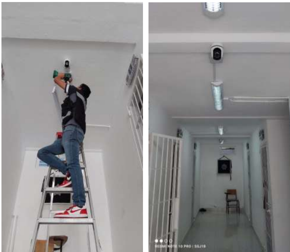
Figuras 62 y 63: Instalación de cámaras en el área de separos del ayuntamiento de Tetla.
