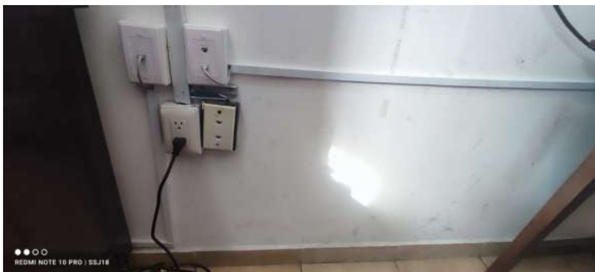
Figuras 19, 20 y21: Instalación de rosetas con Jack RJ45 en las diferentes áreas.
