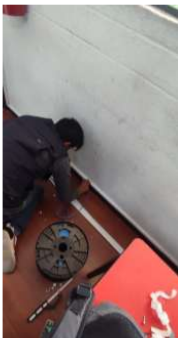
Figuras 17 y 18: Tendido de cable a través de las canaletas instaladas.
