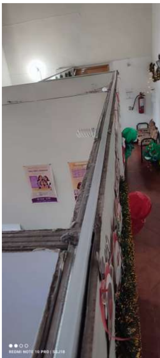
Figuras 9 y 10: Instalación de canaleta plástica sobre los muros de cada cubículo.
