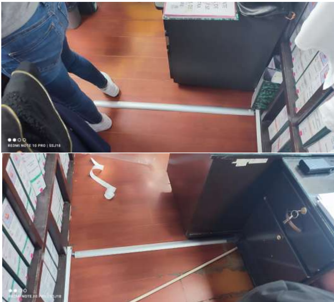
Figuras 13 y 14: Instalación de canaletas metálicas en el piso del edificio.
