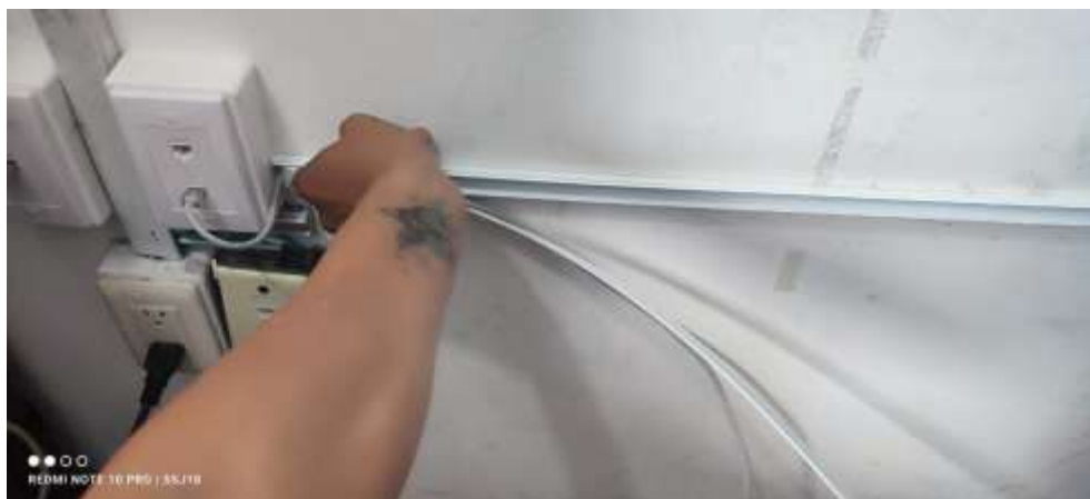
Figura 11: Instalación de canaletas en los muros del edificio.
