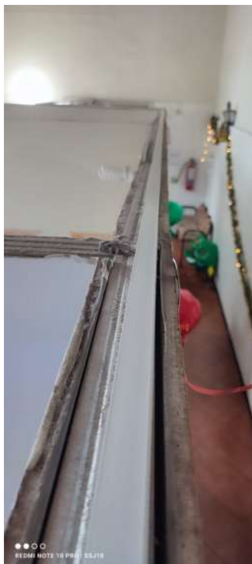
Figuras 9 y 10: Instalación de canaleta plástica sobre los muros de cada cubículo.
