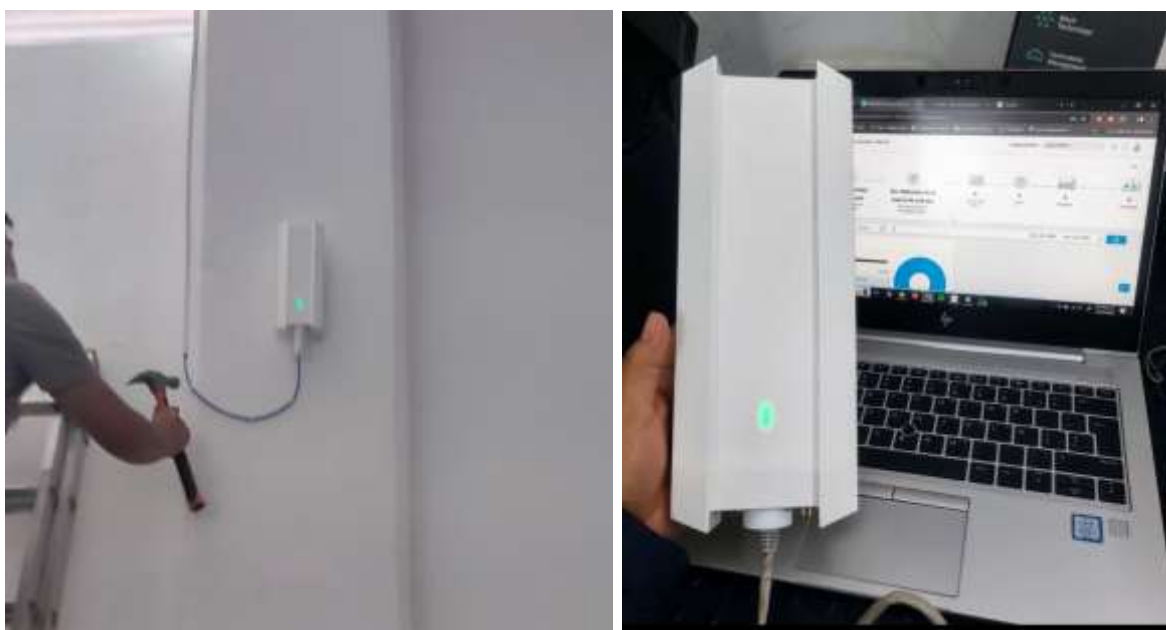
Figuras 36 y 37: instalación y configuración del AP TP-Link Omada EAP650 Outdoor en el auditorio de Tetla.
