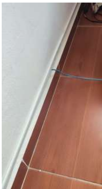
Figuras 17 y 18: Tendido de cable a través de las canaletas instaladas.
