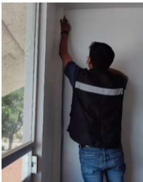
Figuras 12 y 13: Instalación de canaletas en columnas y esquineros del edificio.
