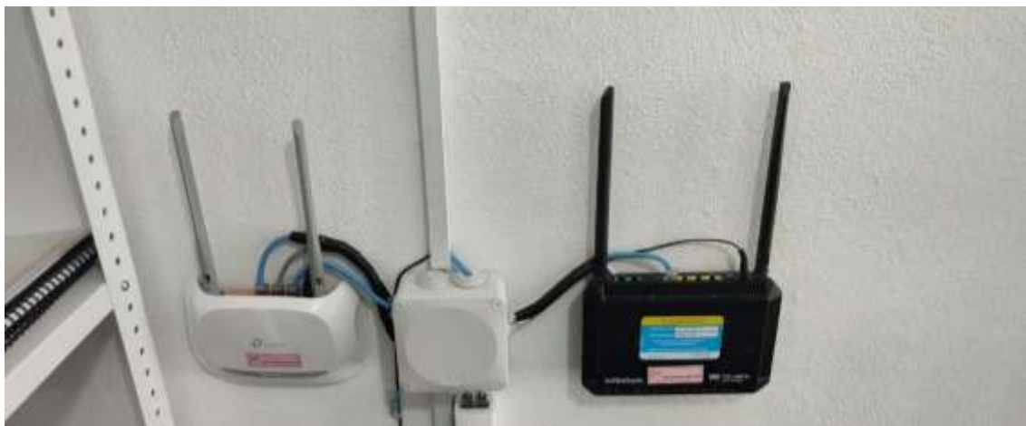
Figuras 28, 29 y 30: Instalación de routers TP-LINK TL-WR840N.
