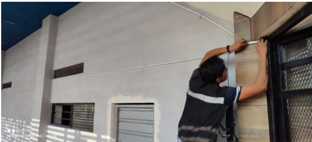
Figuras 15 y 16: Instalación de canaletas en los muros exteriores del edificio.
