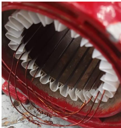
Ilustración 22 Montaje de los aislantes.
