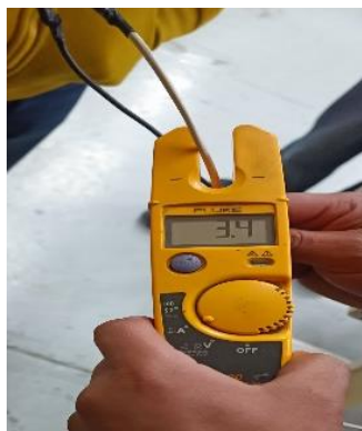
Ilustración 36 Medición sin el capacitor.
