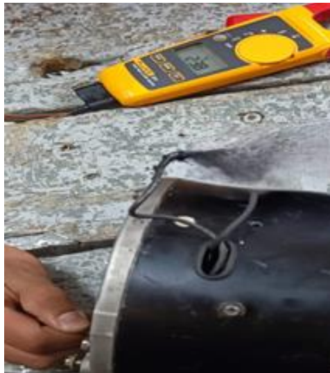
Ilustración 37 medición de temperatura.
