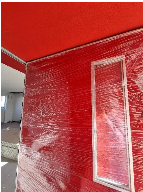
Figura 12. Instalación de puertas para aulas.
