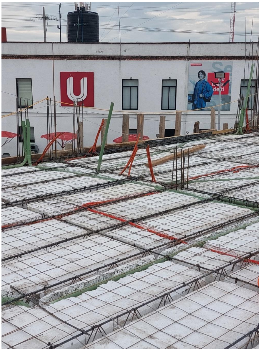
Huerta Muñoz, A. (2024, 30 de agosto). Losa reticular con malla electrosoldada 10 x 10 en proceso de construcción en aulas de la Preparatoria Santiago UPAEP [Fotografía]. Archivo personal.
