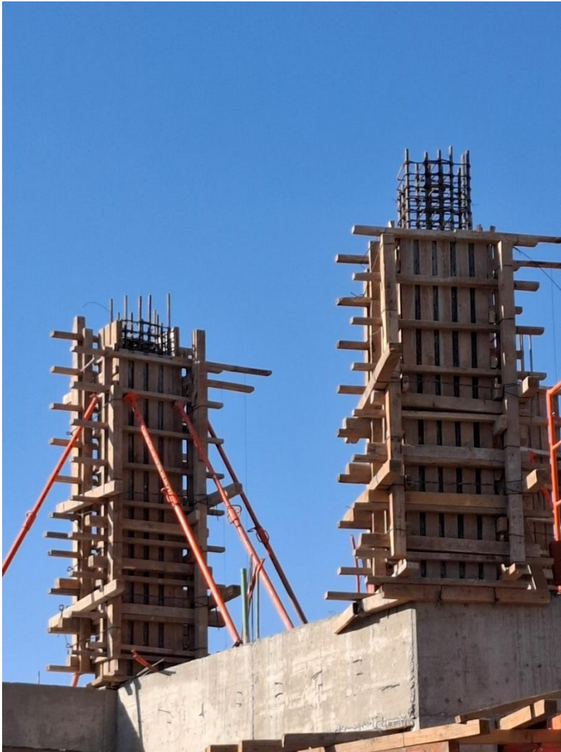
Figura 30. Cimbra de columnas en aulas de la Preparatoria Santiago UPAEP.
