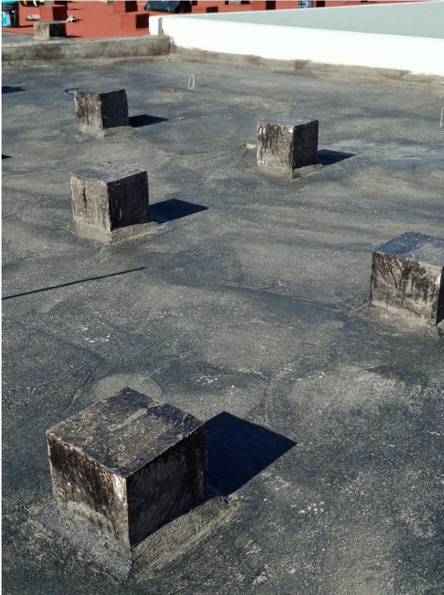
Figura 42. Huerta, A. (s.f.). Aplicación de sellador en la azotea antes de colocar impermeabilizante . [Fotografía]. Documentación personal.
