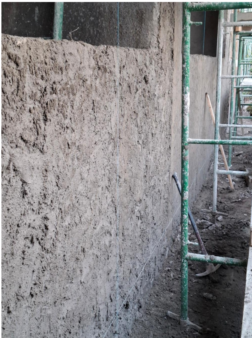
Figura 29. Revoque en muros con mortero aplicado con cuchara en aulas de la Preparatoria Santiago UPAEP.
