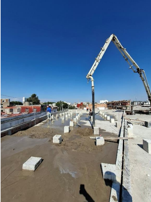
Figura 18. La imagen captura el proceso de fraguado del concreto recién vaciado en la losa de la última planta del edificio en construcción. La superficie del colado se observa uniforme y húmeda, indicando las primeras horas de fraguado inicial. En el entorno se aprecia la estructura de varillas, el sistema de cimbra ya retirado parcialmente en algunas zonas, y el horizonte urbano de fondo, lo que confirma la altura de la planta superior. Este momento es crucial para la resistencia final del concreto, por lo que se mantiene control de humedad mediante el curado. Se observa también la delimitación del área para evitar pisadas y daños mientras el concreto alcanza su resistencia mínima estructural.
