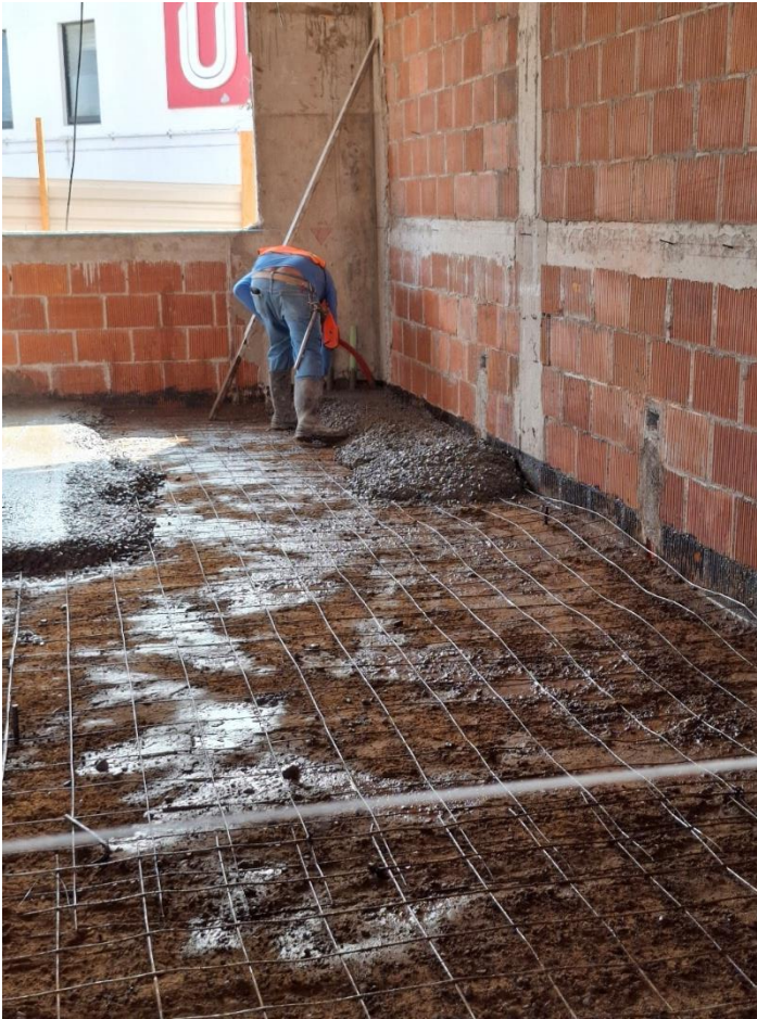
Figura 27. Vaciado de concreto para firme en aulas de la Preparatoria Santiago UPAEP.
