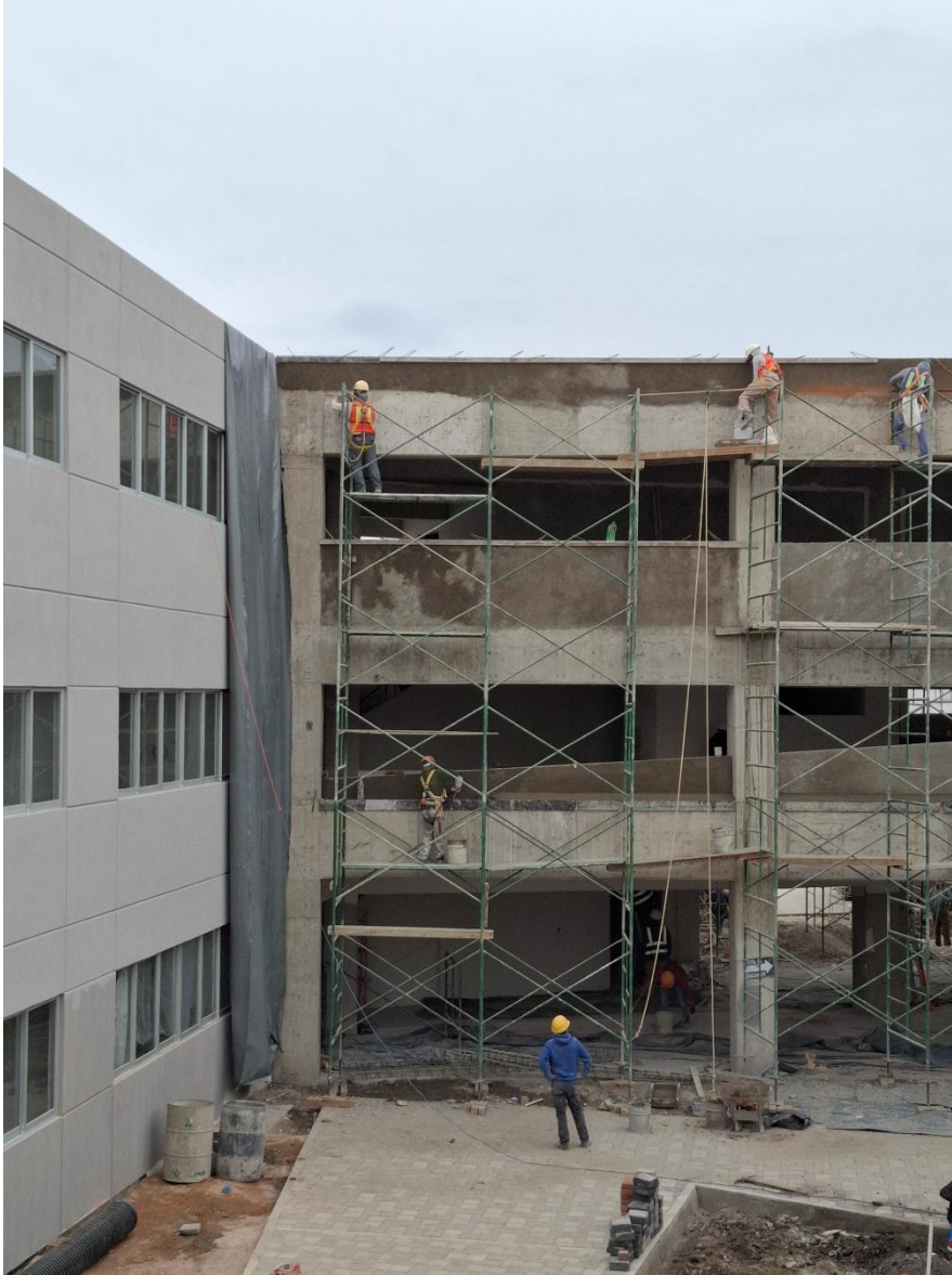
Figura 36. Revoque de muros en aulas de Preparatoria Santiago UPAEP.
