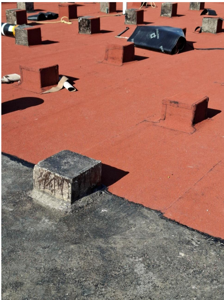
Figura 43. Aplicación de membrana prefabricada impermeabilizante en aulas de Preparatoria Santiago UPAEP
