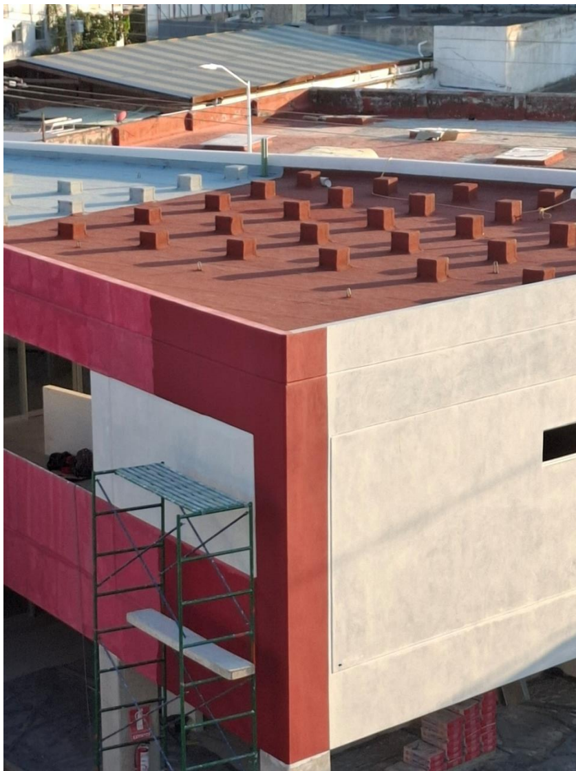
Figura 44. Membrana prefabricada impermeabilizante en aulas de Preparatoria Santiago UPAEP
