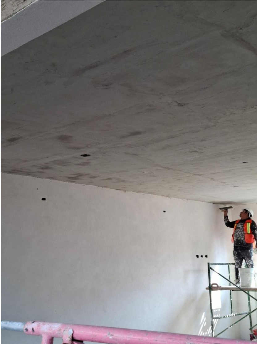
Figura 38. Aplicación de estuco sobre plafón en aulas de Preparatoria Santiago UPAEP.
