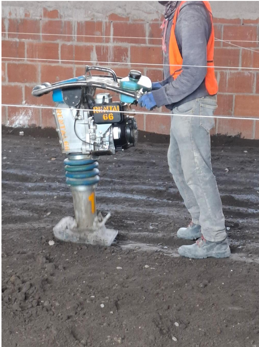
Figura 26. Compactado de terracerías con vibro en aulas de la Preparatoria Santiago UPAEP.
