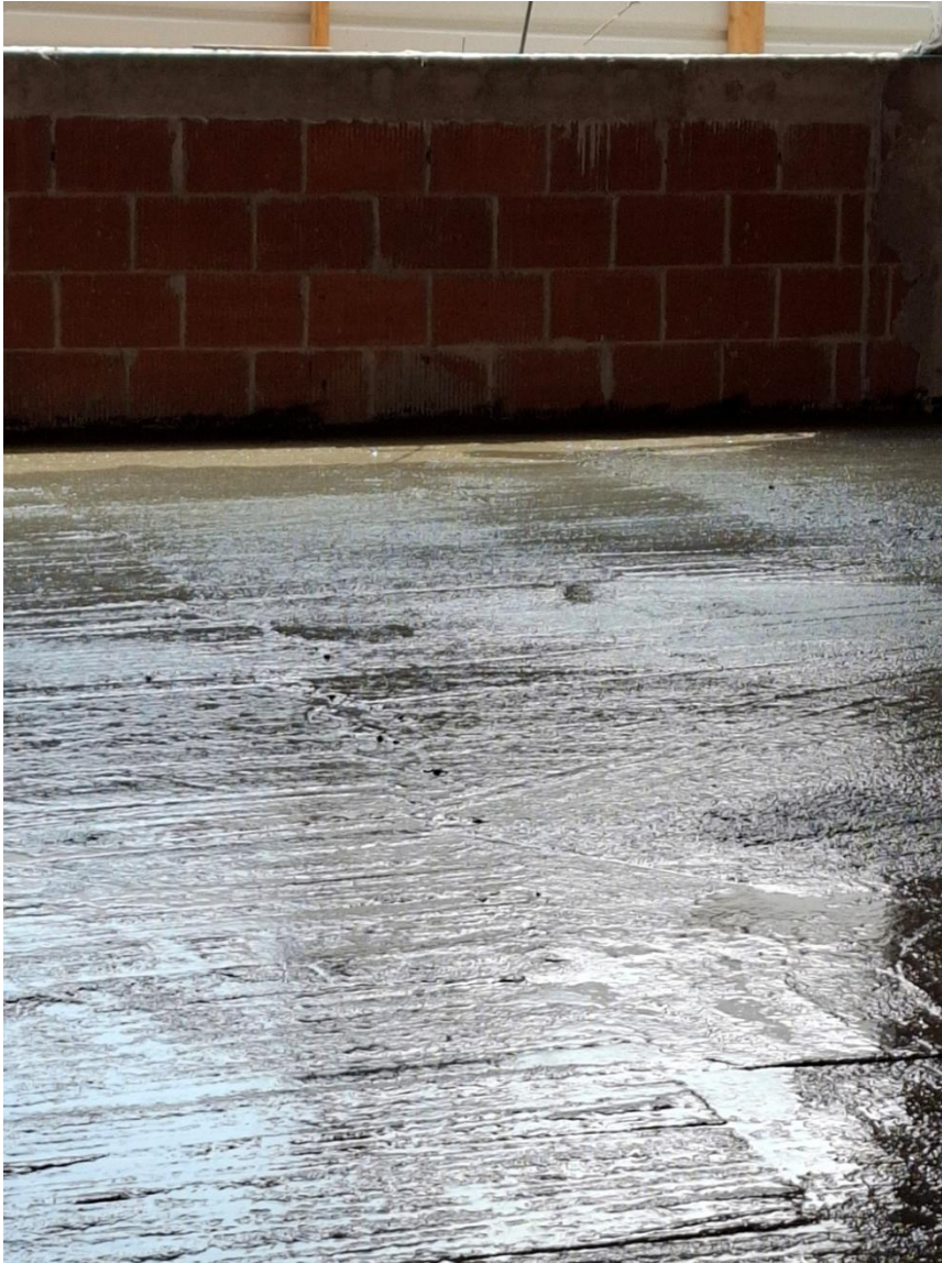
Figura 28. Firme de concreto en proceso de fraguado en aulas de la Preparatoria Santiago UPAEP.
