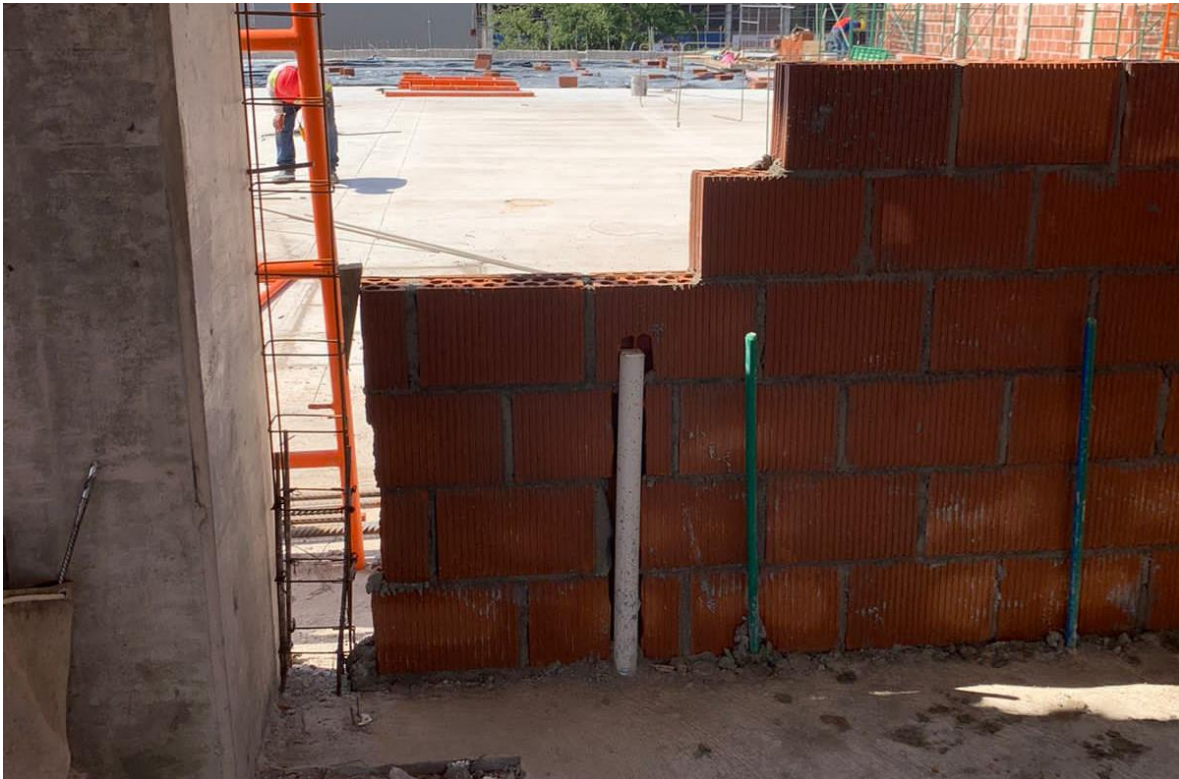
Figura 35. Pegado de ladrillo para muros en aulas de Preparatoria Santiago UPAEP
