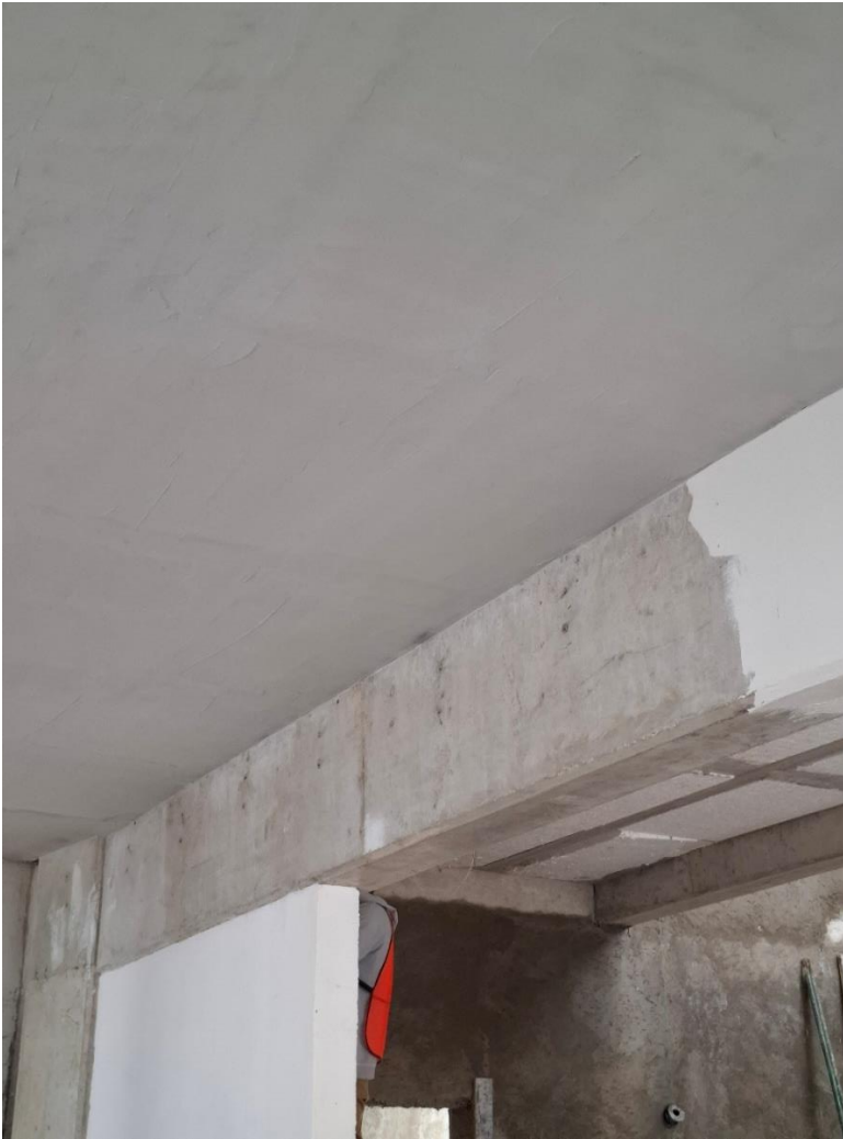
Figura 39. La imagen muestra la aplicación de estuco sobre traveses estructurales dentro de un aula en construcción. El personal utiliza llanas metálicas para extender el mortero fino sobre la superficie del concreto, con el objetivo de nivelar, cubrir imperfecciones y lograr un acabado uniforme. Esta actividad forma parte del proceso de acabados, mejorando tanto la estética como la integración visual de los elementos estructurales con el resto del espacio.
