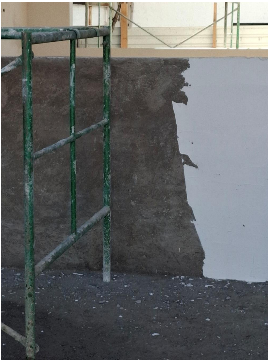
Figura 37. En esta imagen se mira de aplicación de la primera capa de estuco sobre muros interiores. Se usan llanas metálicas para extender el material sobre una superficie previamente revocada. Esta capa base tiene como objetivo nivelar imperfecciones, generar adherencia uniforme y proporcionar una superficie sólida para recibir las capas siguientes de acabado fino o pintura.
