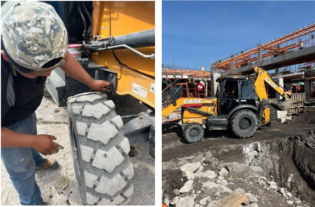
Figura 17. Resolución de problemas para evitar tiempos muertos y coordinar de manera adecuada. Retroexcavadora parada por temas de llanta sin aire.
