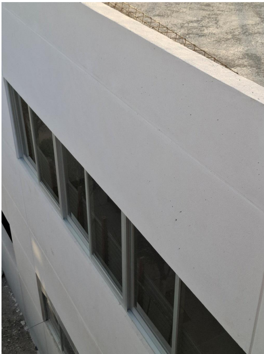
Figura 41. La imagen muestra las ventanas de aluminio ya instaladas en las aulas de una edificación escolar en etapa final de obra. Las ventanas presentan marcos de aluminio anodizado color natural, con hojas corredizas y cristales transparentes de seguridad, distribuidas de forma simétrica en los vanos previamente habilitados en los muros.
