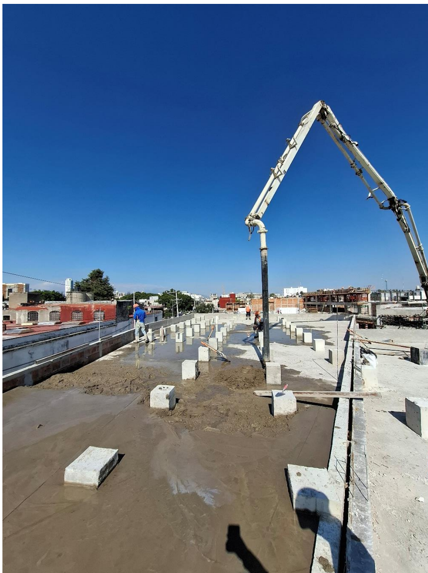
Figura 34. Vaciado de concreto en aulas de Preparatoria Santiago UPAEP
