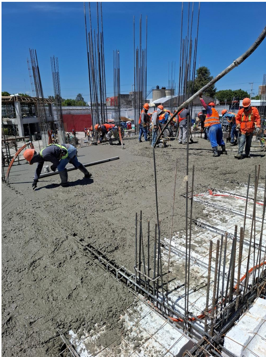
Figura 25. Vaciado de concreto para losa artesonada en aulas de la Preparatoria Santiago UPAEP.
