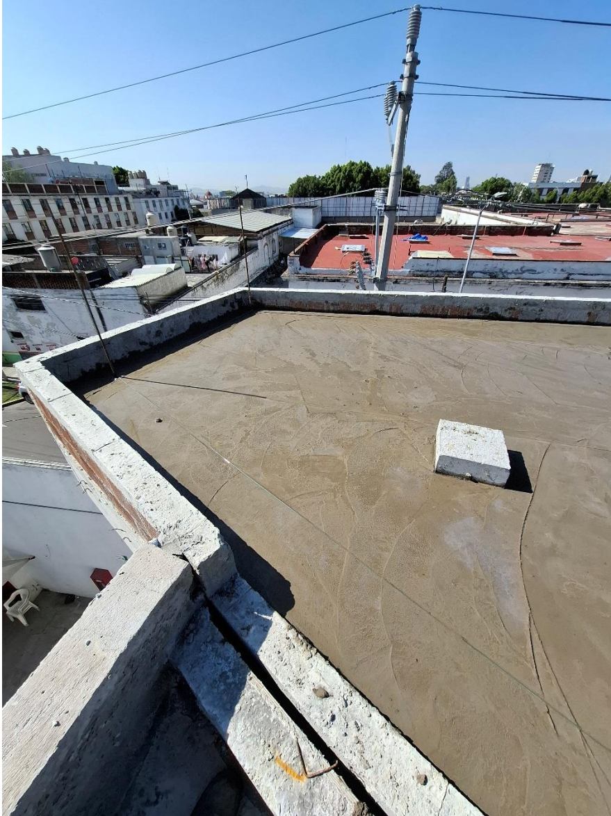
Figura 34. La imagen captura el proceso de fraguado del concreto recién vaciado en la losa de la última planta del edificio en construcción. La superficie del colado se observa uniforme y húmeda, indicando las primeras horas de fraguado inicial. En el entorno se aprecia la estructura de varillas, el sistema de cimbra ya retirado parcialmente en algunas zonas, y el horizonte urbano de fondo, lo que confirma la altura de la planta superior. Este momento es crucial para la resistencia final del concreto, por lo que se mantiene control de humedad mediante el curado. Se observa también la delimitación del área para evitar pisadas y daños mientras el concreto alcanza su resistencia mínima estructural.
