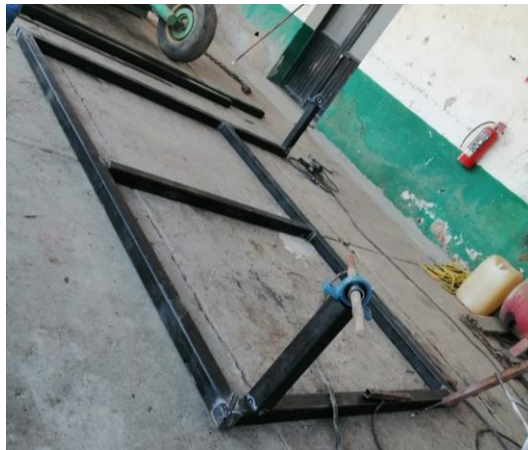
Figura 50. Construcción de estructura
