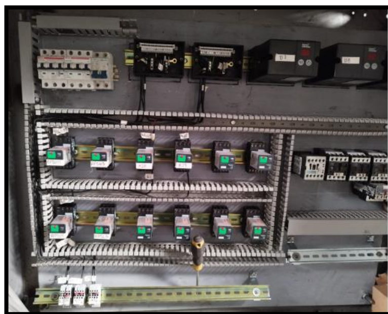
Imagen 91 colocación de componentes en placa del tablero de canal de distribución
