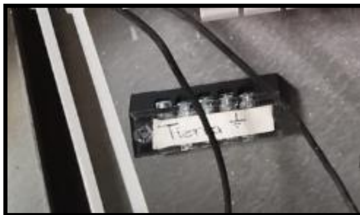
Imagen 104 Colocación de clema para tierras físicas
