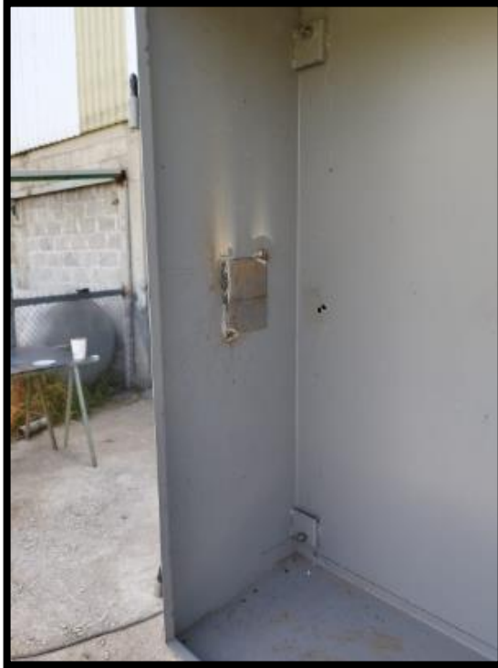
Imagen 55 colocación de láminas a Gabinete
