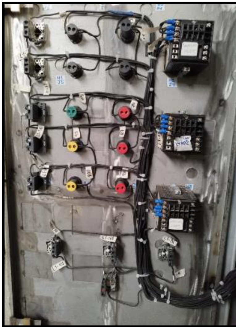
Imagen 101 Conexión de componentes con etiquetado
