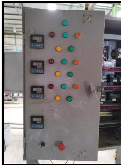
Imagen 70 colocación de componentes del tablero del horno de fundición
