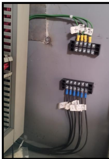
Imagen 76 Clema de interconexión de neutros y tierras
