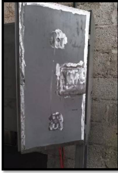
Imagen 69 Montaje de puertas al gabinete
