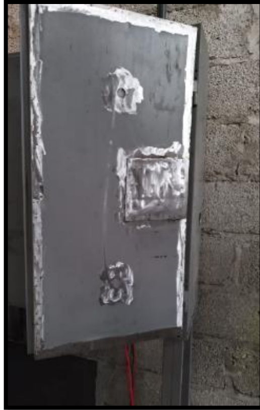
Imagen 56 reconstrucción de puertas de gabinete
