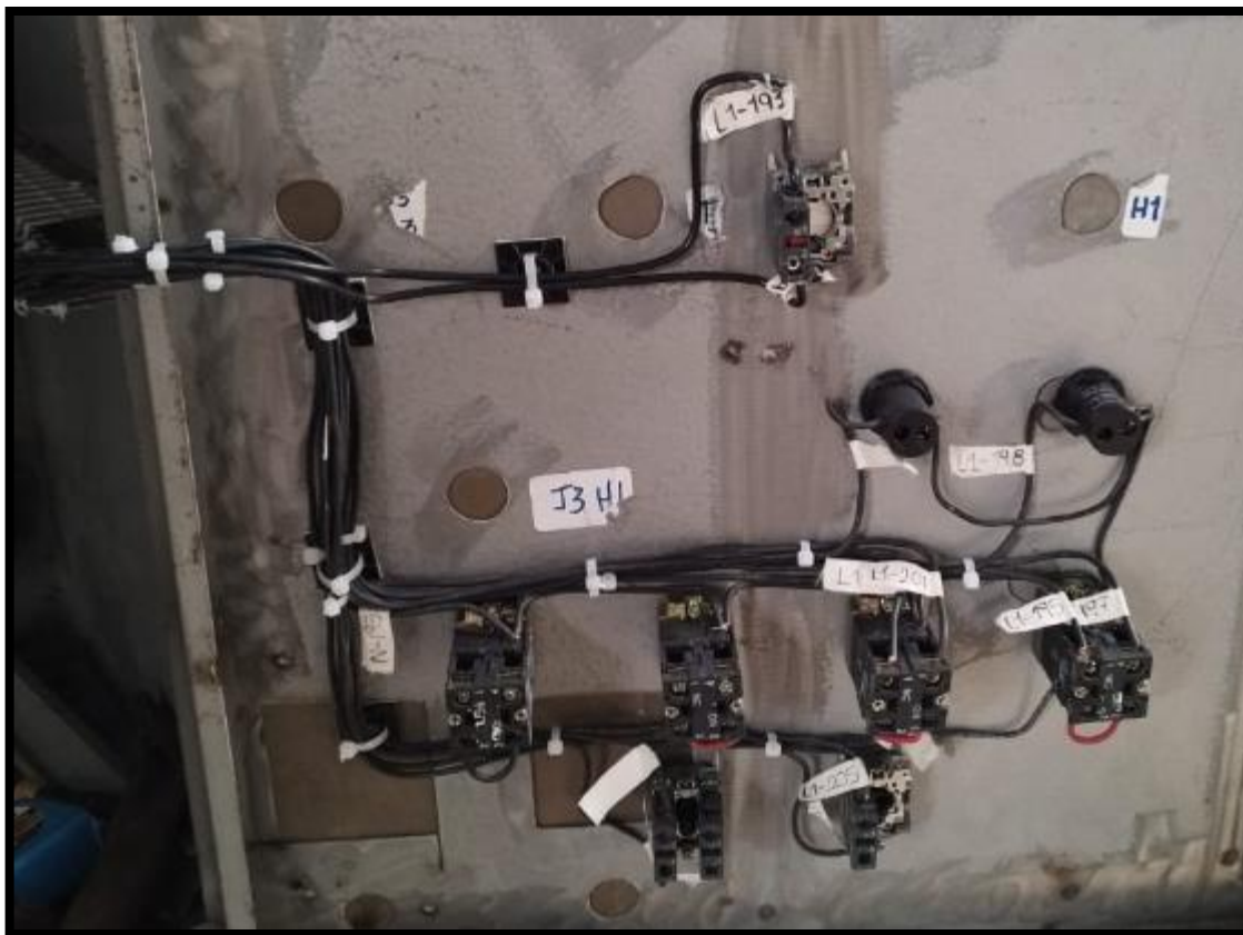
Imagen 102 conexión de componentes y etiquetado de puerta izquierda
