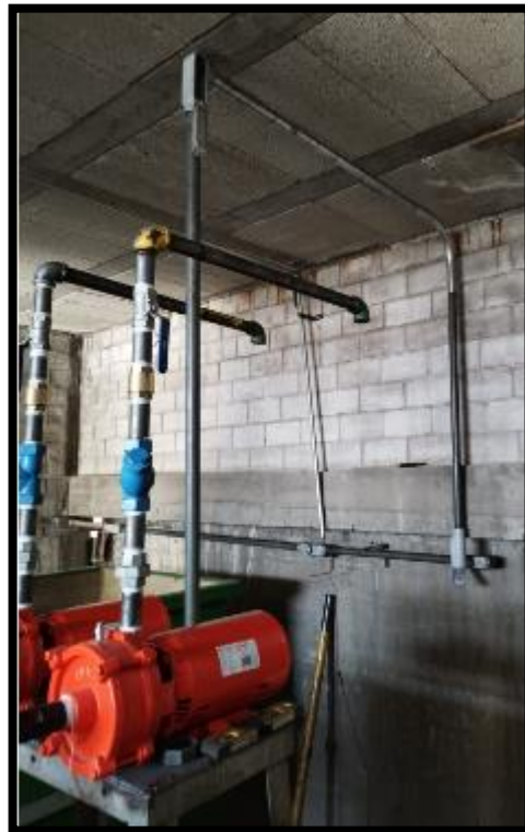
Imagen 120 instalación de tuberías para conexión de bombas
