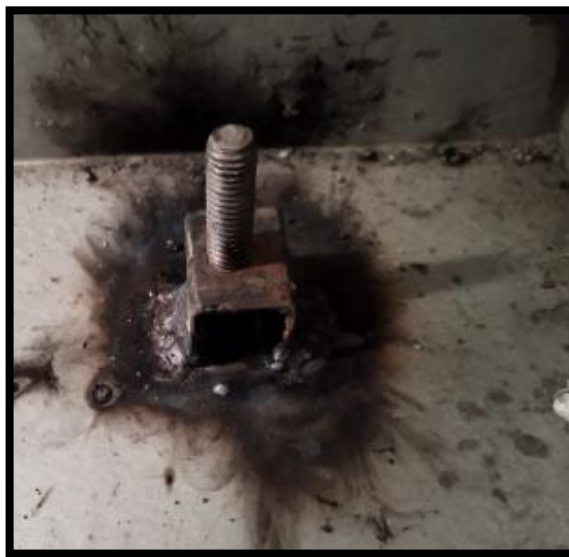
Imagen 82 Bases para placa de montaje de canal de distribución
