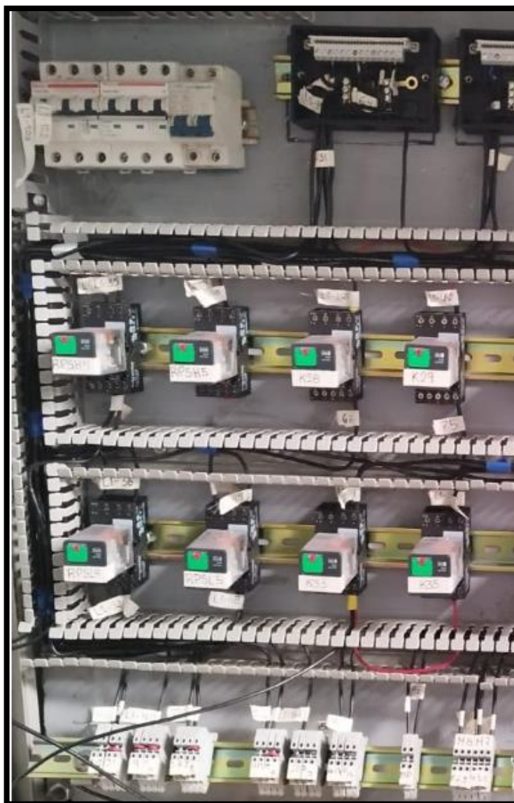
Imagen 93Cableado para el encendido del canal de distribución
