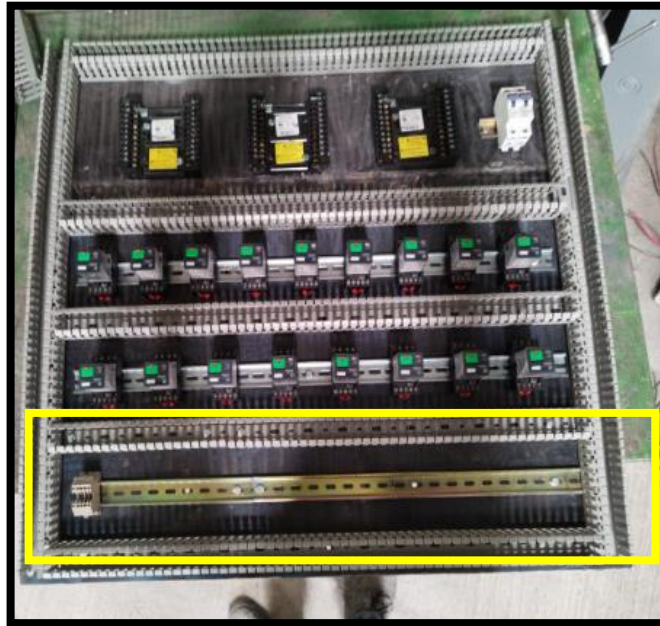
Imagen 64 Nivel 4 de la placa de montaje
