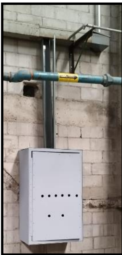
Imagen 117 Fijación de tablero y armado de tubería correspondiente
