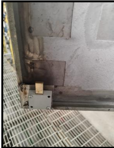
Imagen 86 Colocación de cerraduras 2 de 2
