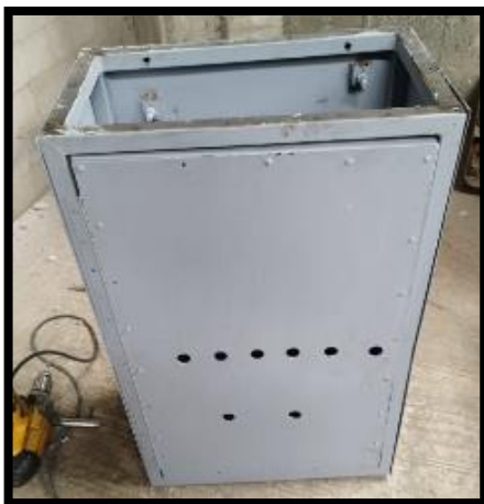
Imagen 116 Aplicación de pintura al tablero de control
