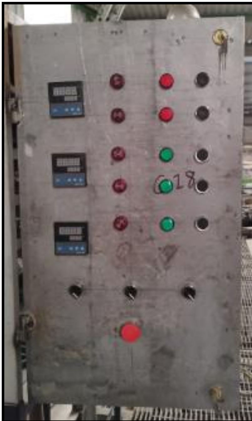
Imagen 96 Colocación de componentes en puerta izquierda
