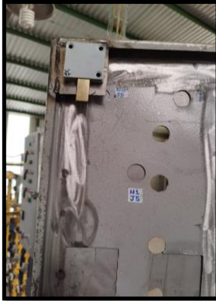
Imagen 85 Colocación de cerraduras 1 de 2
