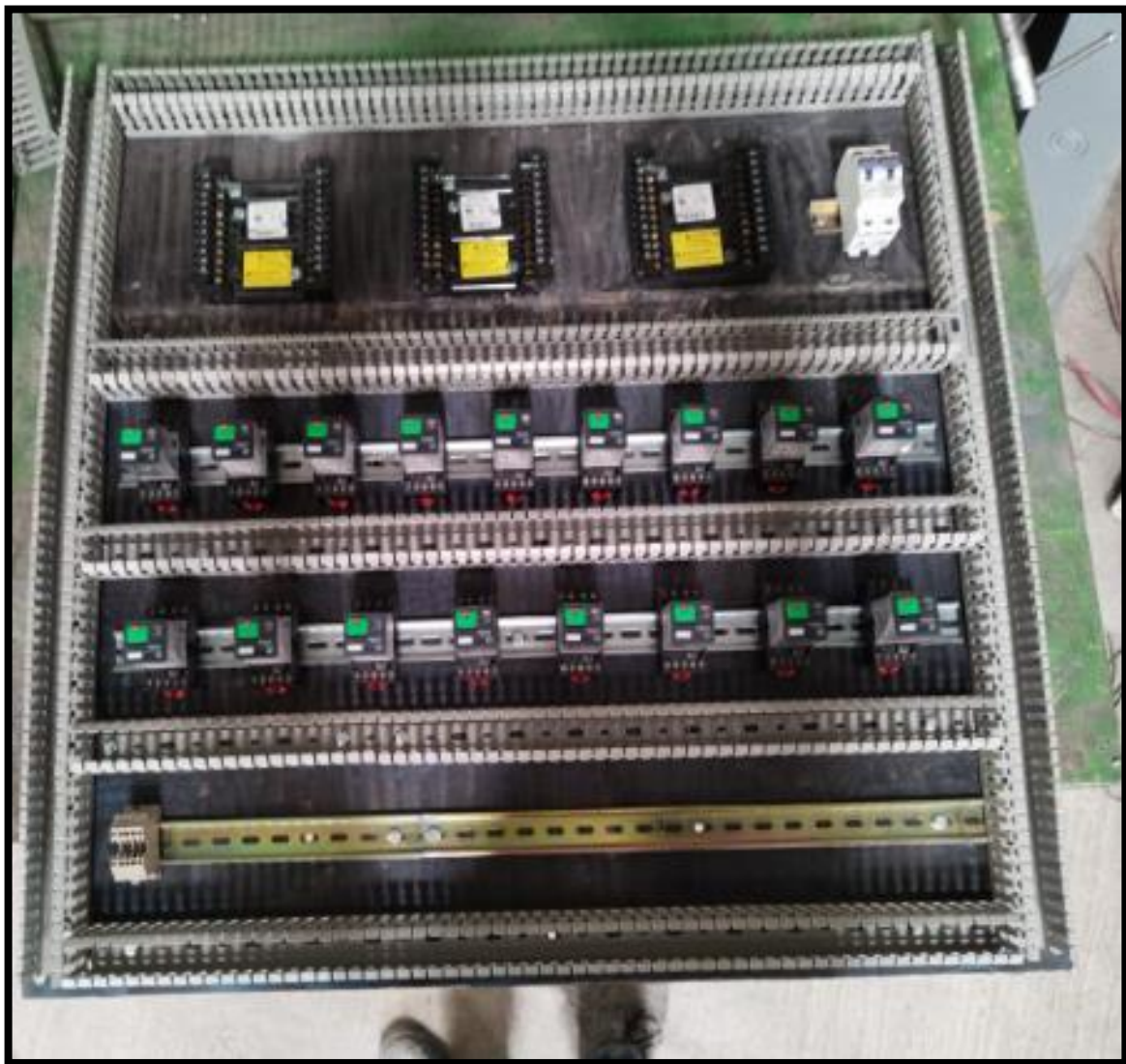
Imagen 61 colocación de componentes de la placa del horno de fundición
