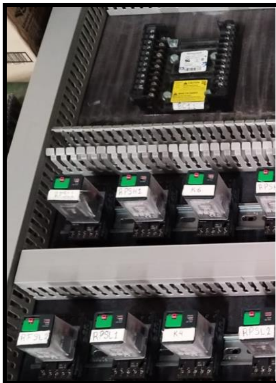
Imagen 66 Etiquetado de los relevadores
