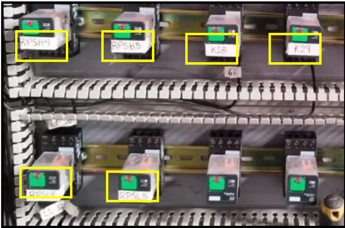
Imagen 92 Etiquetado de componentes
