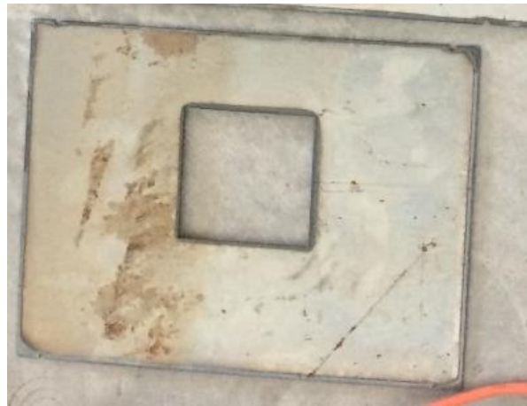
Figura 56. Tapadera frontal plegable del gabinete de control.
