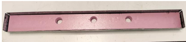
Figura 3.15. Instalación del aislamiento térmico en la carcasa y preparación de las tapas móviles con perforaciones para el paso de las tuberías.
