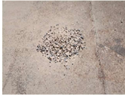
Ilustración 1: Material de subrasante apilado
