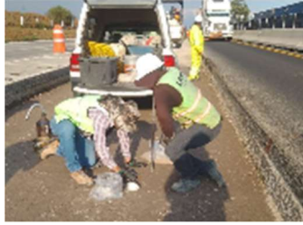
Ilustración 18: Extracción de material de cala de compactación
