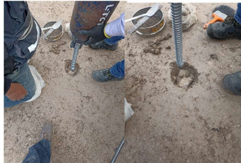
Ilustración 15: Llenado de cala de compactación con arena
