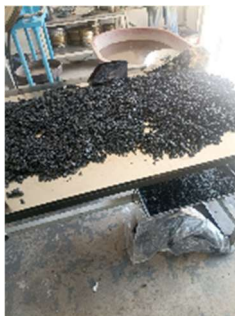
Ilustración 4S: Mezcla asfáltica tendida para enfriarse
