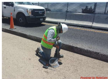
Ilustración 17: Excavación de cala para chequeo de compactaciones
