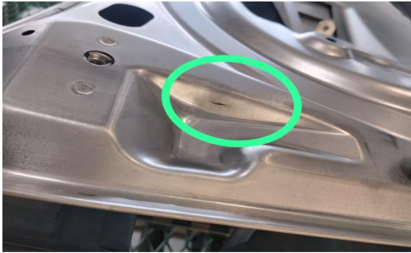
Imagen 3.11 Defectos de Lamina (Grieta o fisura)
