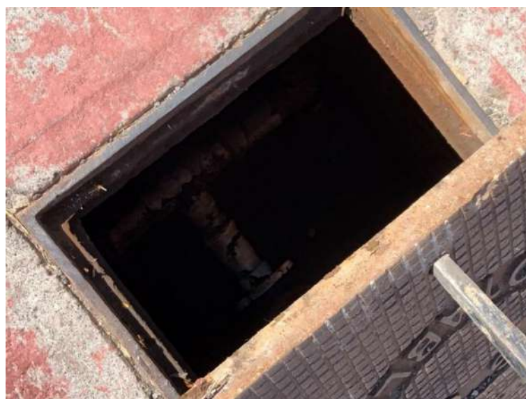
Figura 4.29 Apertura de registro de agua potable. Fuente propia.
