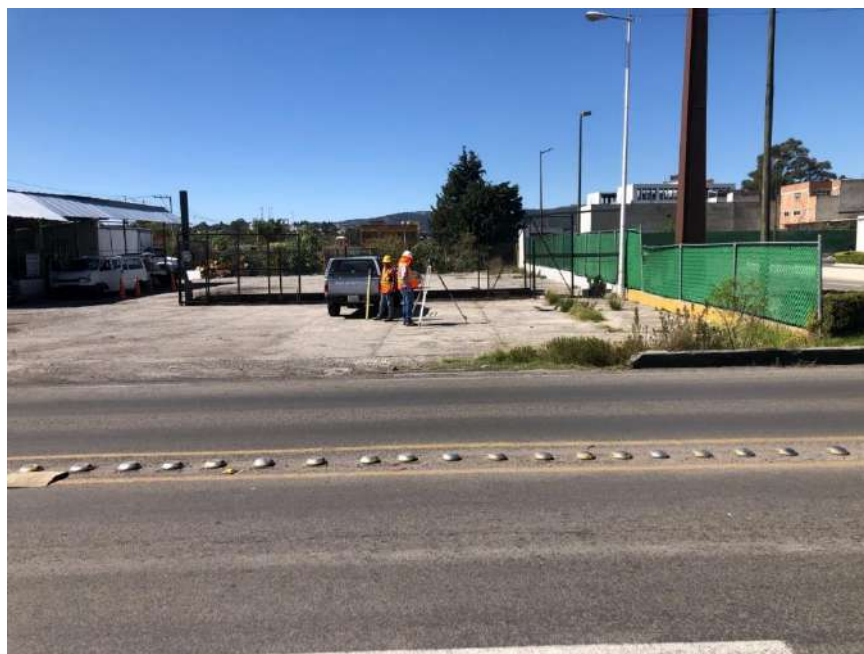
Figura 4.30 Preparación de equipo topográfico. Fuente propia.
