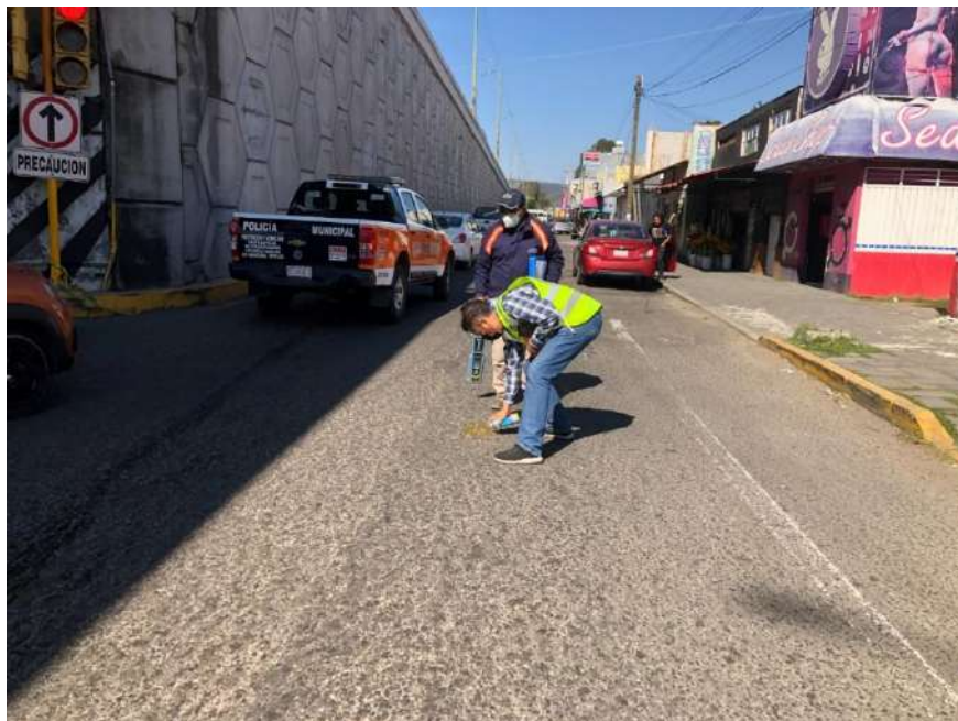
Figura 4.33 Replanteo de cruce a nivel. Fuente propia.
