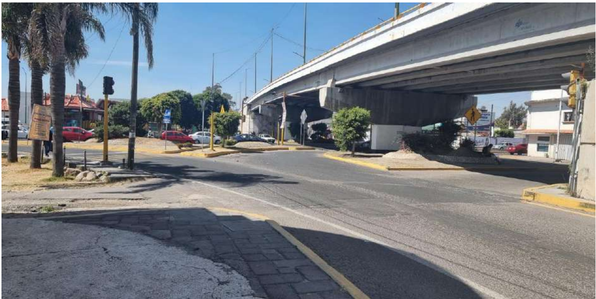
Figura 4.4 Estructura existente. Fuente propia
