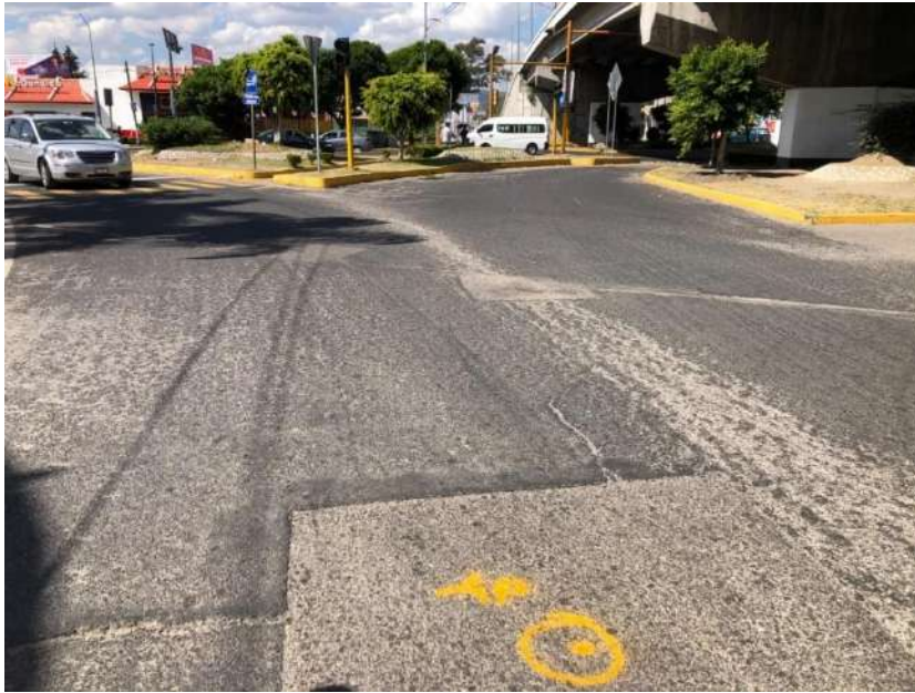
Figura 4.31 Replanteo de puntos clave. Fuente propia.
