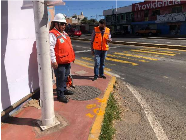
Figura 4.26 Localización de registro de CFE. Fuente propia.
