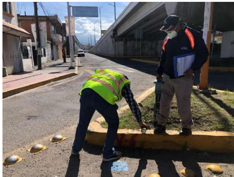
Figura 4.32 Verificación de referencia de trazo. Fuente propia.
